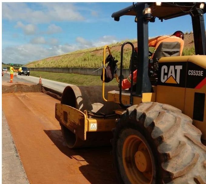
Figura 7 – Selando o subleito
