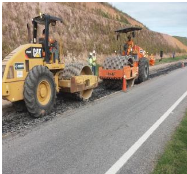
Figura 10 – Compactação da 1 camada
