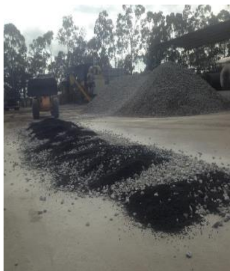
Figura 4 – Espalhamento do SPV 12,5 mm
