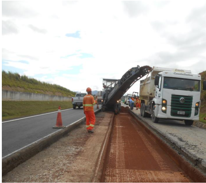
Figura 6 – Fresagem da base / sub-base
