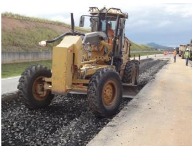
Figura 9 – Nivelamento da camada
