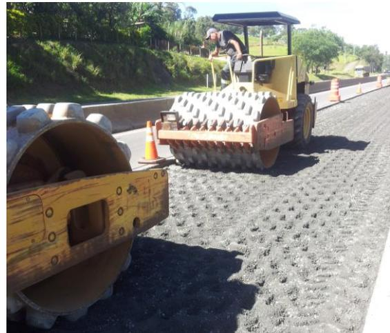
(iv) Execução das camadas de pavimento tipo do remendo profundo
