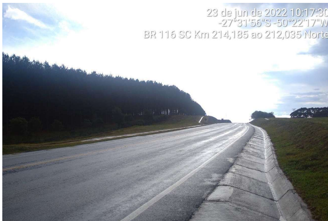
FIGURA 10-25 – DISPOSITIVO DE DRENAGEM
