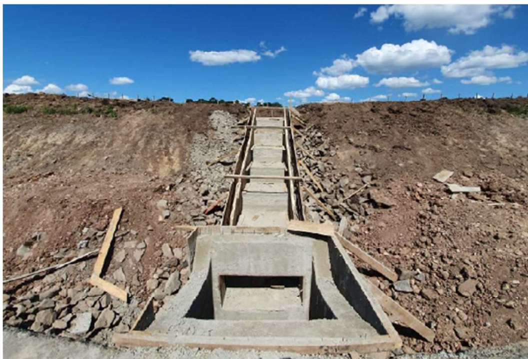
FIGURA 10-3 – EXECUÇÃO DE DAD-04 – Km 212+270
