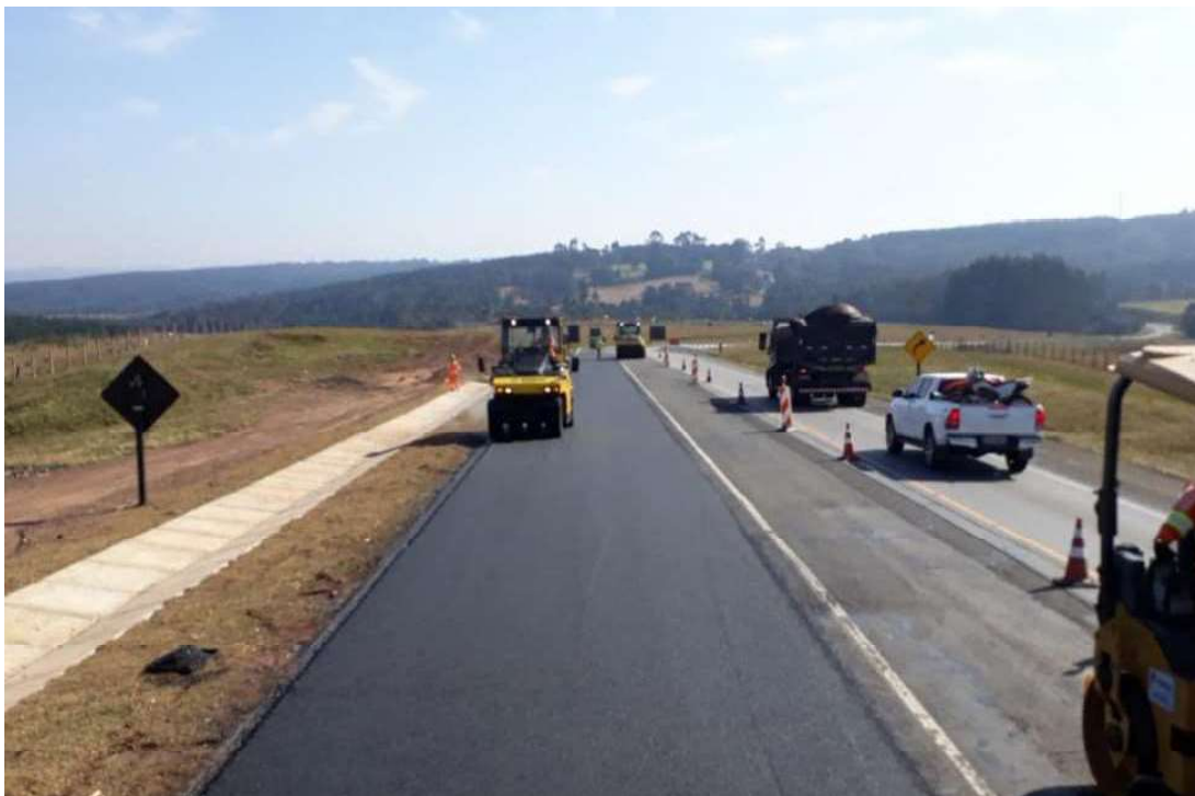
FIGURA 10.6 – APLICAÇÃO DE CBUQ – KM 211+428
