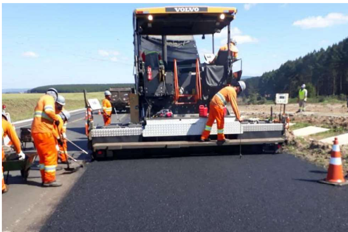
FIGURA 10.9 – APLICAÇÃO DE CBUQ – KM 212+926
