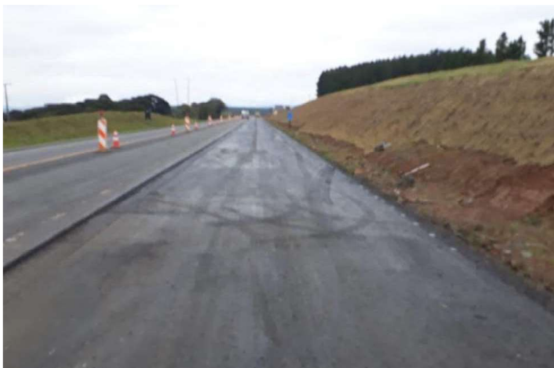
FIGURA 10.8 – IMPRIMADURA COM LIGANTE – KM 212+926
