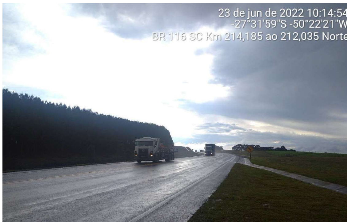
FIGURA 10-19 – DISPOSITIVO DE DRENAGEM E SINALIZAÇÃO VERTICAL
