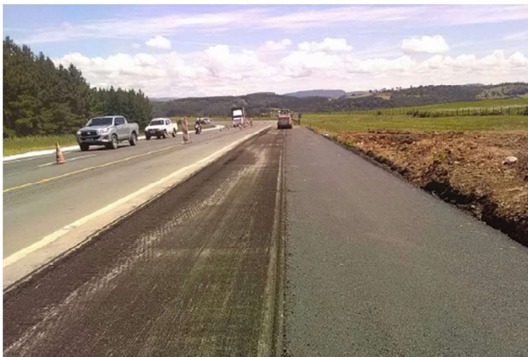
FIGURA 10-15 - IMPRIMADURA IMPERMEABILIZANTE - KM 212+120
