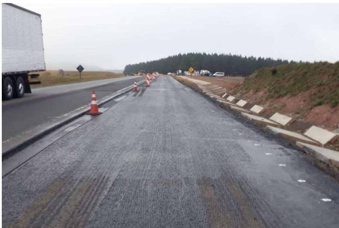
FIGURA 10.11 – IMPRIMADURA COM LIGANTE – Km 211+402
