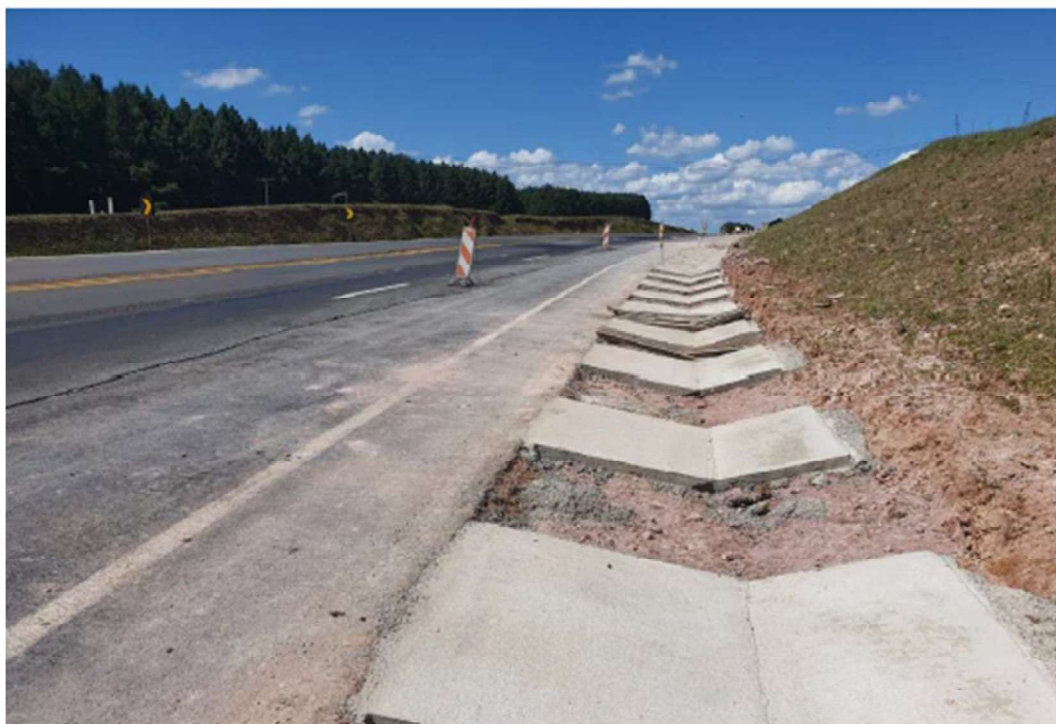
FIGURA 10-4 – EXECUÇÃO DE STC-01 – Km 214+080
