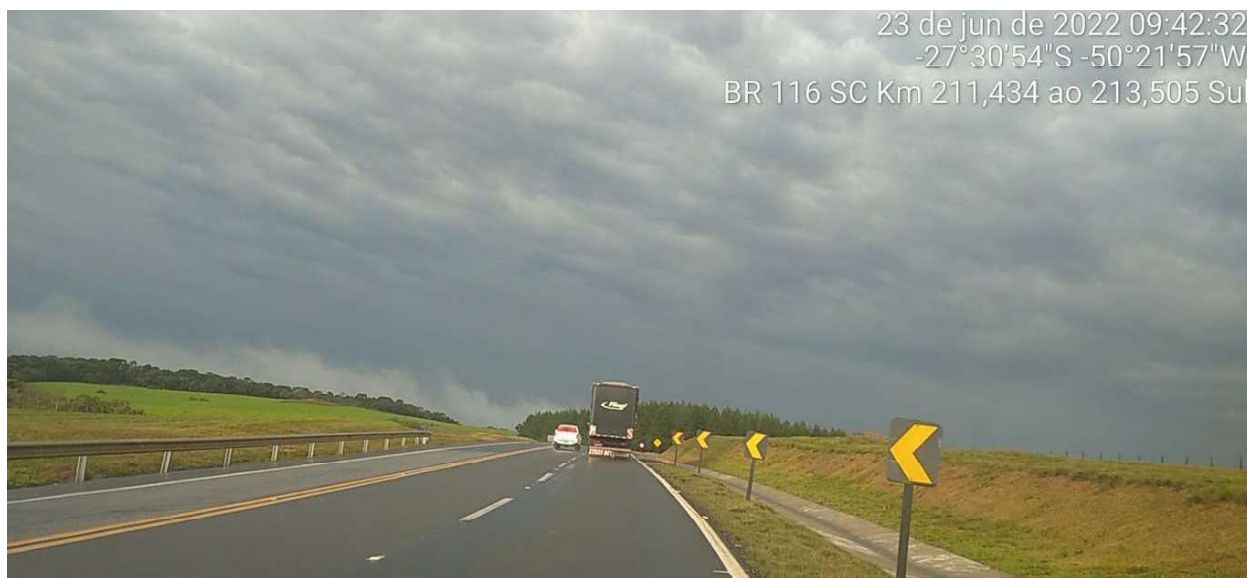
FIGURA 10.17 - SINALIZAÇÃO VERTICAL E HORIZONTAL E DISPOSITIVO DE DRENAGEM
