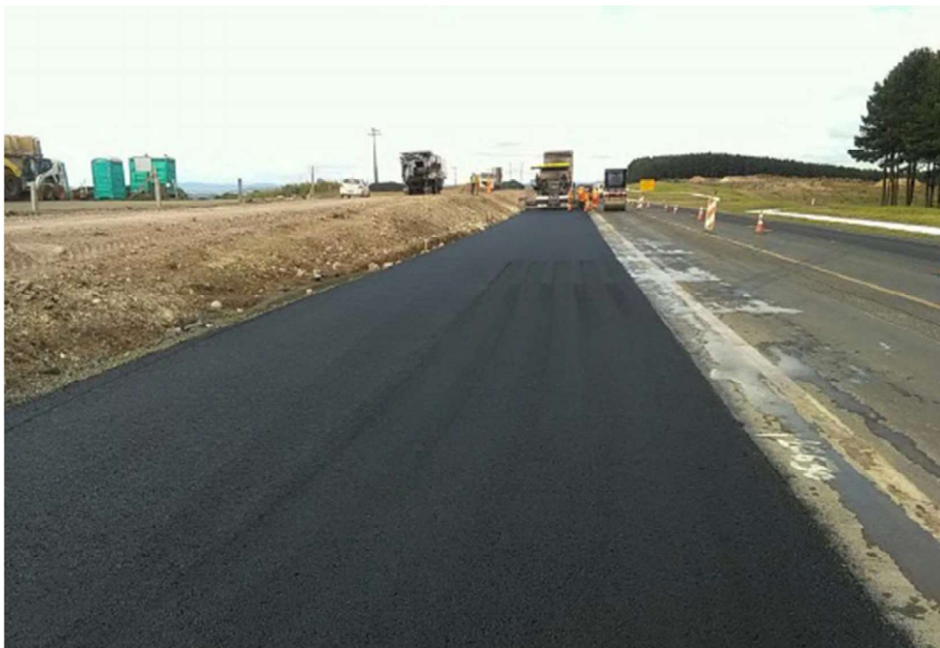
FIGURA 10-17 - APLICAÇÃO DE CBUQ - KM 212+600
