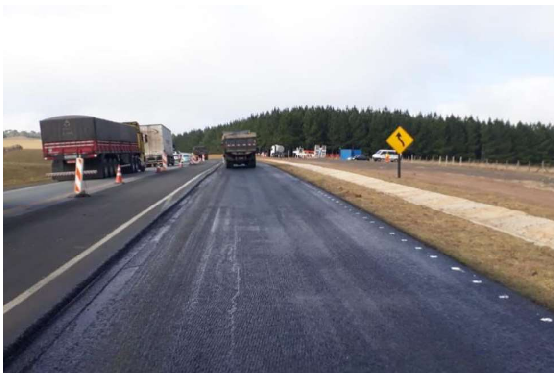
FIGURA 10.12 – IMPRIMADURA COM LIGANTE – Km 211+560
