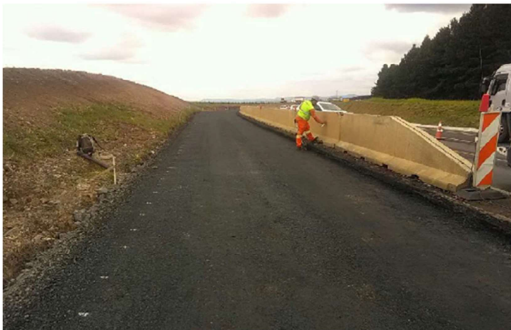
FIGURA 10-13 – IMPRIMADURA IMPERMEABILIZANTE - KM 213+100
