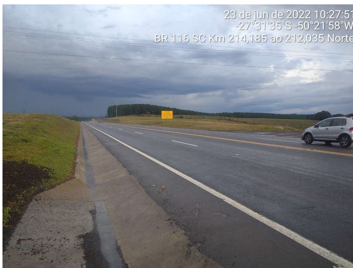
FIGURA 10-28 – DISPOSITIVO DE DRENAGEM
