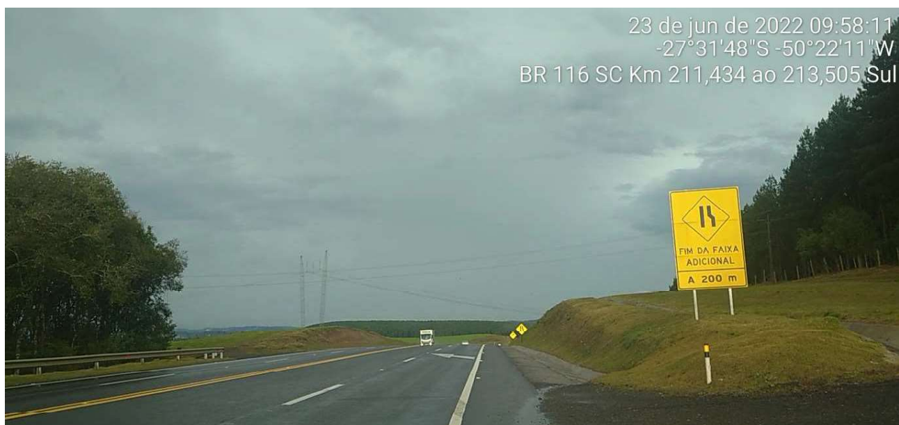
FIGURA 10.20 - SINALIZAÇÃO VERTICAL E HORIZONTAL E DISPOSITIVO DE DRENAGEM
