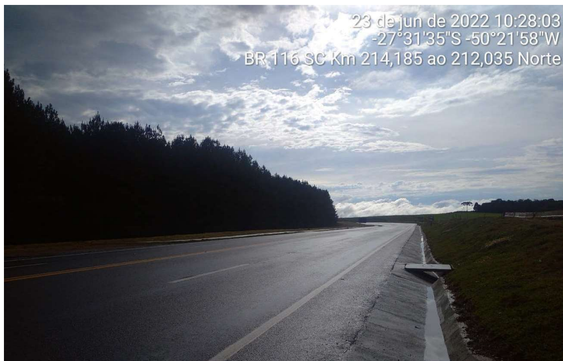
FIGURA 10-29 – DISPOSITIVO DE DRENAGEM
