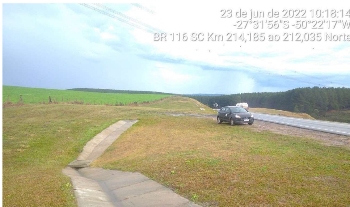
FIGURA 10-27 – DISPOSITIVO DE DRENAGEM
