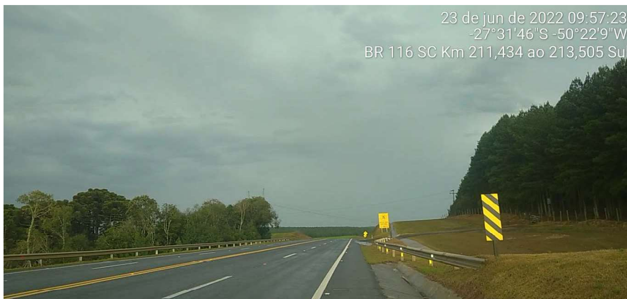
FIGURA 10.19 - SINALIZAÇÃO VERTICAL E HORIZONTAL E DISPOSITIVO DE DRENAGEM
