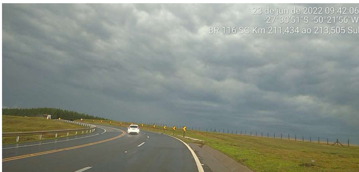
FIGURA 10.16 - SINALIZAÇÃO VERTICAL E HORIZONTAL E DISPOSITIVO DE DRENAGEM
