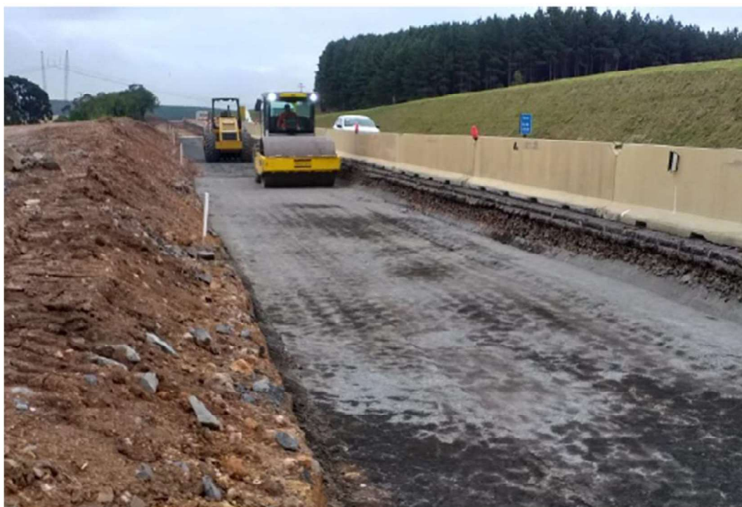
FIGURA 10-9 – RACHÃO TRAVADO– KM 213+000
