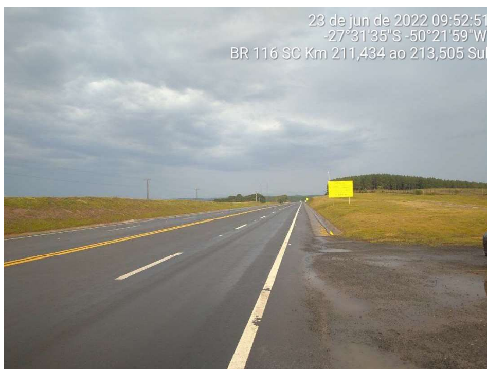
FIGURA 10.14 – SINALIZAÇÃO VERTICAL E HORIZONTAL
