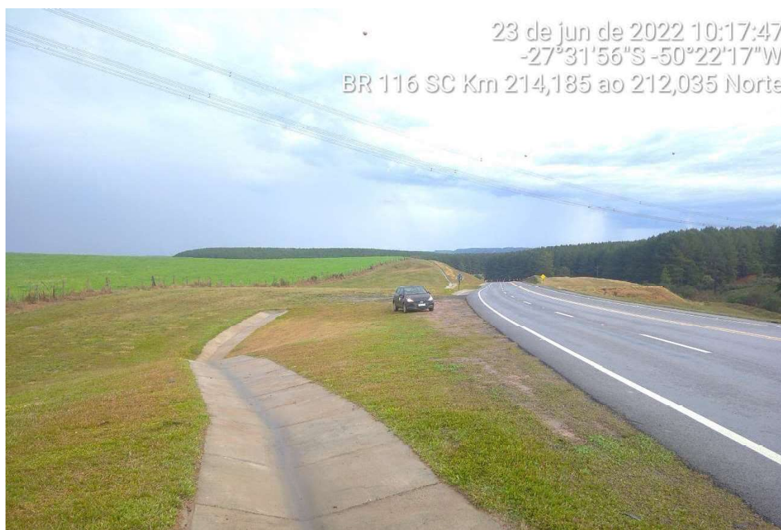
FIGURA 10-26 – DISPOSITIVO DE DRENAGEM
