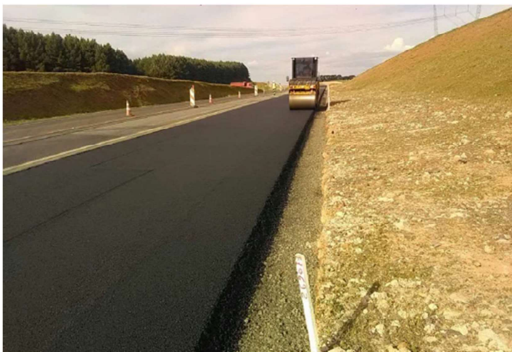
FIGURA 10-16 - APLICAÇÃO DE CBUQ– KM 213+840
