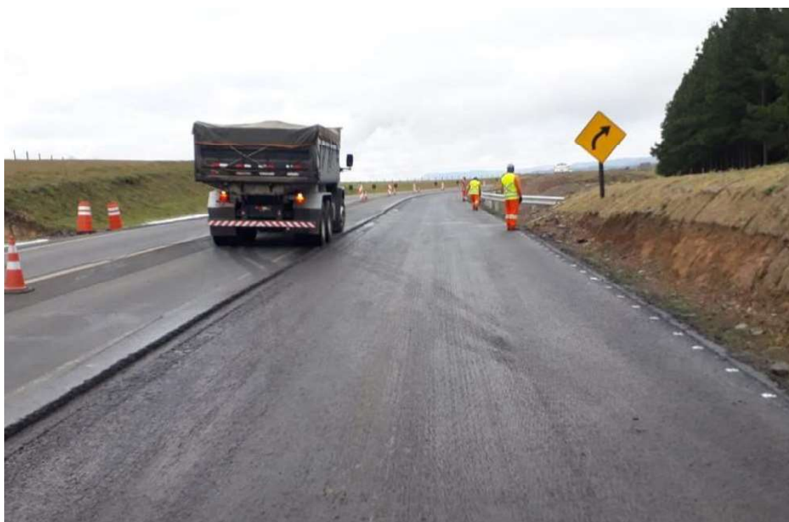
FIGURA 10.10 – IMPRIMADURA COM LIGANTE – KM 212+224
