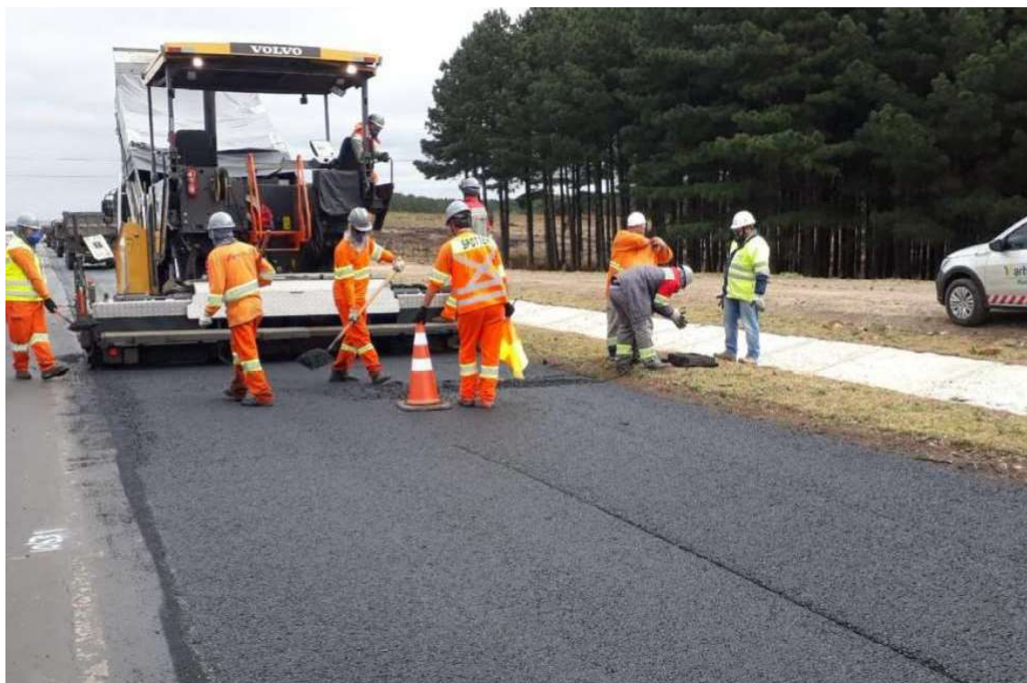
FIGURA 10.7 – APLICAÇÃO DE CBUQ – KM 212+224
