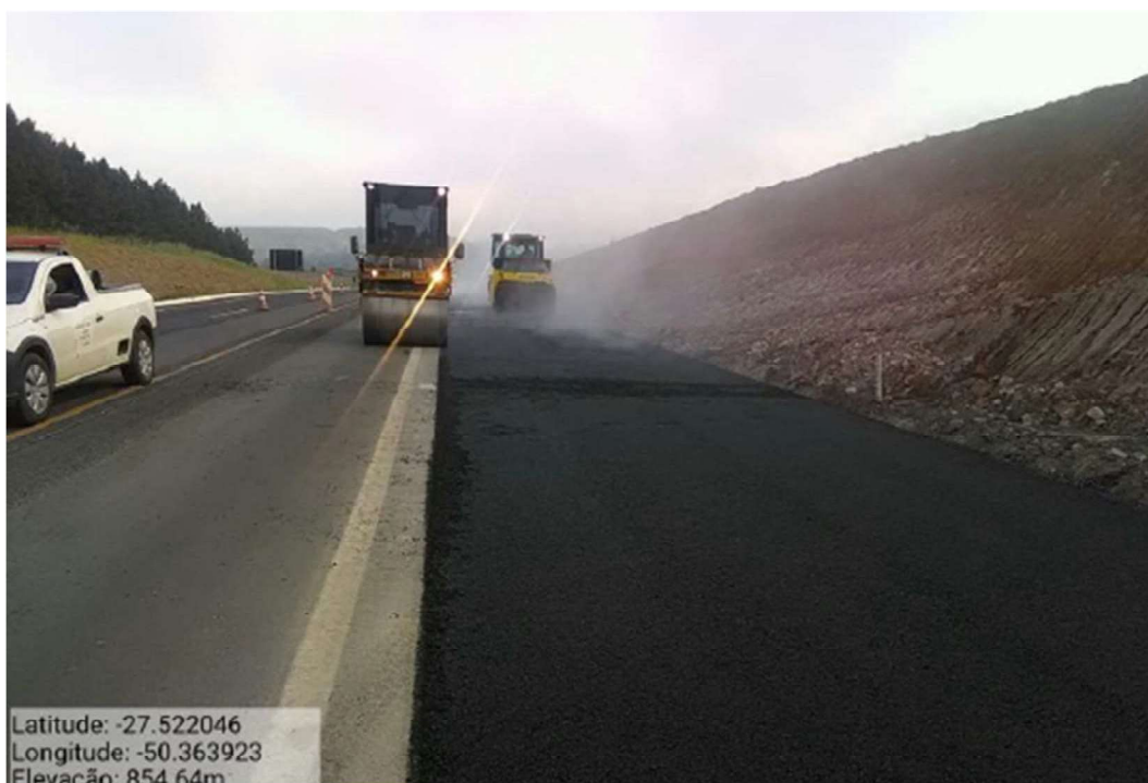
FIGURA 10-18 - APLICAÇÃO DE CBUQ— KM 212+160
