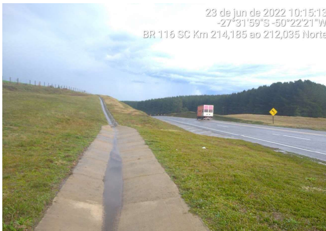
FIGURA 10-21 – DISPOSITIVO DE DRENAGEM
