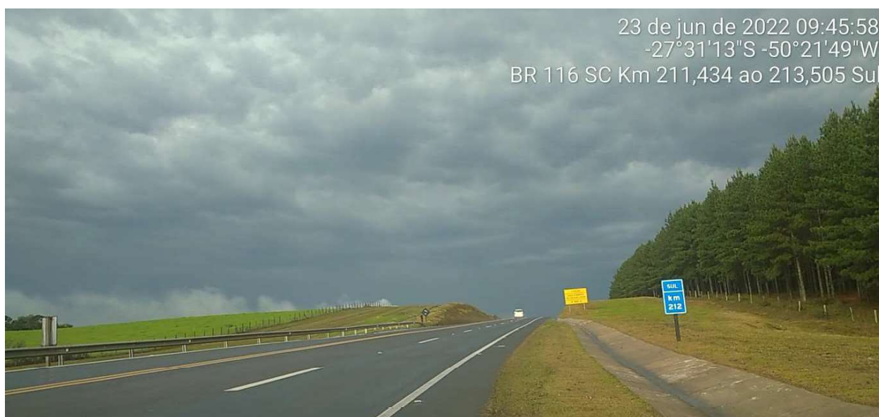
FIGURA 10.18 - SINALIZAÇÃO VERTICAL E HORIZONTAL E DISPOSITIVO DE DRENAGEM
