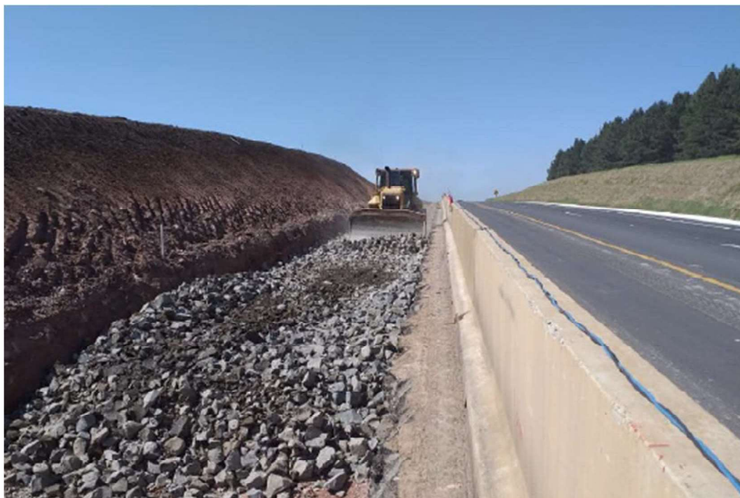
FIGURA 10-12 – APLICAÇÃO DE RACHÃO— KM 212+300
