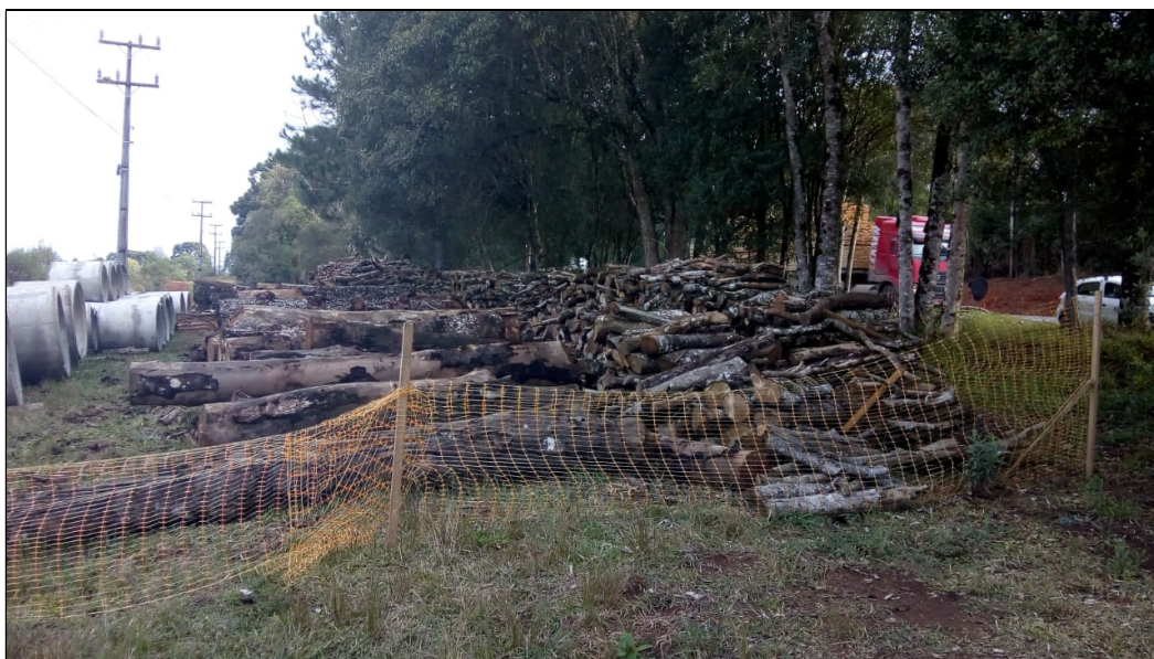
Foto 02 – Km 16+000 _ Desmatamento do terreno
