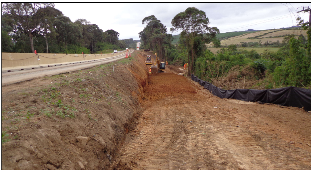
Foto 04 – Km 15+400 _ Compactação de Corpo de Aterro.
