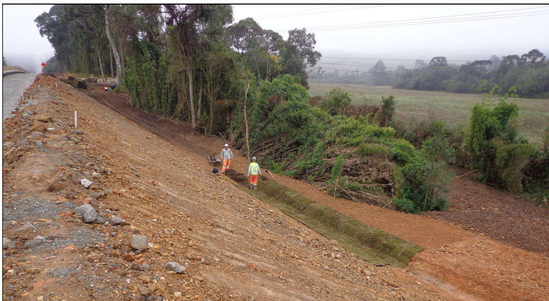
Foto 08 – Km 15+300 _ Execução de Drenagem Superficial – VPA-02
