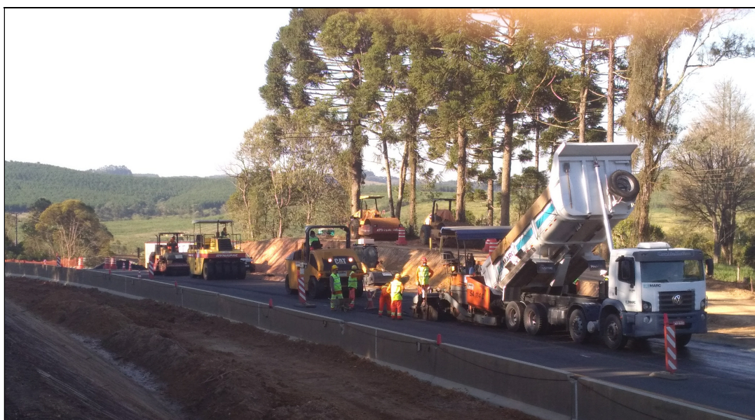
Foto 13 – Km 16+000 – Aplicação de massa asfáltica com CBUQ (SPV 19mm)
