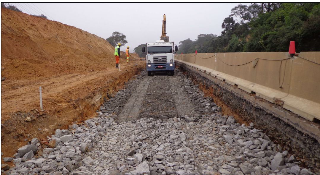
Foto 11 – Km 15+640 – Execução de Sub-Base com Macadame Seco.
