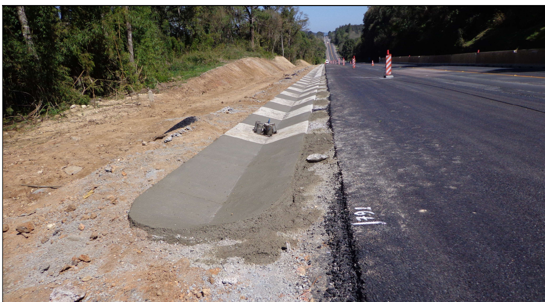
Foto 09 – Km 15+820 _ Execução de Drenagem Superficial – STC 09 (Transpassável)
