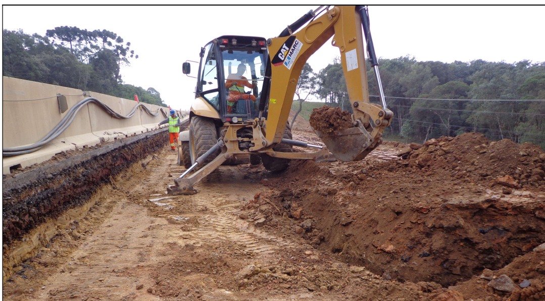
Foto 07 – Km 16+000 _ Execução de Drenagem Profunda – DPS-08
