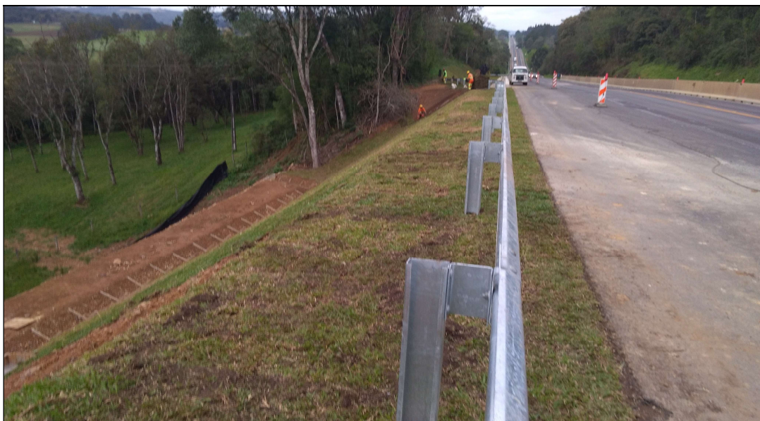
Foto 14 – Km 15+800 _ Execução de Paisagismo e Sinalização Viária – Plantio Gramas / Defesa Metálica
