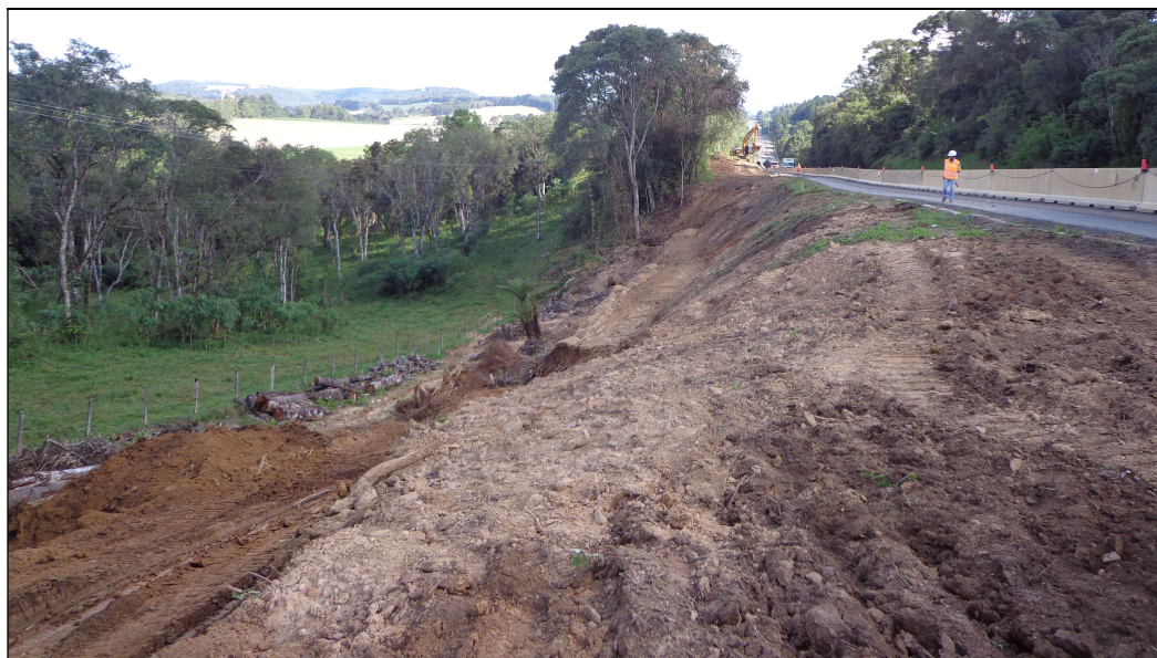
Foto 01 – Km 15+500 _ Limpeza do terreno
