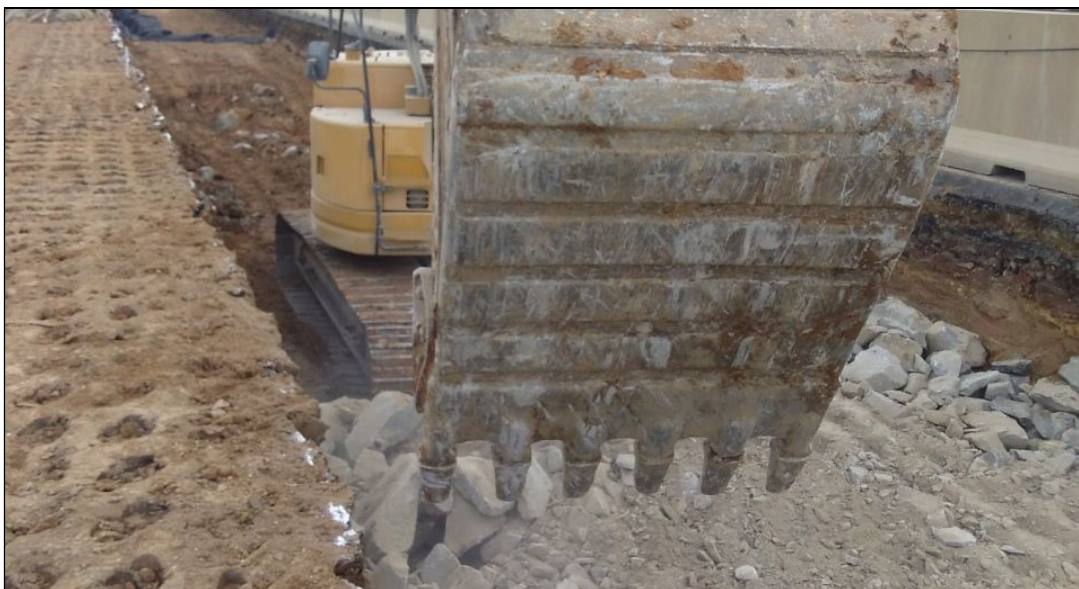
Foto 10 – Km 15+700 – Execução de Reforço de Subleito com Saibro
