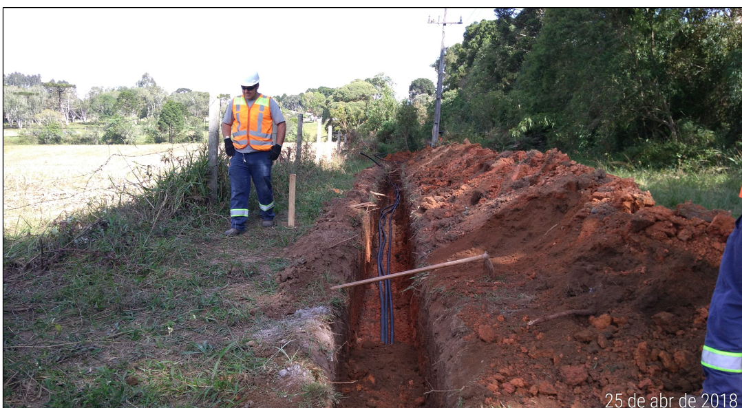
Foto 15 – Km 16+000 – Interferências – Remanejamento de Fibra Óptica.
