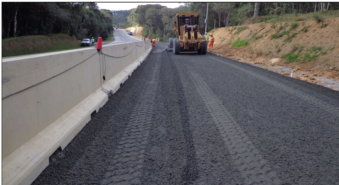
Foto 12 – Km 16+000 – Execução de Base com Brita Graduada Tratada com Cimento.
