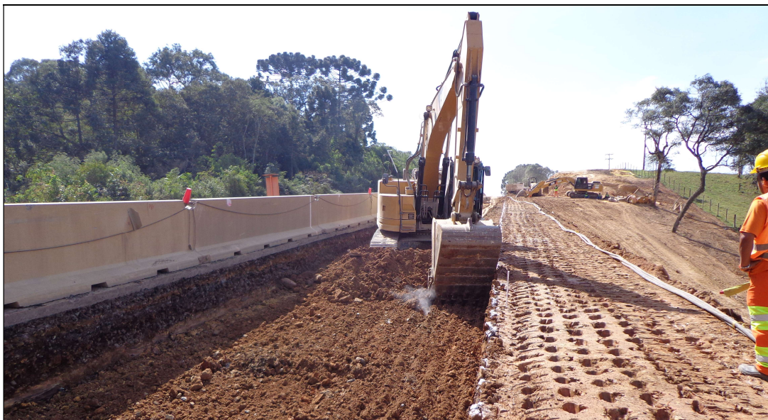
Foto 03 – Km 15+700 _ Escavação Material 1ª Categoria.
