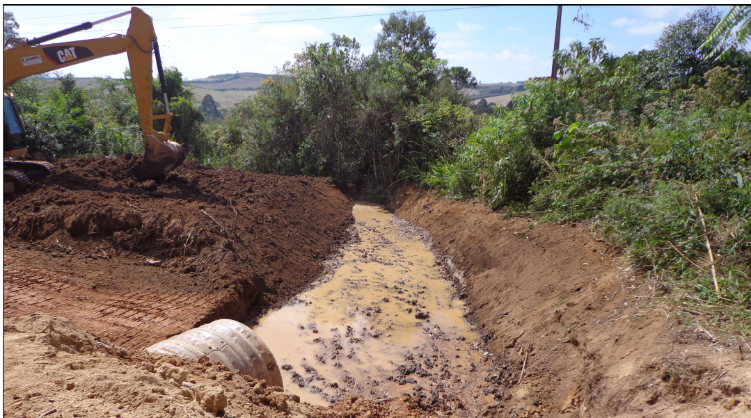
Foto 06 – Km 15+400 – (OAC -01) - Execução de Obras de Arte Corrente – BSTM
