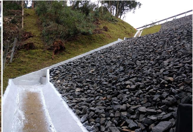
Figura 5.4 – Enrocamento e disp. De drenagem.
