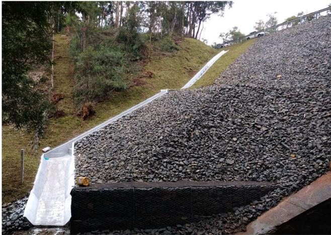
Figura 5.7 – Enrocamento, disp. Drenagem e gabião.
