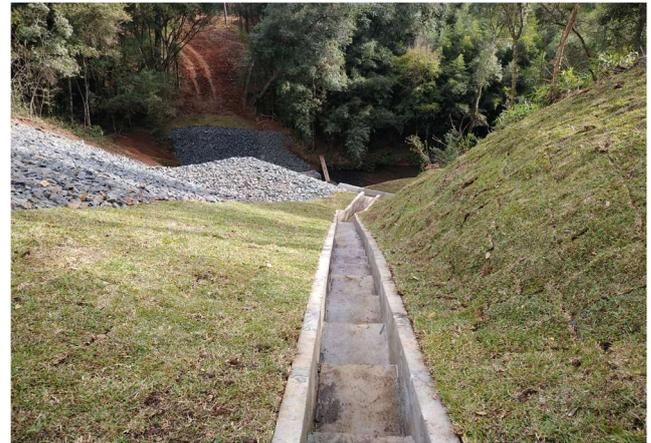
Figura 5.10 – Revegetação, disp. De drenagem.
