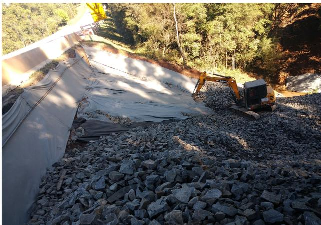
Figura 5.11 – Manta Geotêxtil
