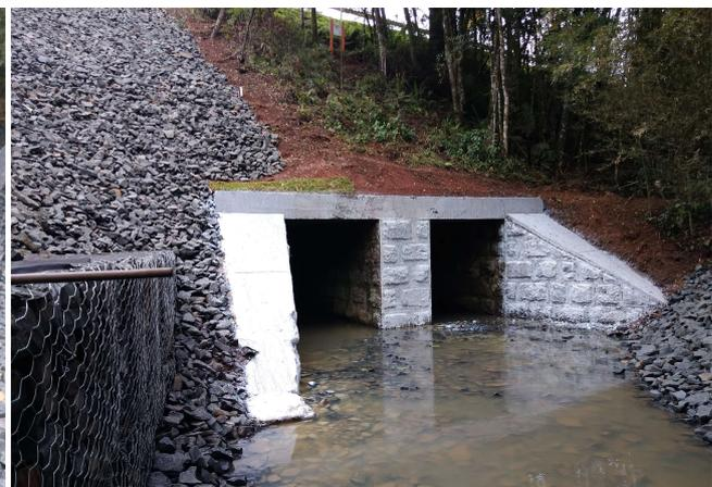
Figura 5.6 – Enrocamento e revitalização de galeria.
