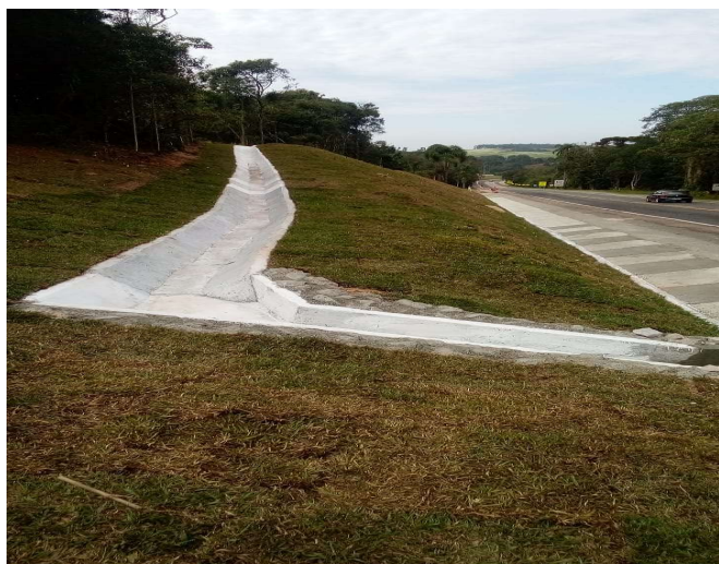
Figura 5.19 Sarjeta de crista e revegetação.
