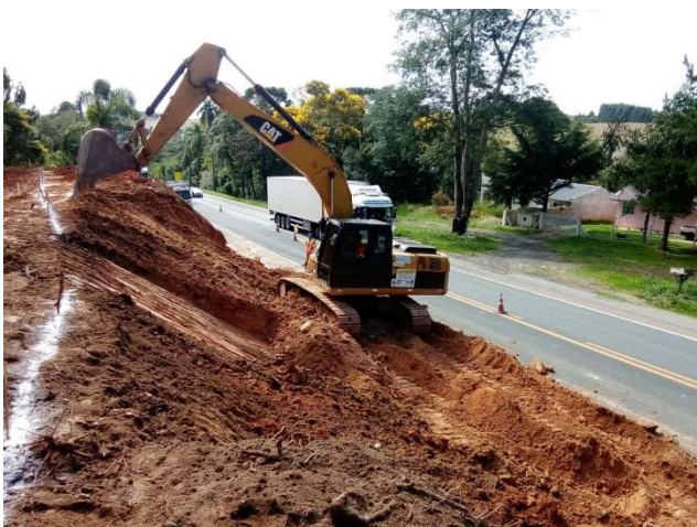
Figura 5.6 – Descarregamento do talude.
