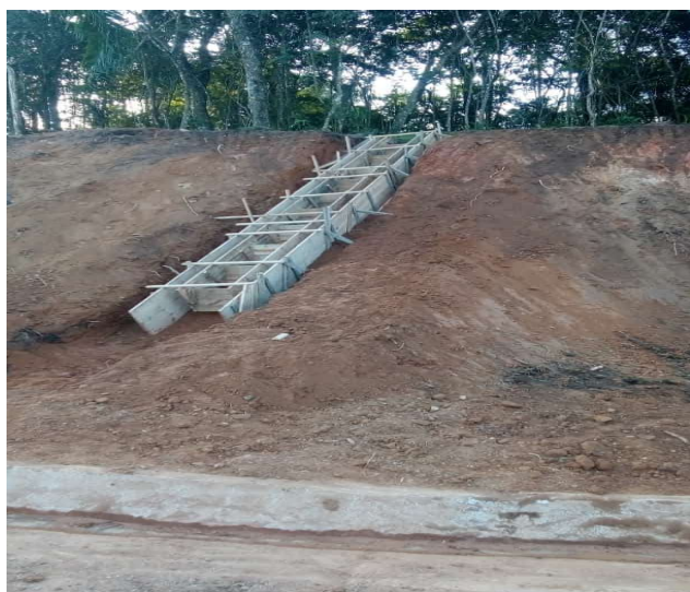
Figura 5.11 – Montagem da descida d'água
