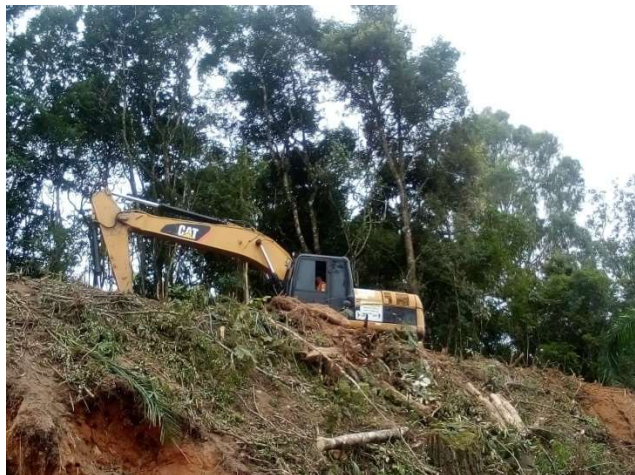
Figuras 5.1 – Início das escavações.
