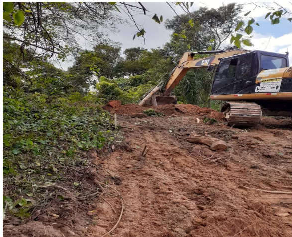
Figuras 5.2 – Início das escavações.
