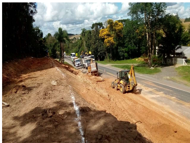
Figura 5.8 – Descarregamento do talude.
