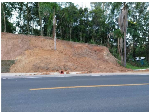
Figura 5.7 – Descarregamento do talude.
