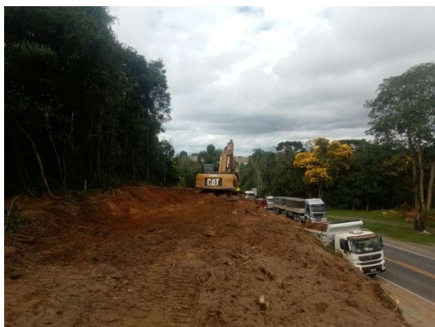
Figura 5.5 – Descarregamento do talude.
