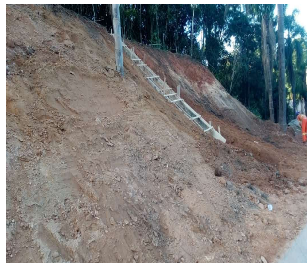
Figura 5.12 – Montagem da descida d'água.
