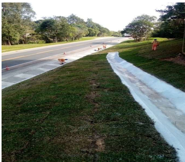
Figura 5.20 – Dispositivos de drenagem e revegetação.
