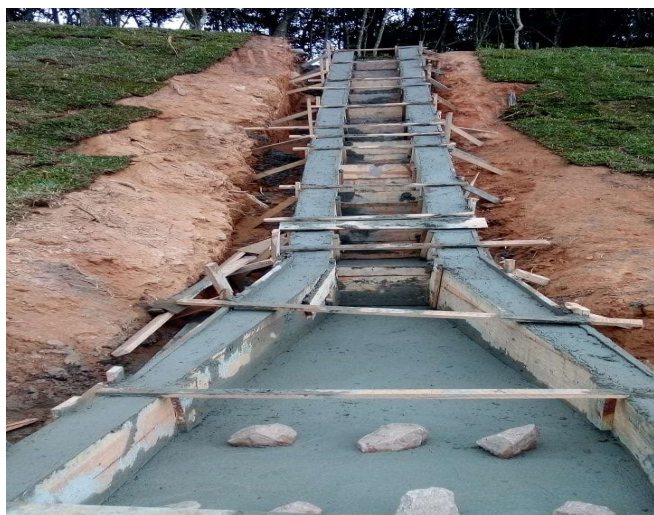
Figura 5.13 – DCD e dissipador de energia.
