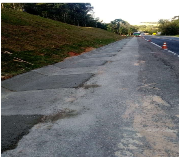
Figura 5.16 – Sarjetas e revegetação.
