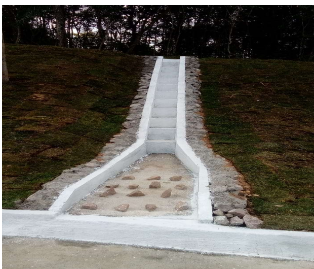
Figura 5.18 – Revegetação e dispositivos de drenagem.
