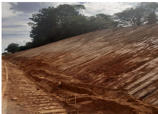
Figura 5.10 – Limpeza e escavações concluídas.
