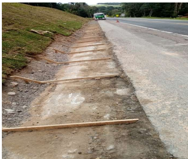
Figura 5.14 – Escavação das sarjetas.
