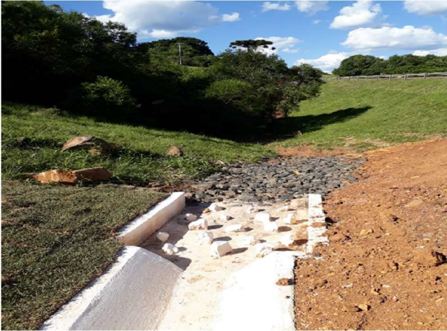
Figura 5.5 – Dissipador de Energia
