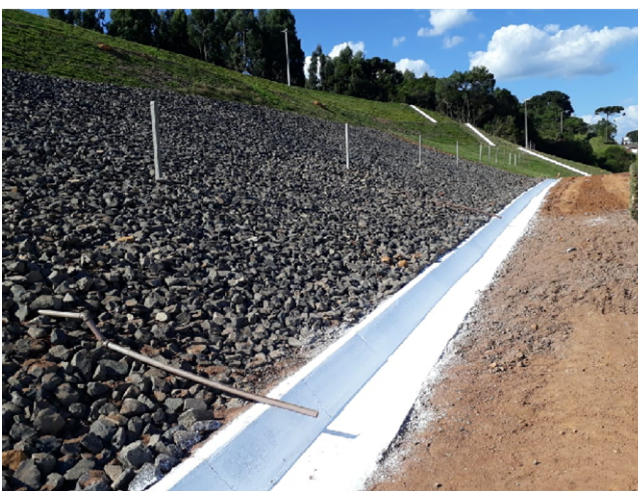
Figura 5.5 – Dreno profundo, enrocamento
