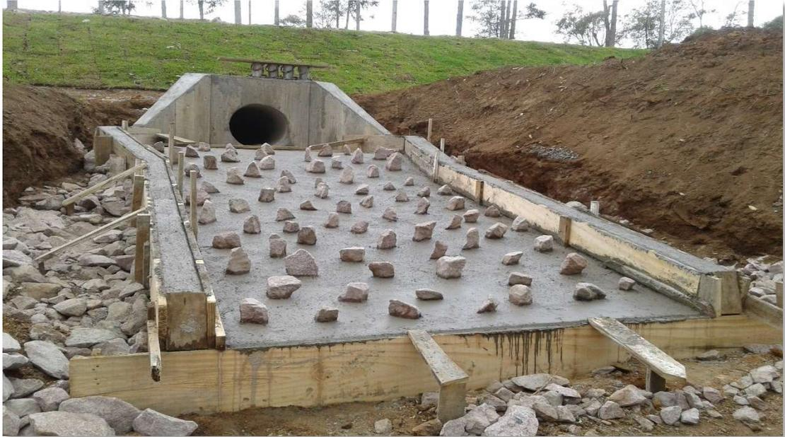
Figura 5.3.2 – Execução de drenagem e Obra de Arte Corrente
