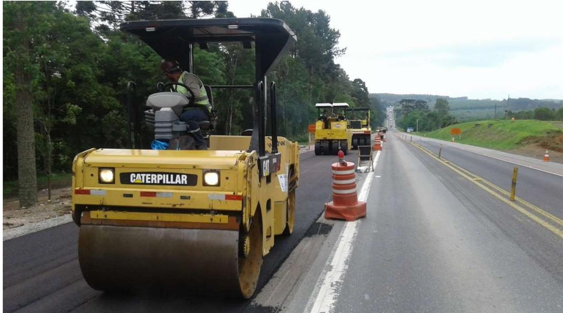
Figura 5.4.2 – Execução da Pavimentação
