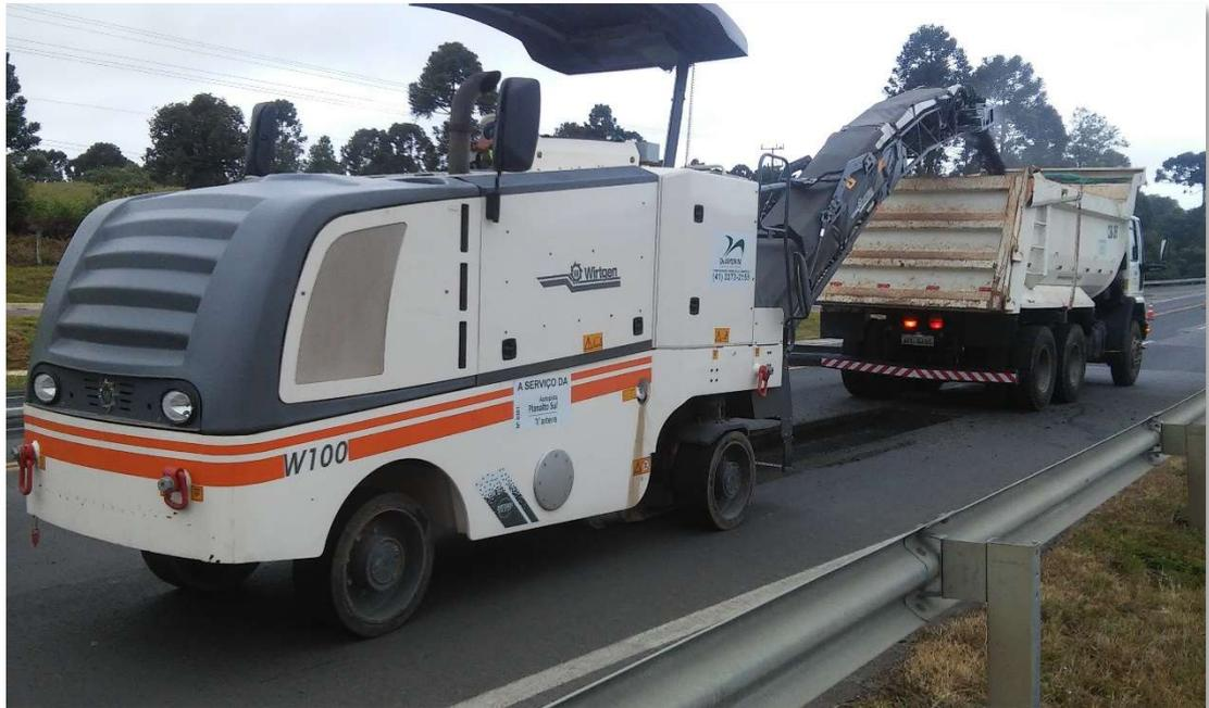
Figura 5.1.1 – Execução de Serviços Preliminares (Remoção mecanizada de revestimento betuminoso).
