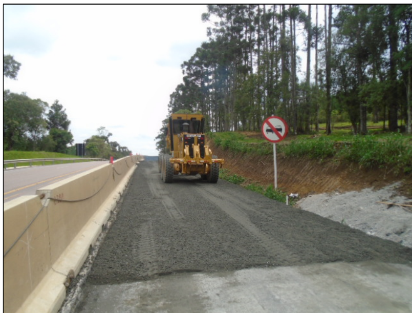
Foto 12 – Km 14+080 – Execução de Base com Brita Graduada Tratada com Cimento.
