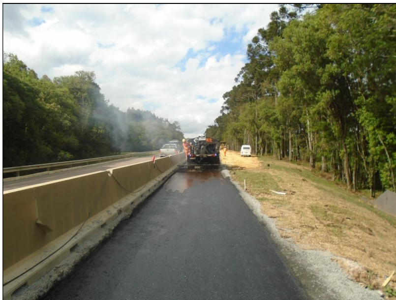
Foto 13 – Km 14+600 – Imprimação de Base com Brita Graduada Tratada com Cimento.
