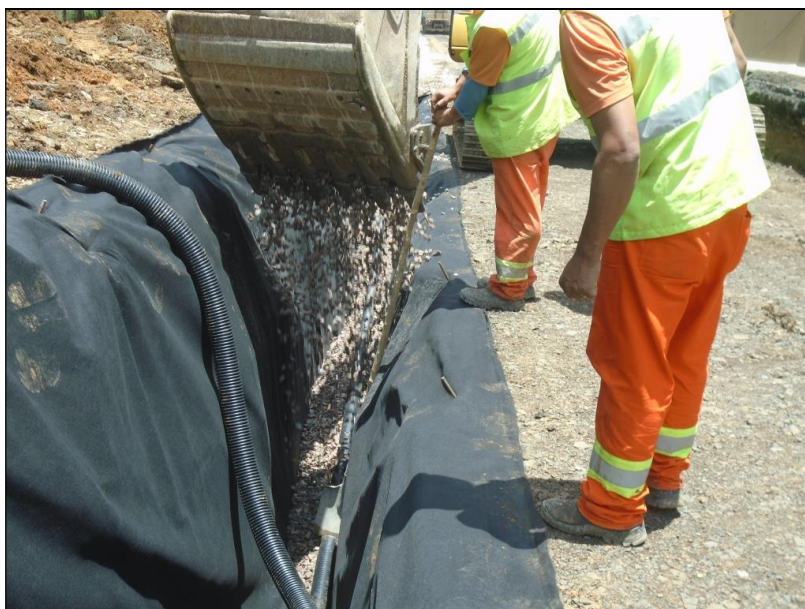
Foto 08 – Km 14+280 _ Execução de Drenagem Profunda - Dreno Tipo DPS-08
