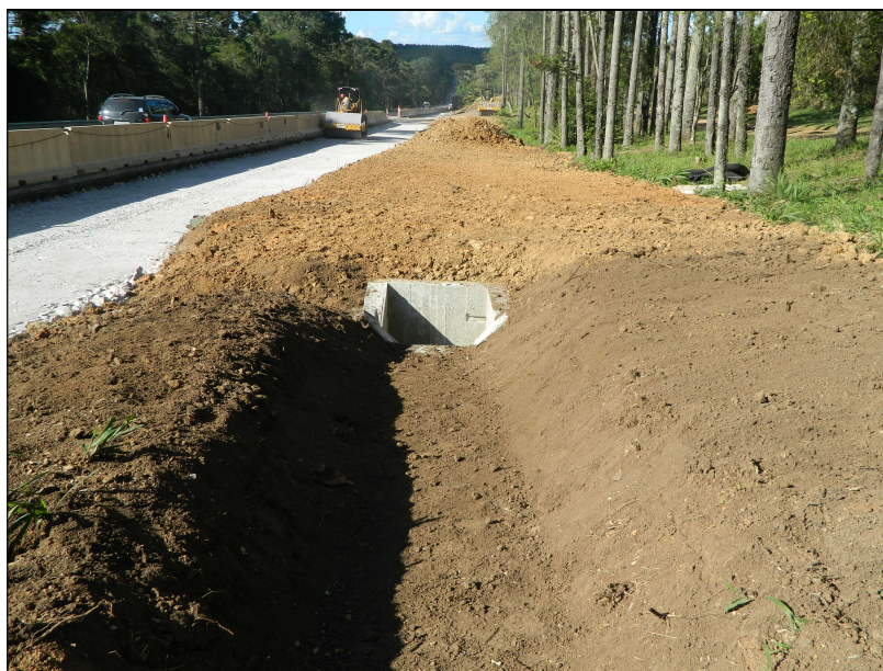
Foto 10 – Km 13+920 _ Execução de Drenagem Superficial - VPA 04 e CC
