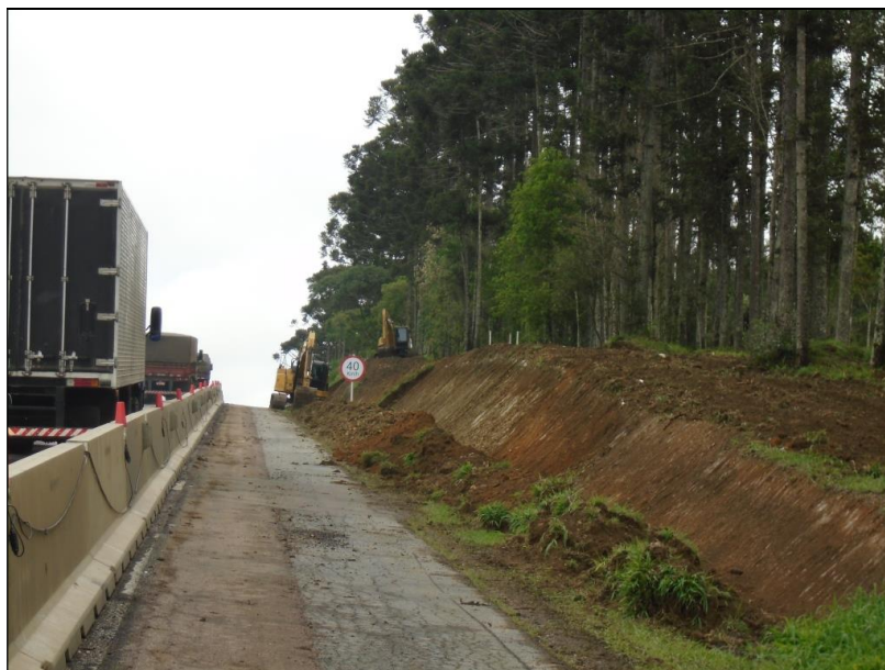
Foto 05 – Km 13+800 a Km 14+000 _ Regularização de Taludes – Cortes em Rampa
