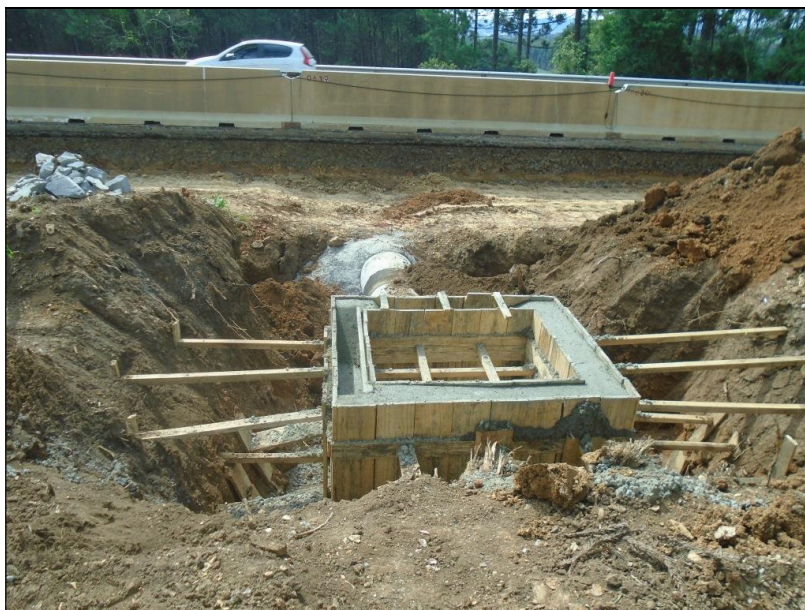
Foto 07 – Km 13+940 – (OAC -02) - Execução de Obras de Arte Corrente – BSTC e CC
