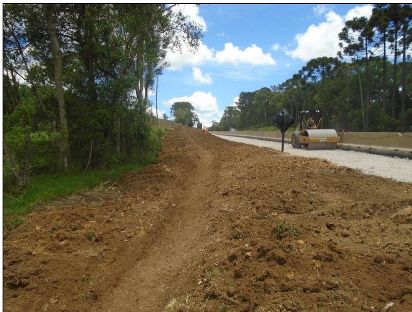
Foto 09 – Km 13+650 _ Execução de Drenagem Superficial - VPC 02
