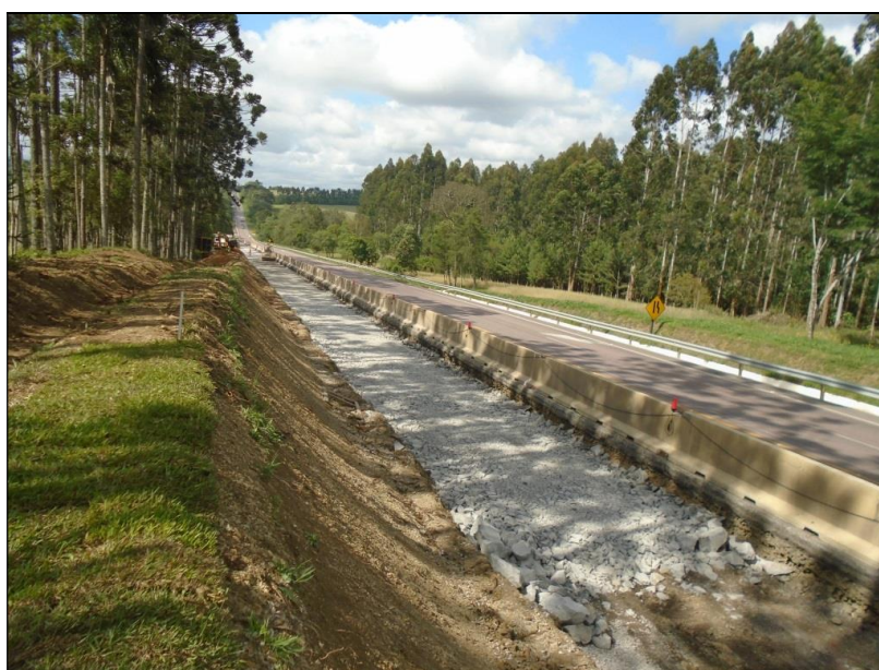
Foto 06 – Km 14+200 a Km 14+400 _ Execução de Reforço do Sub-leito
