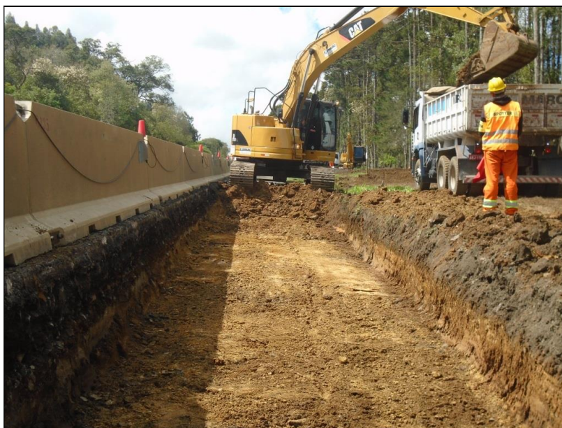
Foto 03 – Km 14+000 a Km 14+300_ Escavação, Carga e Transporte Material 1ª Categoria.
