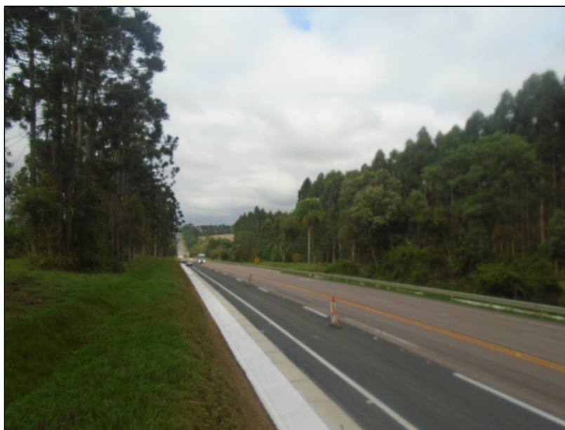
Foto 16 – Km 14+260 _ Execução de Sinalização Viária – Pintura de Faixa
