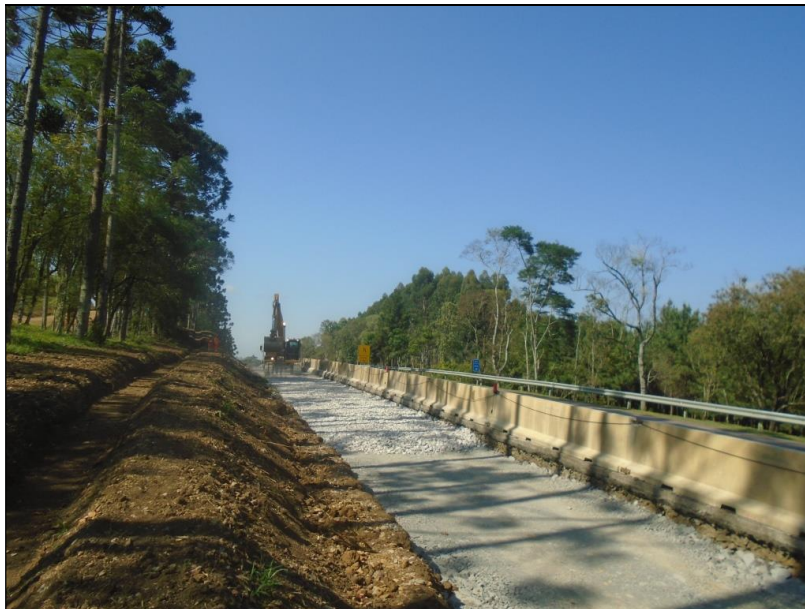
Foto 11 – Km 13+950 a Km 14+400 – Execução de Sub-Base com Macadame Seco
