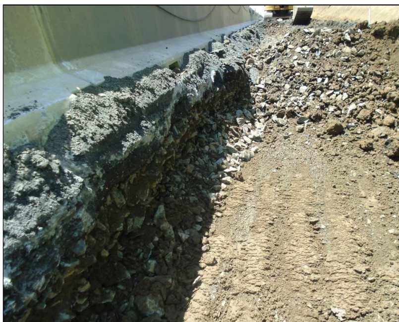
Foto 04 – Km 13+800 a Km 14+000 _ Escavação, Carga e Transporte para Reforço Subleito
