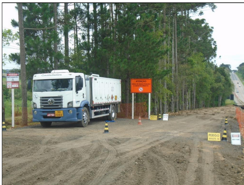
Foto 02 – Km 14+400 _ Canteiro de Obras – Área de Abastecimento
