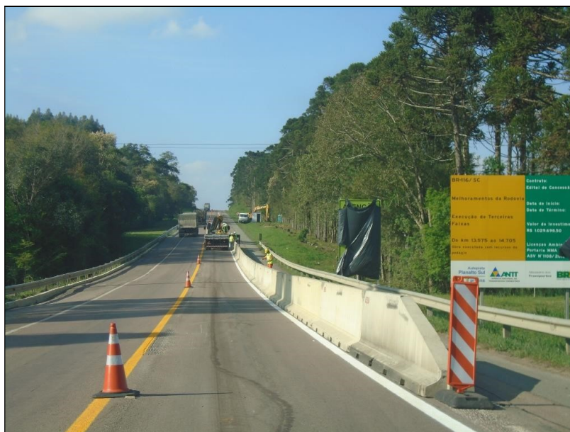
Foto 01 – Km 14+700 _ Implantação de Sinalização e Canteiro de Obras
