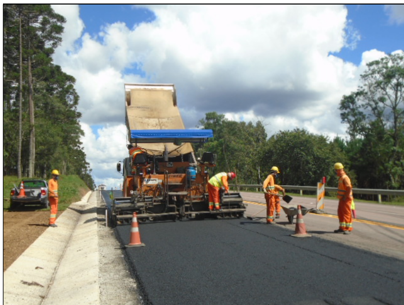
Foto 14 – Km 13+900 – Aplicação de Massa Asfáltica CBUQ.
