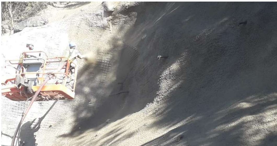
Figura 9 - Aplicação de Concreto Projetado
