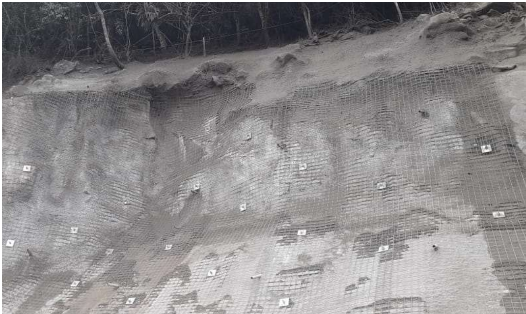
Figura 8 - Aplicação de Tela Metálica
