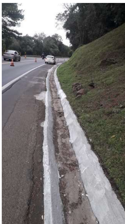
Figura 12 - Reforma e Caiação de Canaleta
