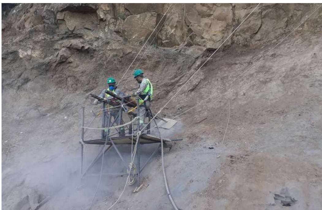
Figura 4 - Perfuração de Chumbadores
