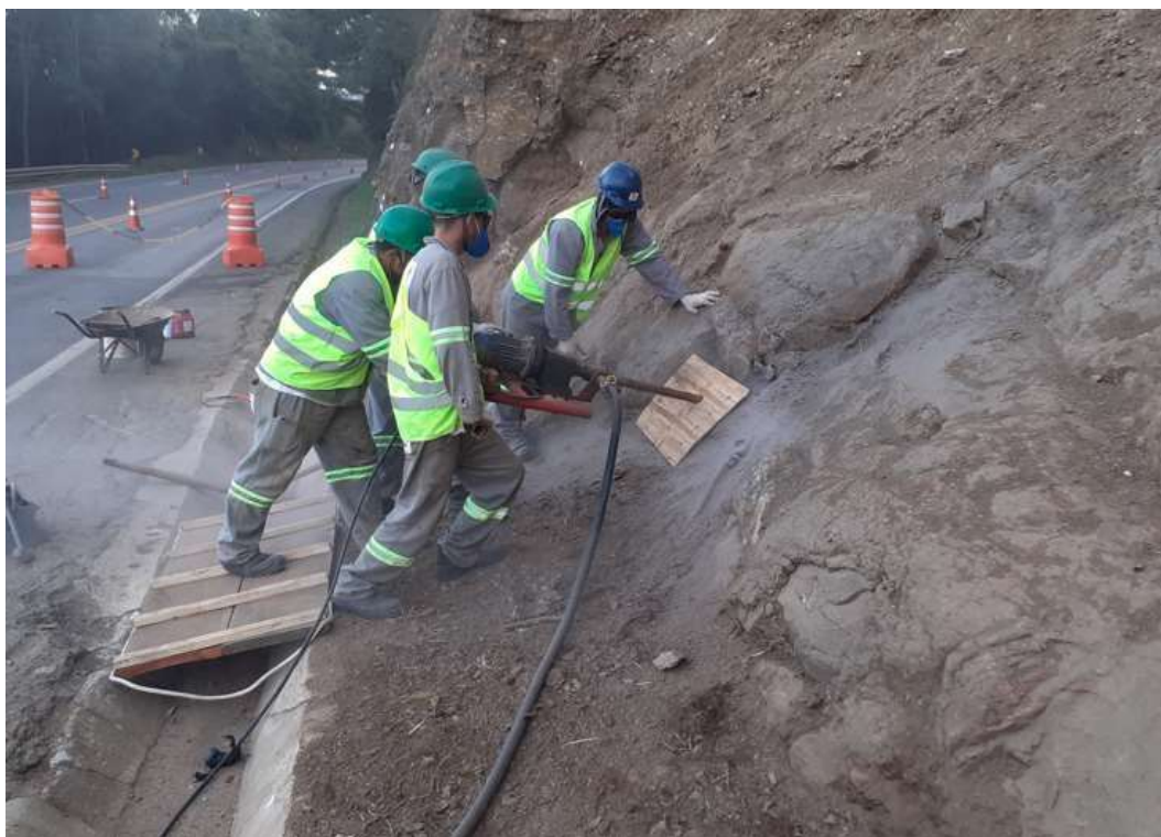
Figura 3 - Perfuração de Chumbadores
