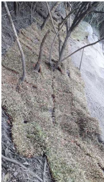
Figura 10 - Plantio de Grama na Crista do Talude
