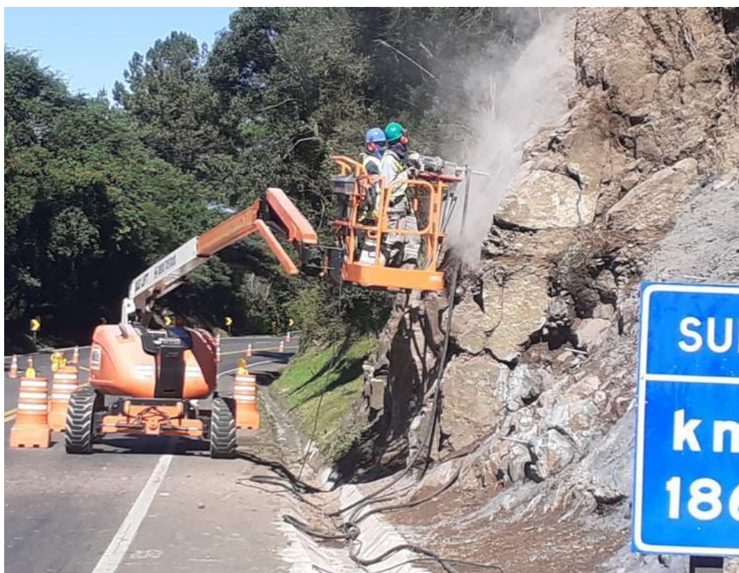
Figura 5 - Perfuração de Chumbadores
