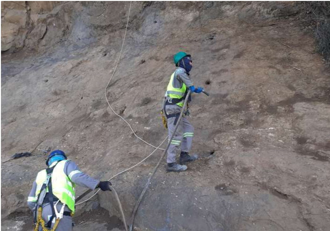
Figura 6 - Injeção dos Chumbadores
