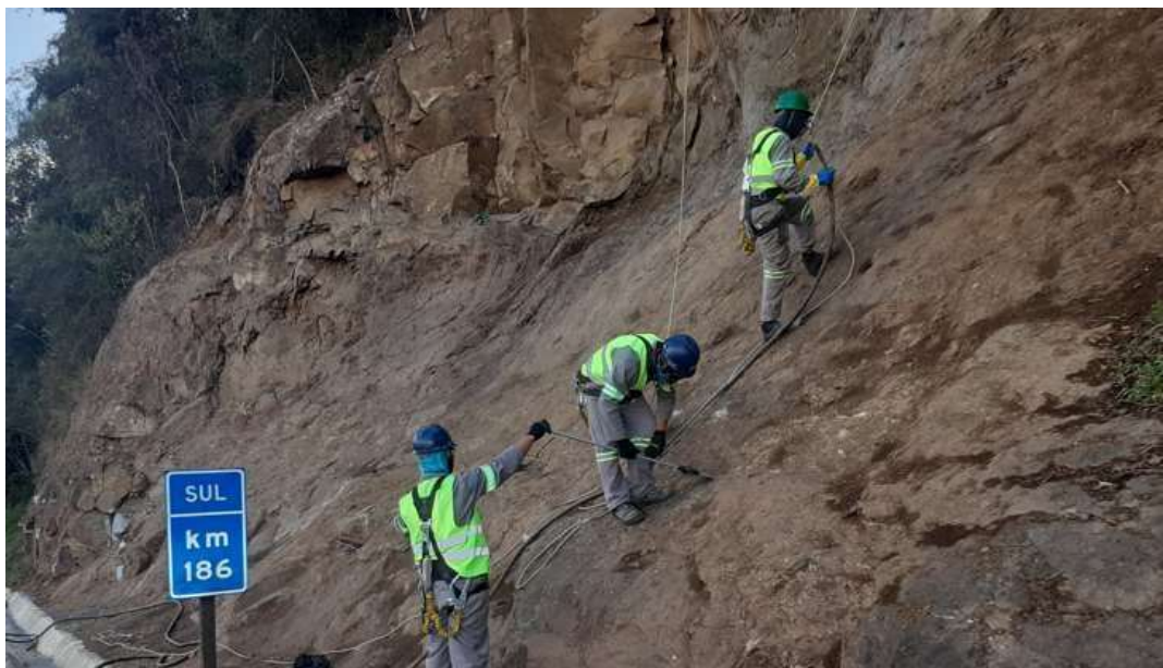
Figura 7 - Instalação do Chumbador
