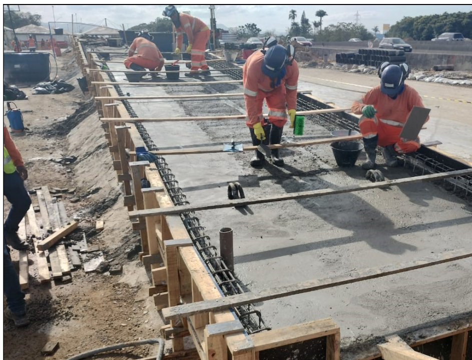
Figura 10: Concretagem das rampas da passarela.
