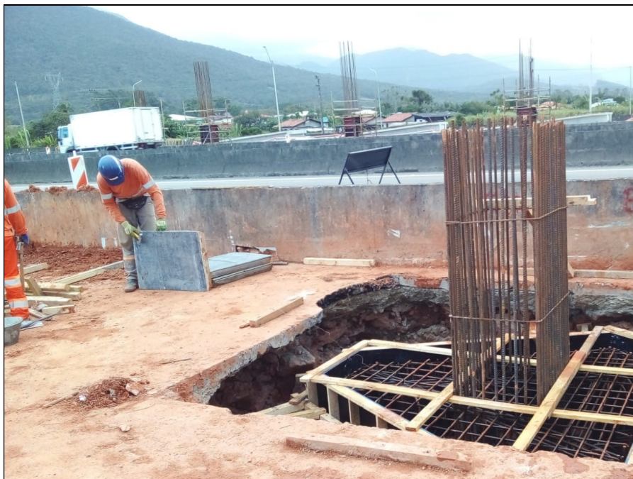
Figura 9: Execução da fundação da passarela.
