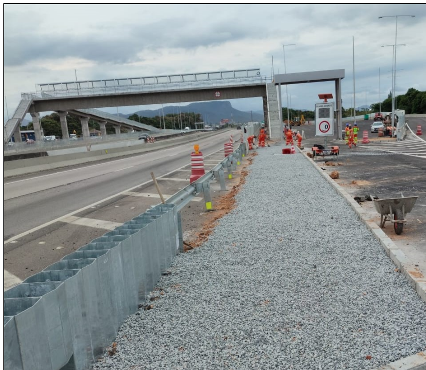
Figura 3: Execução do passeio.
