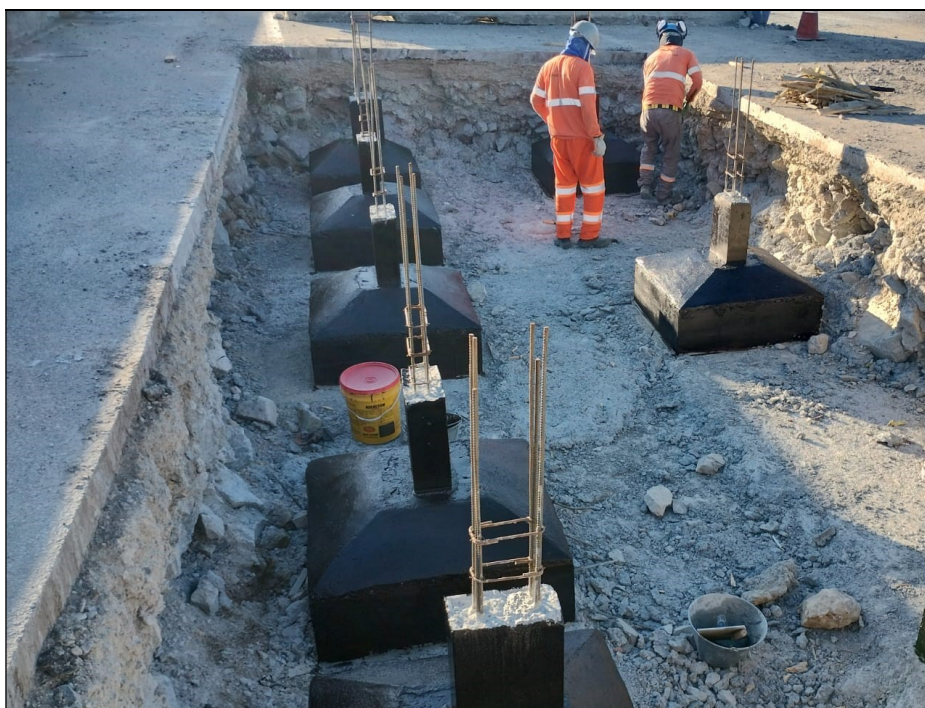
Figura 6: Execução da fundação do banheiro norte
