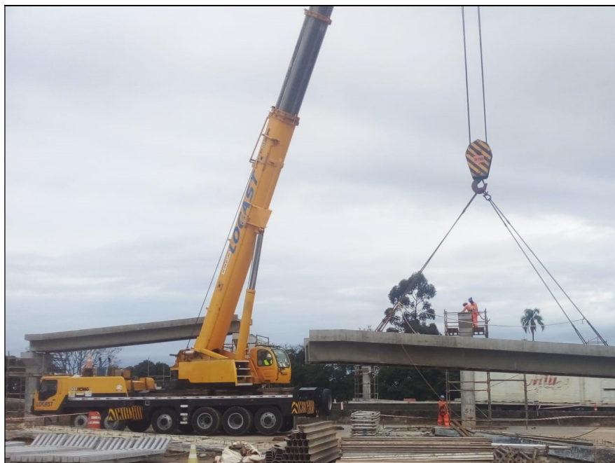
Figura 11: Içamento das rampas da passarela
