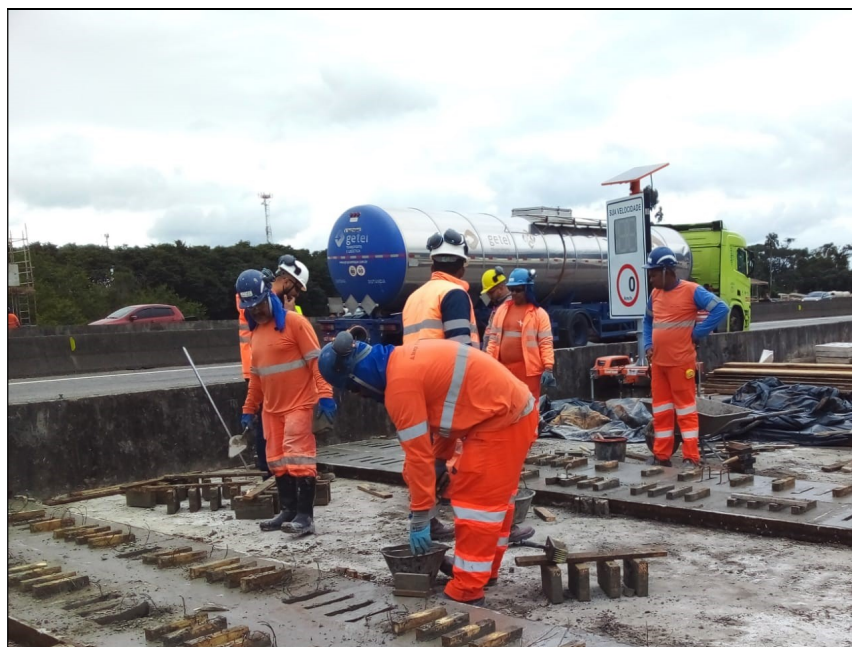
Figura 2: Concretagem das tampas das sarjetas.
