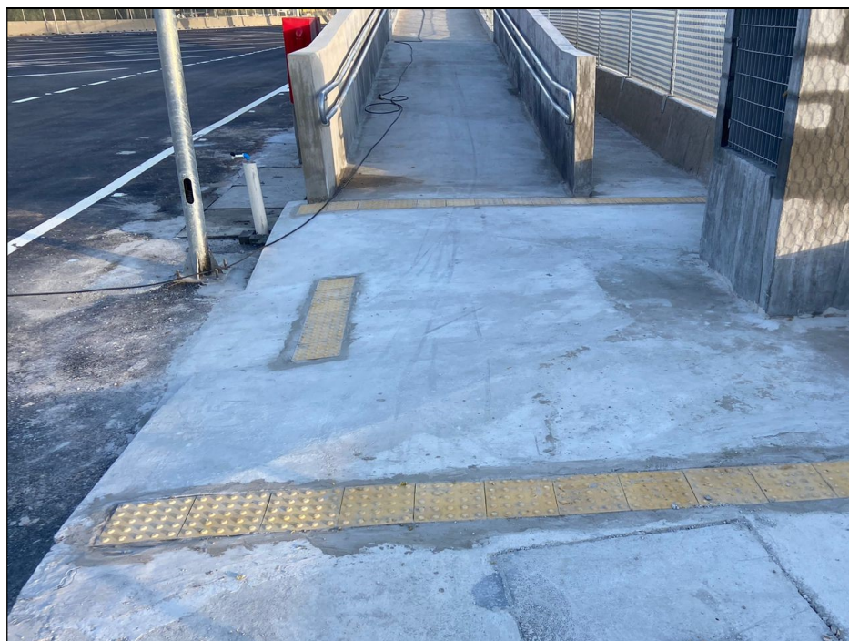
Figura 4: Piso podotátil no passeio.
