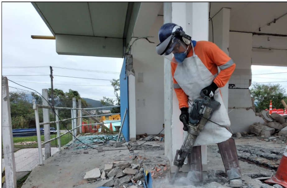
Figura 5: Demolição da estrutura pré-existente
