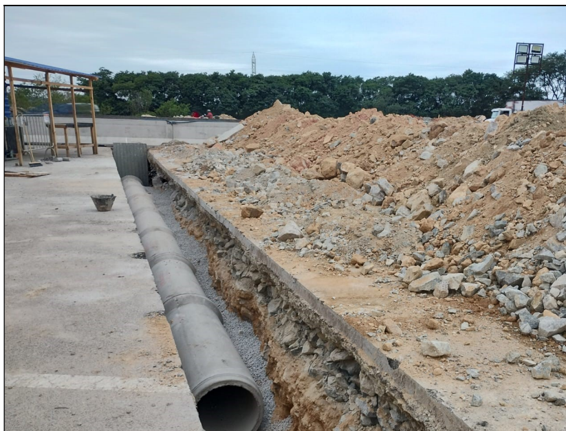
Figura 1: Execução de bueiro.
