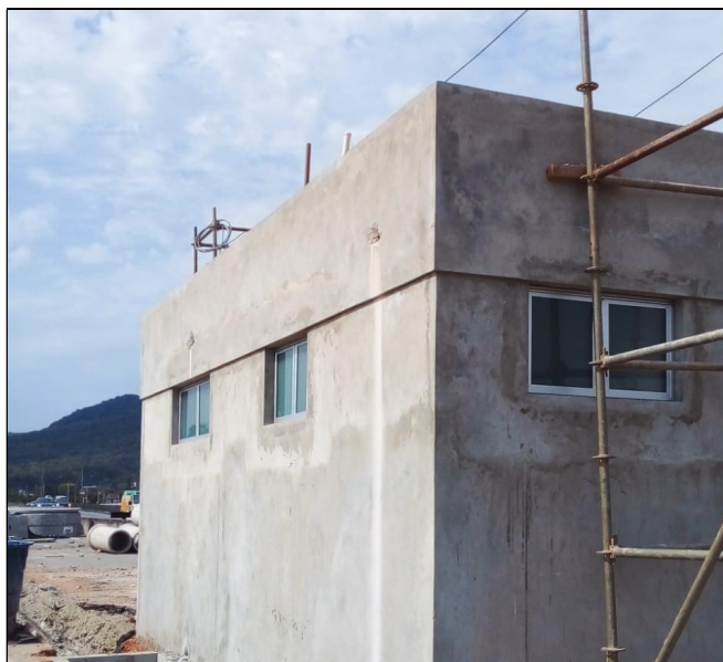
Figura 7: Execução da alvenaria do banheiro norte.
