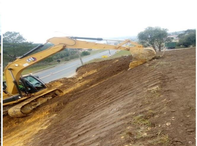
Figura 5.6 – Descarregamento do talude.
