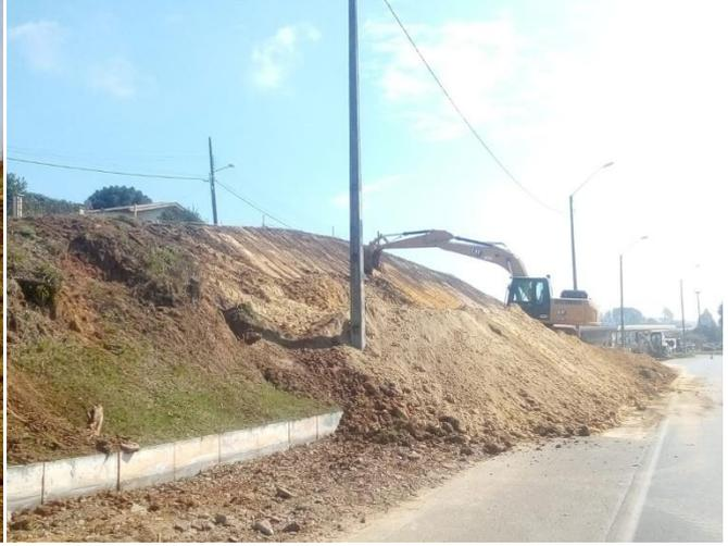
Figuras 5.2 – Descarregamento do talude.
