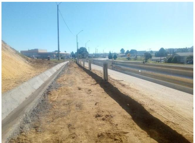
Figura 5.18 – Colocação da defesa metálica.
