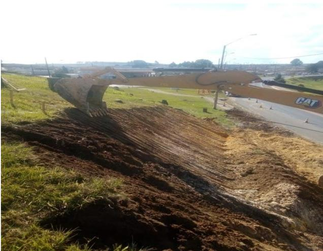
Figura 5.5 – Descarregamento do talude.
