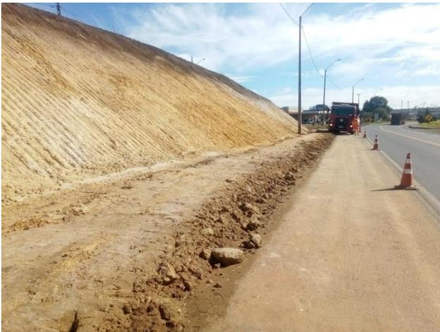
Figura 5.9 – Limpeza e escavações concluídas.
