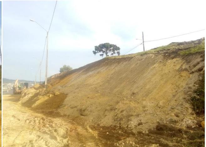
Figura 5.4 – Descarregamento do talude.
