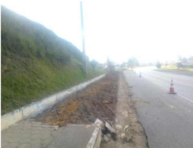
Figura 5.11 – Demolição do concreto existente.
