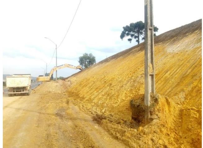
Figura 5.8 – Descarregamento do talude.
