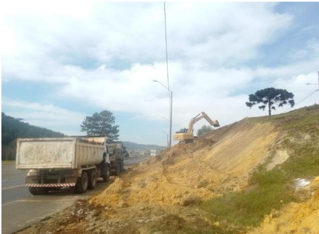
Figura 5.3 – Descarregamento do talude.
