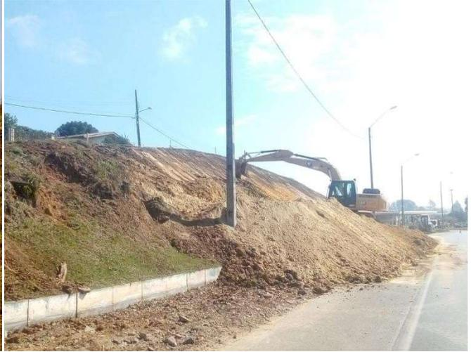
Figuras 5.2 – Descarregamento do talude.
