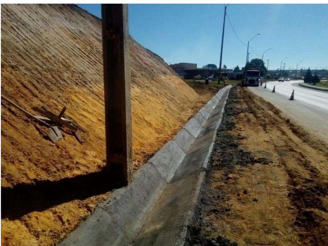
Figura 5.17 – Concretagem das sarjetas.
