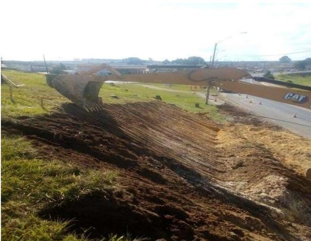
Figura 5.5 – Descarregamento do talude.
