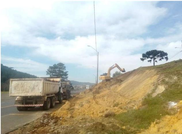
Figura 5.3 – Descarregamento do talude.
