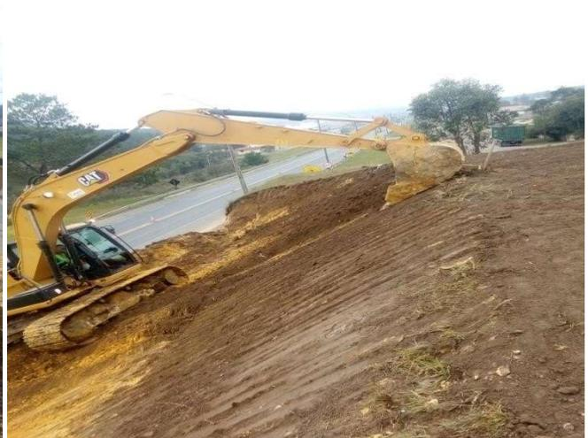
Figura 5.6 – Descarregamento do talude.
