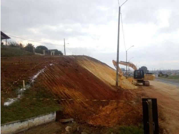
Figura 5.7 – Descarregamento do talude.
