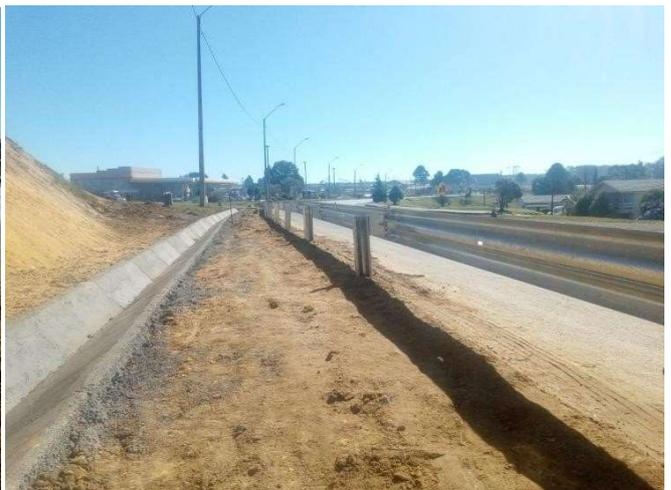
Figura 5.18 – Colocação da defesa metálica.
