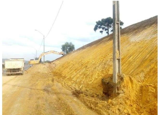
Figura 5.8 – Descarregamento do talude.
