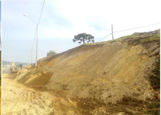
Figura 5.4 – Descarregamento do talude.
