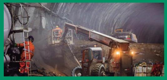
Após a escavação subterrânea completa das duas pistas, as obras no Túnel 1 entram em uma nova fase. A partir de agora, os trabalhos avançam para as fases de escavação do rebaixo (base do pavimento) e revestimento do túnel, que permitirão a pavimentação e a instalação dos sistemas de ventilação, sinalização e monitoramento. O mesmo trabalho também está sendo realizado no Túnel 4, entre os municípios de São José e Biguaçu, que também já registrou o fim das escavações subterrâneas.
