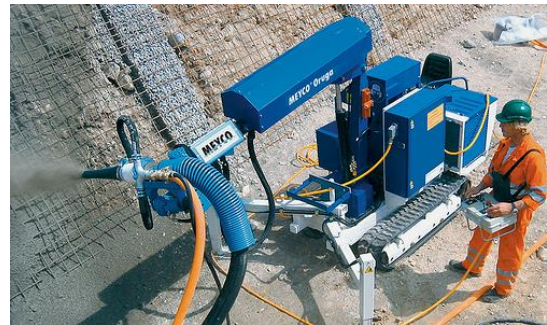
ROBÔ COM ESTEIRA E BRAÇO TELESCÓPICO
