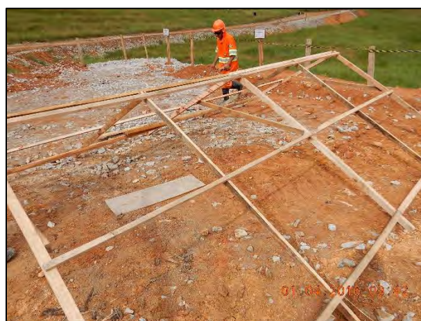
Figura 11: Construção da cobertura da estrutura.
