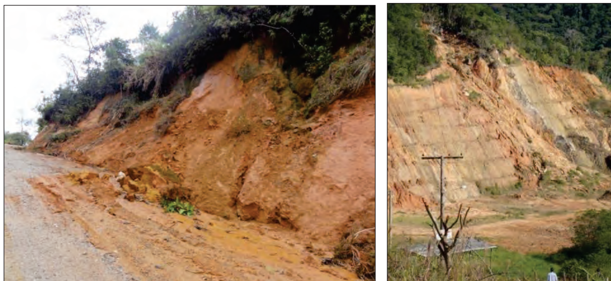
Figura 1: Instabilizações encontradas na região de implantação do Contorno Rodoviário de Florianópolis.
