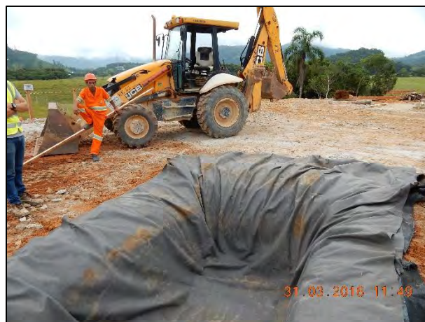
Figura 7: Instalação da segunda camada de bidim.
