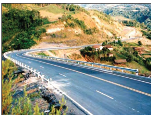
Figura 151: Aplicação de defensas metálicas em curva.
