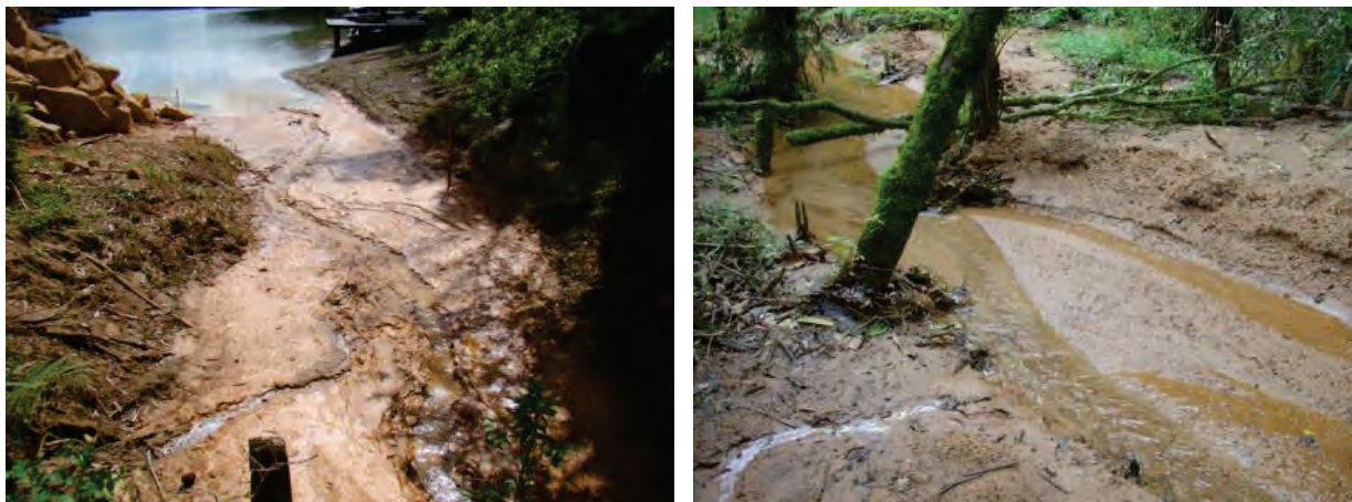
Figura 4: Assoreamento de curso d'água cujo material é proveniente do talude de aterro apresentado na Figura 3.
