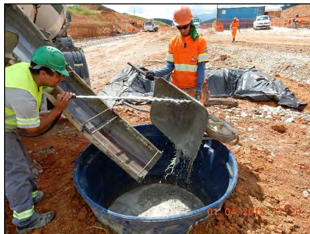
Figura 15: Limpeza das ferramentas em recipiente estanque.
