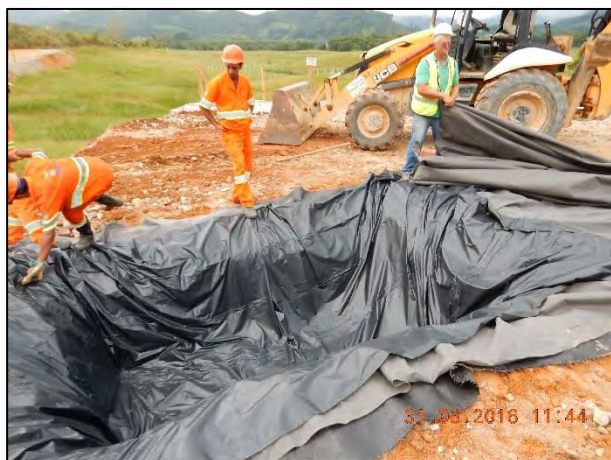
Figura 6: Instalação da primeira camada de lona plástica.
