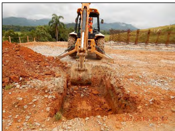
Figura 2: Abertura da vala.
