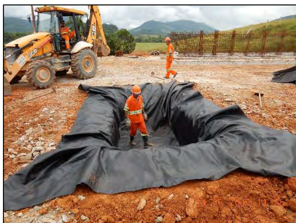
Figura 4: Instalação da manta geotêxtil.
