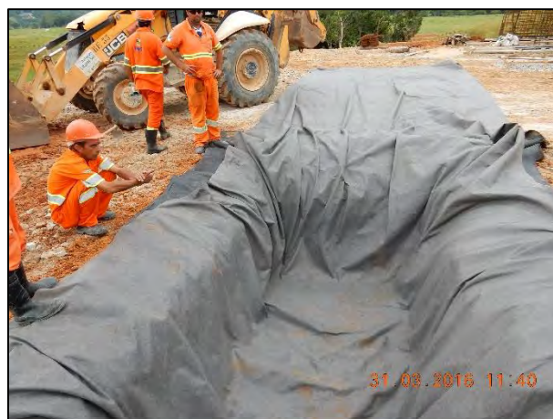
Figura 5: Instalação da primeira camada de bidim.
