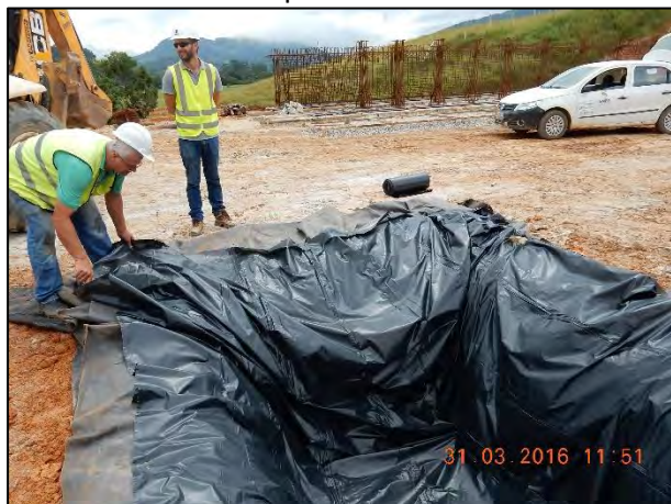
Figura 8: Instalação da segunda camada de lona plástica.
