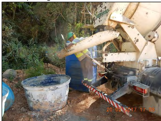
Figura 14: Limpeza da calha do caminhão betoneira em recipiente estanque.
