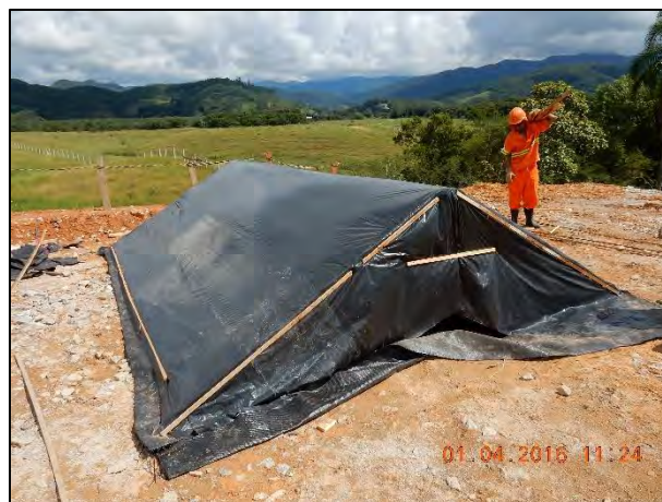
Figura 13: Cobertura pronta para instalação sobre a estrutura.
