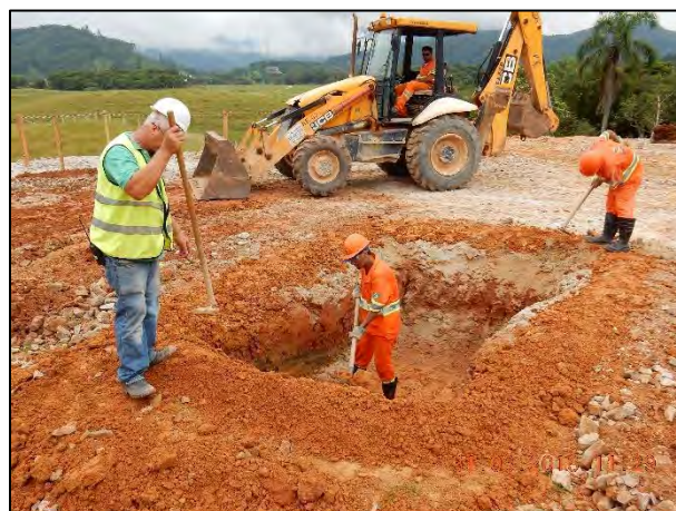
Figura 3: Montagem da leira ao redor da vala.
