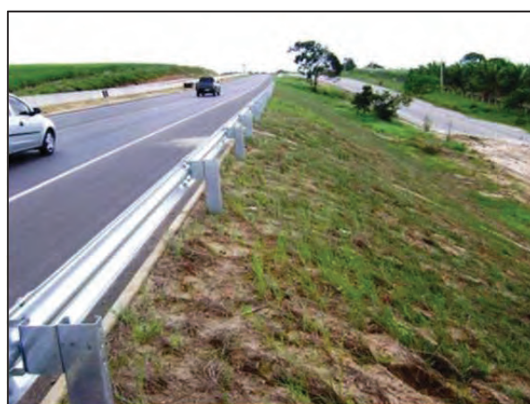
Figura 152: Aplicação de defensas metálicas em taludes.
