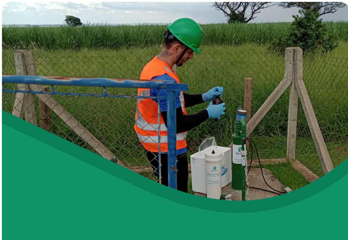
Imagem: Atividade de monitoramento da qualidade da água durante a obra.
