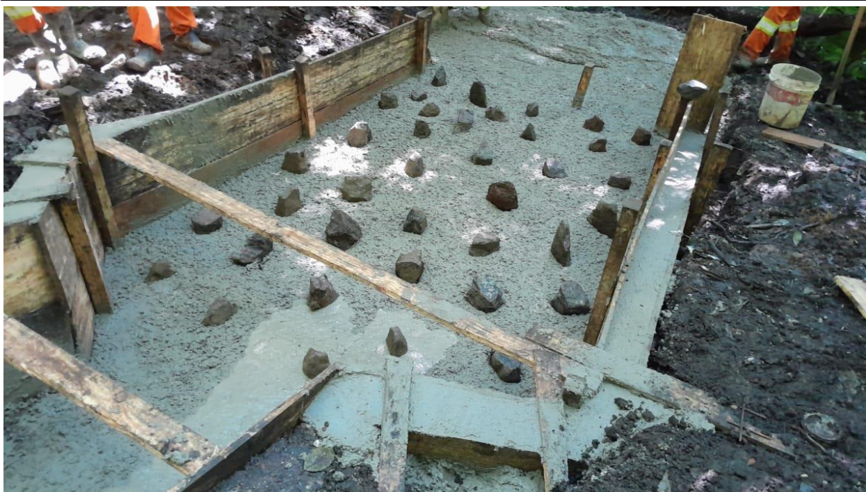
Foto 10.87 – Restauração Escada Hidráulica Existente
