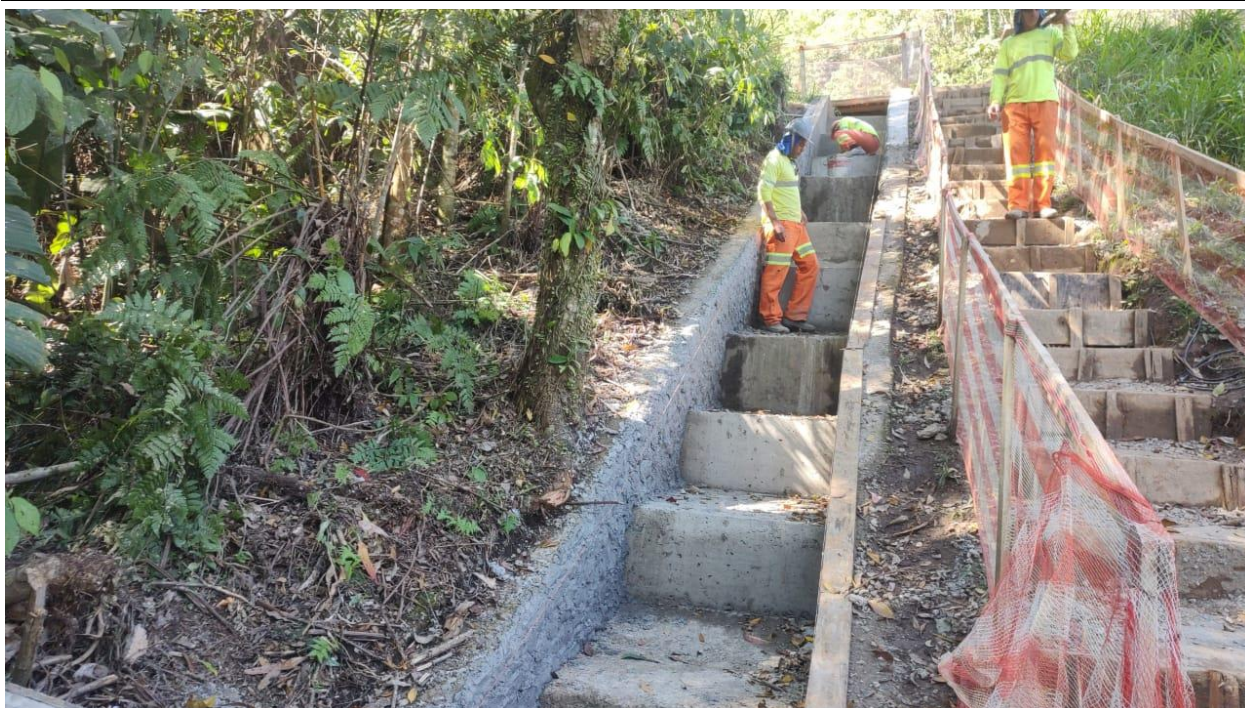
Foto 10.91 – Restauração Escada Hidráulica Existente
