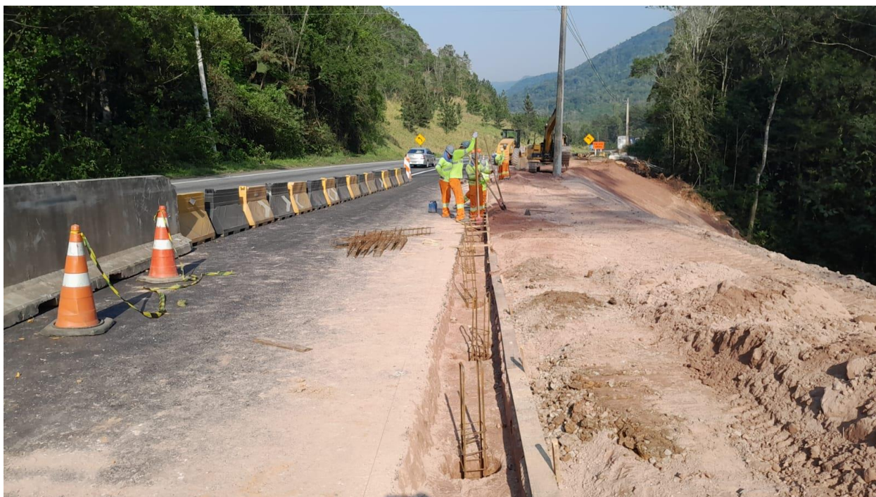
Foto 10.132 – Execução das Barreiras New Jersey
