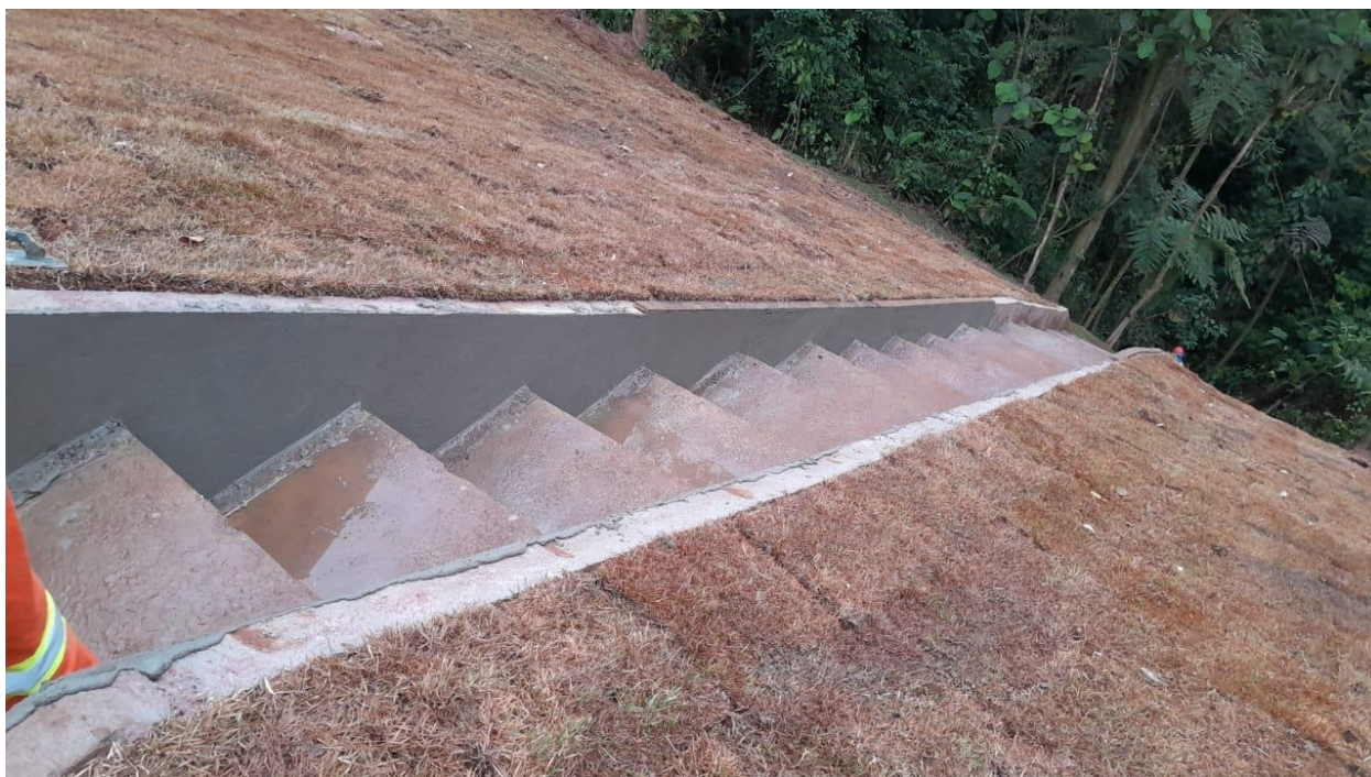
Foto 10.158 – Execução Escada Hidráulica DAD-03
