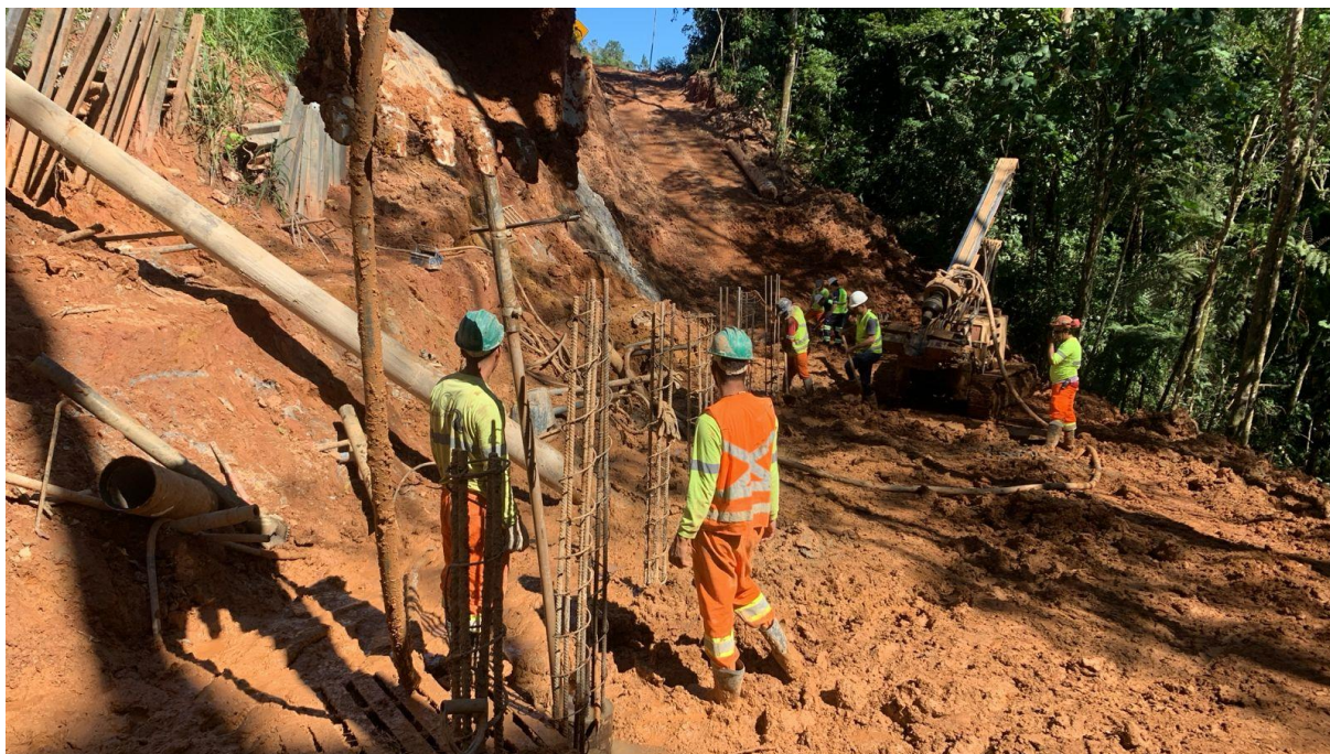
Foto 10.24 – Injeção das estacas raiz
