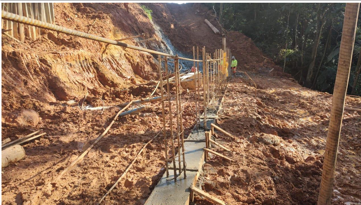
Foto 10.30 – Viga de Apoio
