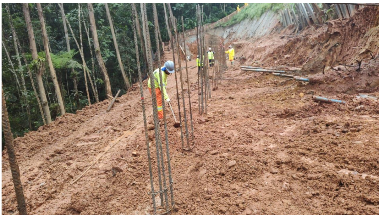
Foto 10.27 – Viga de Apoio
