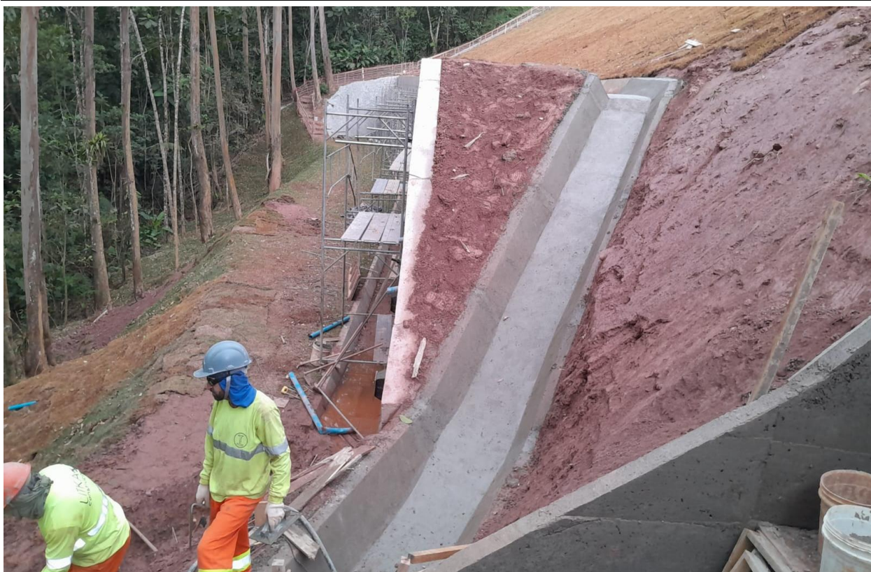
Foto 10.159 – Conexão Hidráulica dos Dispositivos de Drenagem
