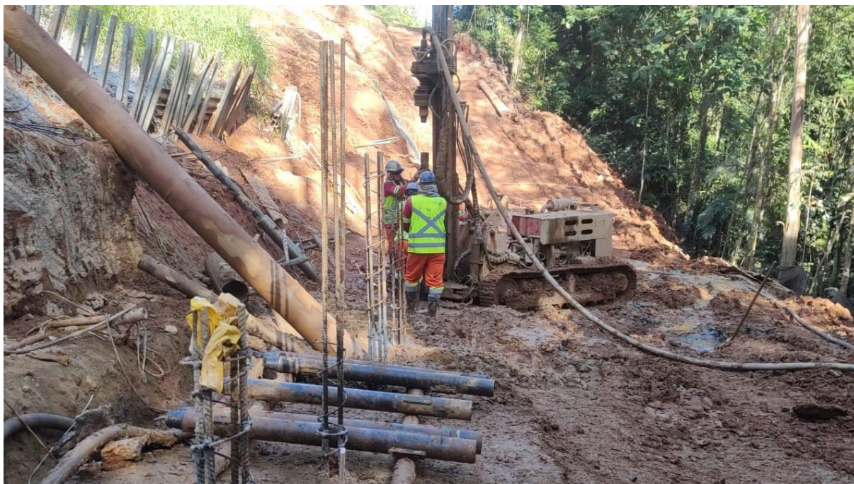
Foto 10.21 – Perfuração das estacas raiz
