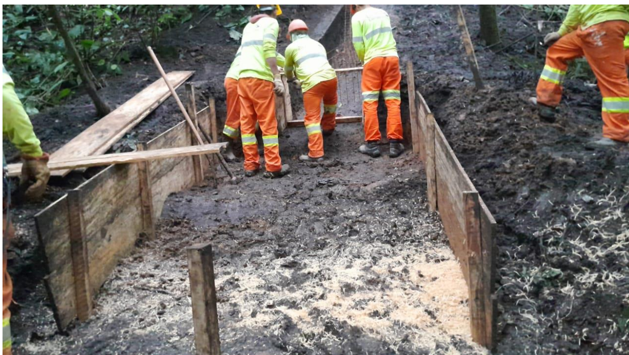
Foto 10.86 – Restauração Escada Hidráulica Existente
