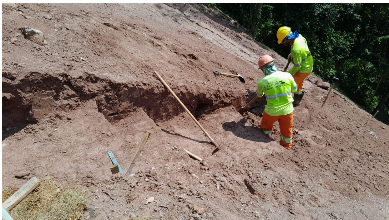
Foto 10.154 – Execução Escada Hidráulica DAD-03
