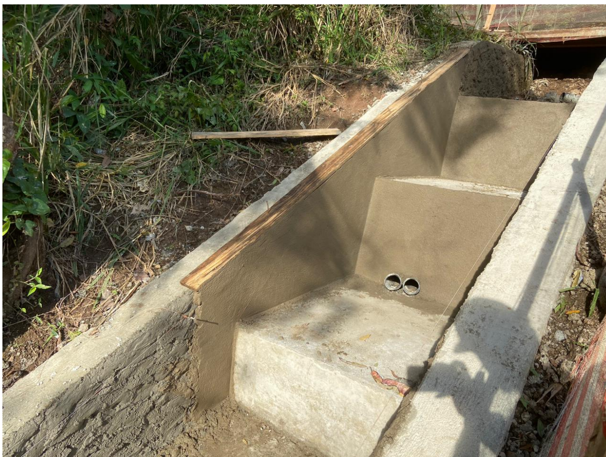
Foto 10.90 – Restauração Escada Hidráulica Existente
