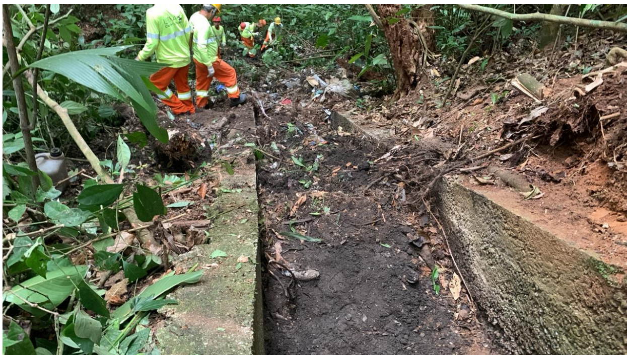
Foto 10.84 – Restauração Escada Hidráulica Existente
