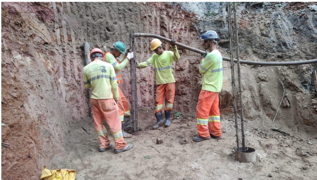
Foto 10.26 – Injeção das estacas raiz
