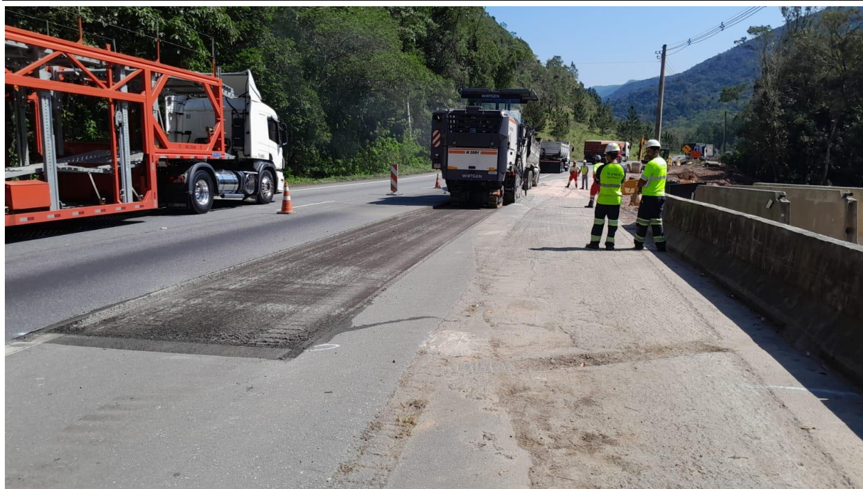
Foto 10.125 – Fresagem do Pavimento
