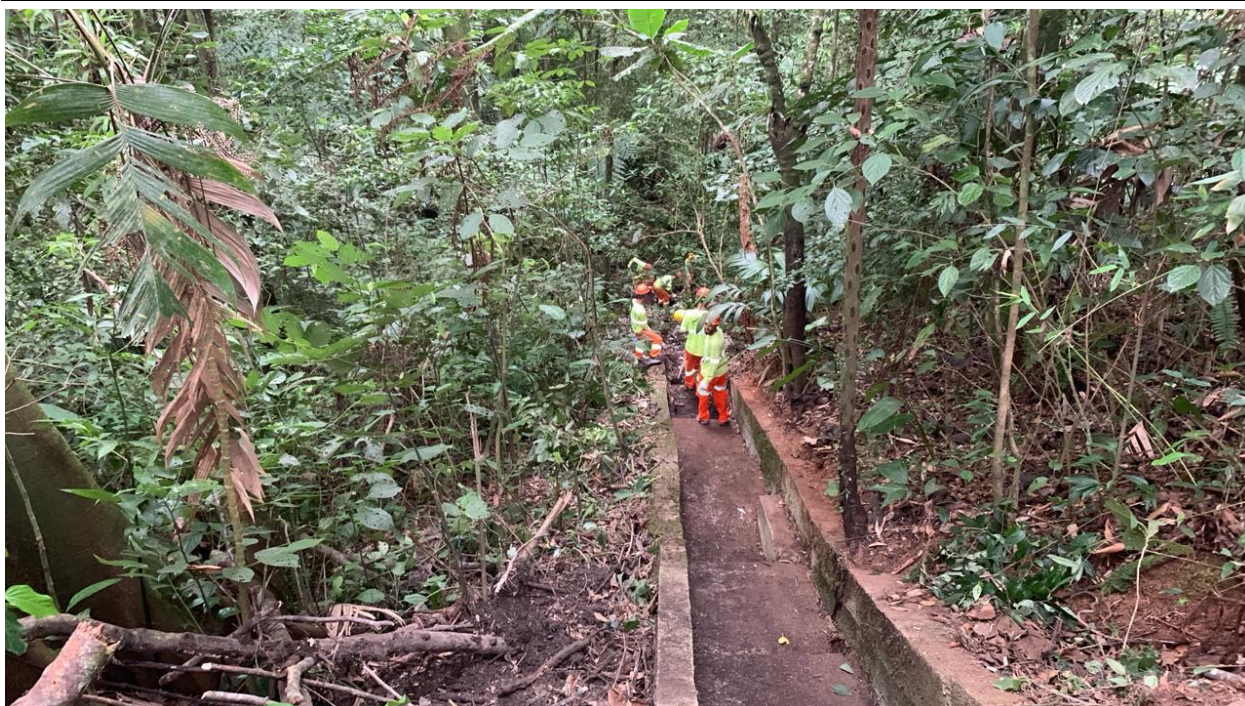
Foto 10.85 – Restauração Escada Hidráulica Existente
