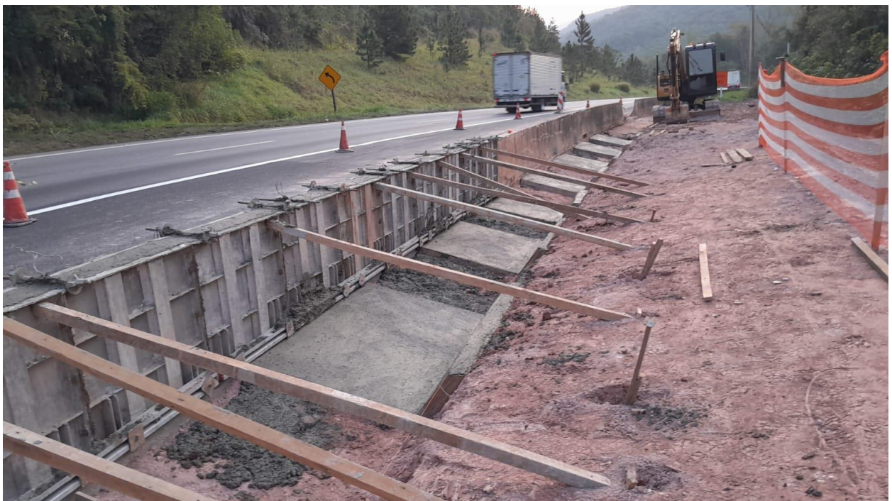
Foto 10.142 – Execução da Drenagem STC 05
