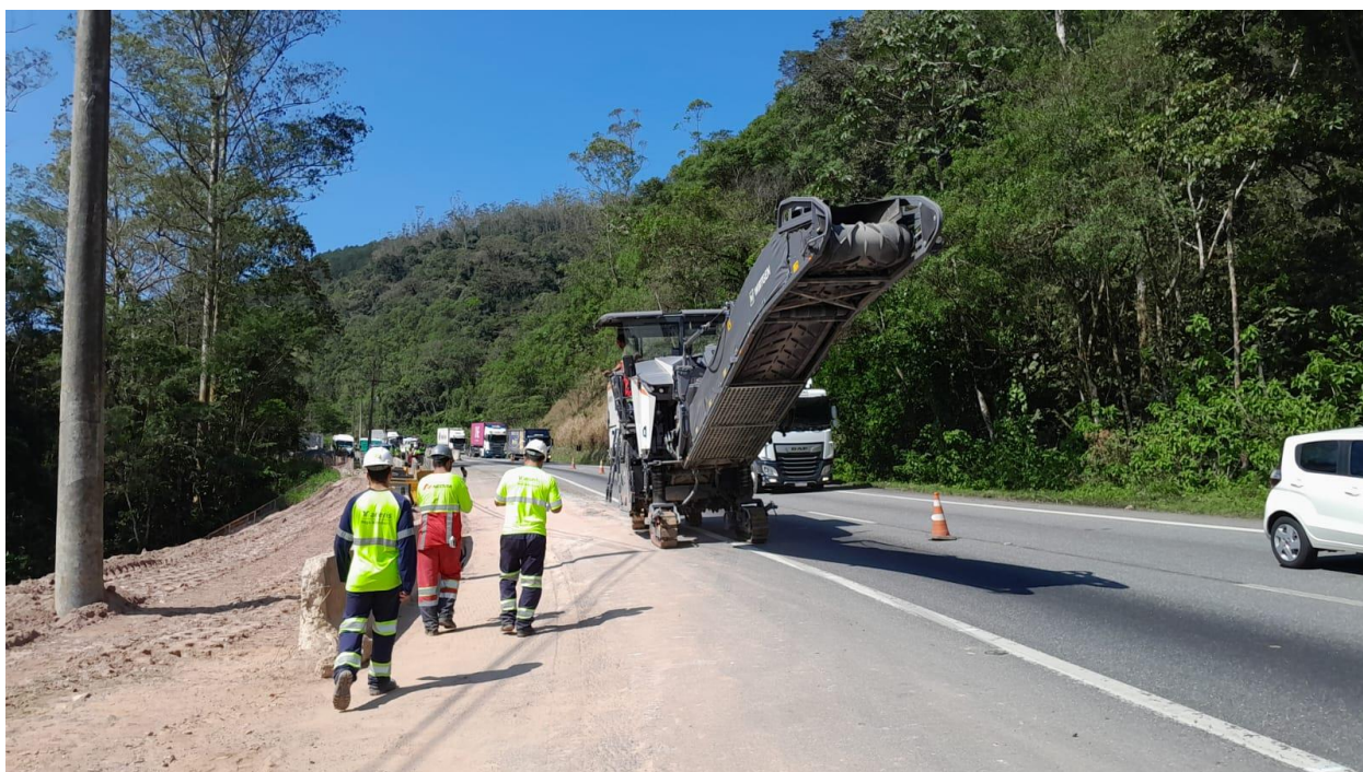
Foto 10.124 – Fresagem do Pavimento
