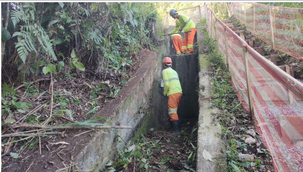
Foto 10.83 – Restauração Escada Hidráulica Existente
