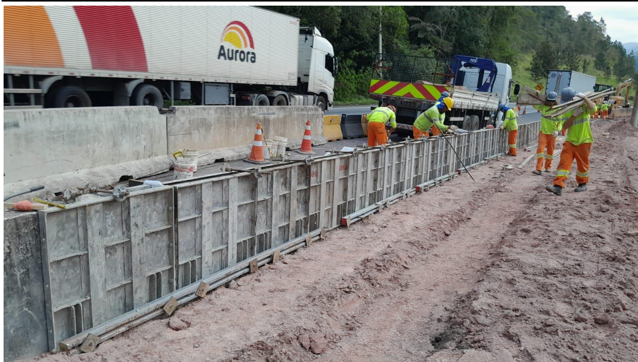
Foto 10.135 – Execução das Barreiras New Jersey
