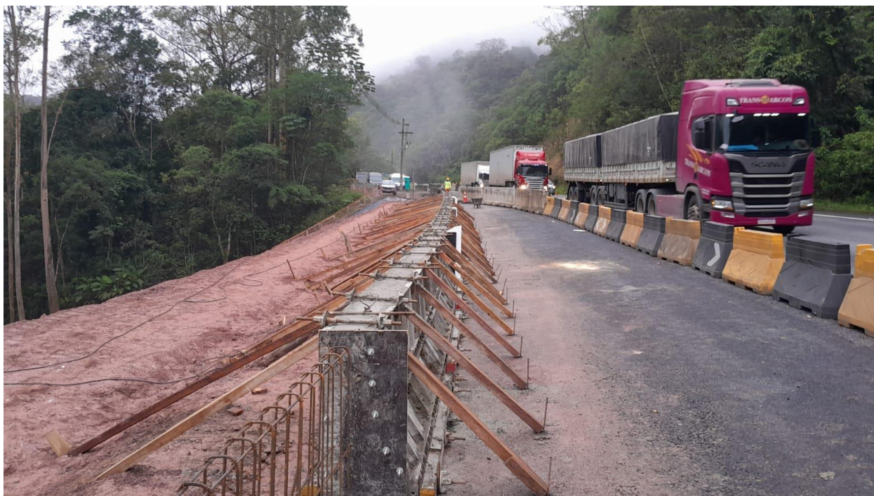
Foto 10.138 – Execução das Barreiras New Jersey
