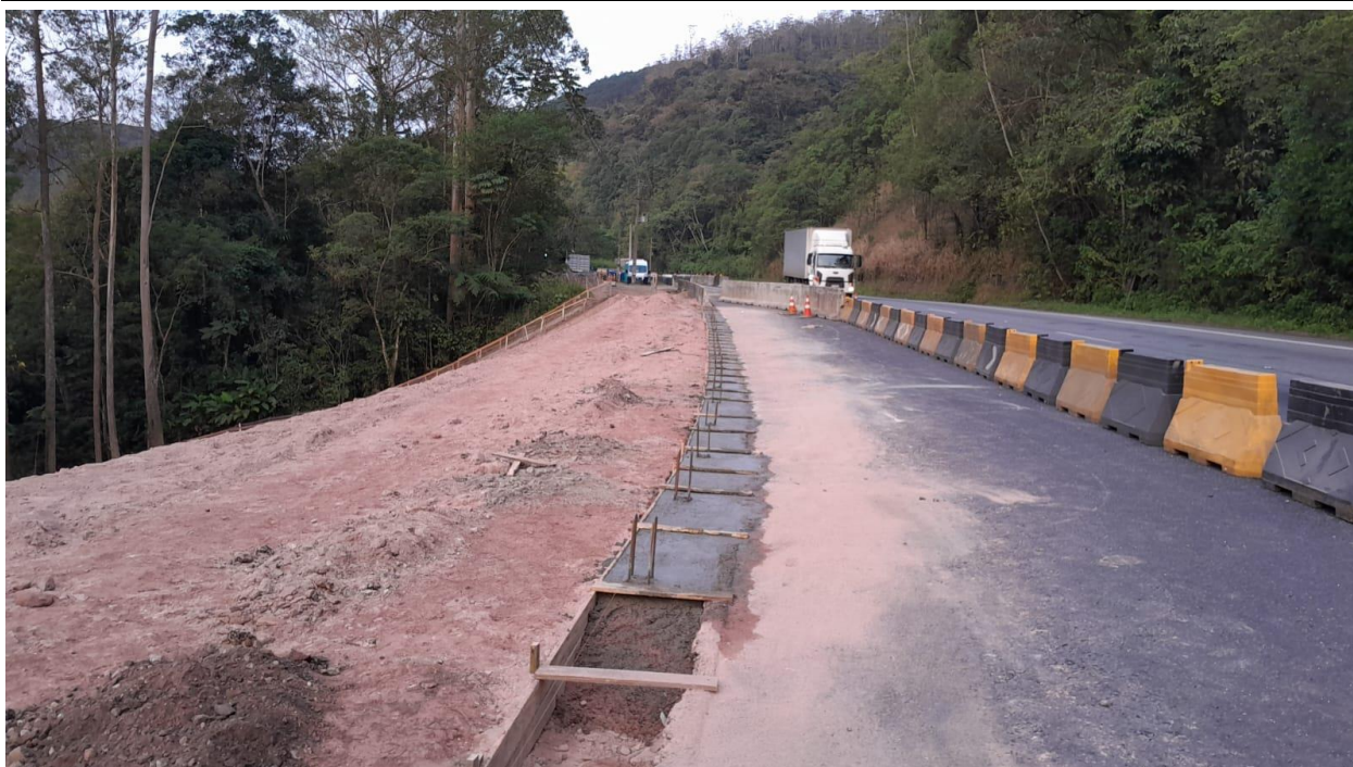
Foto 10.133 – Execução das Barreiras New Jersey
