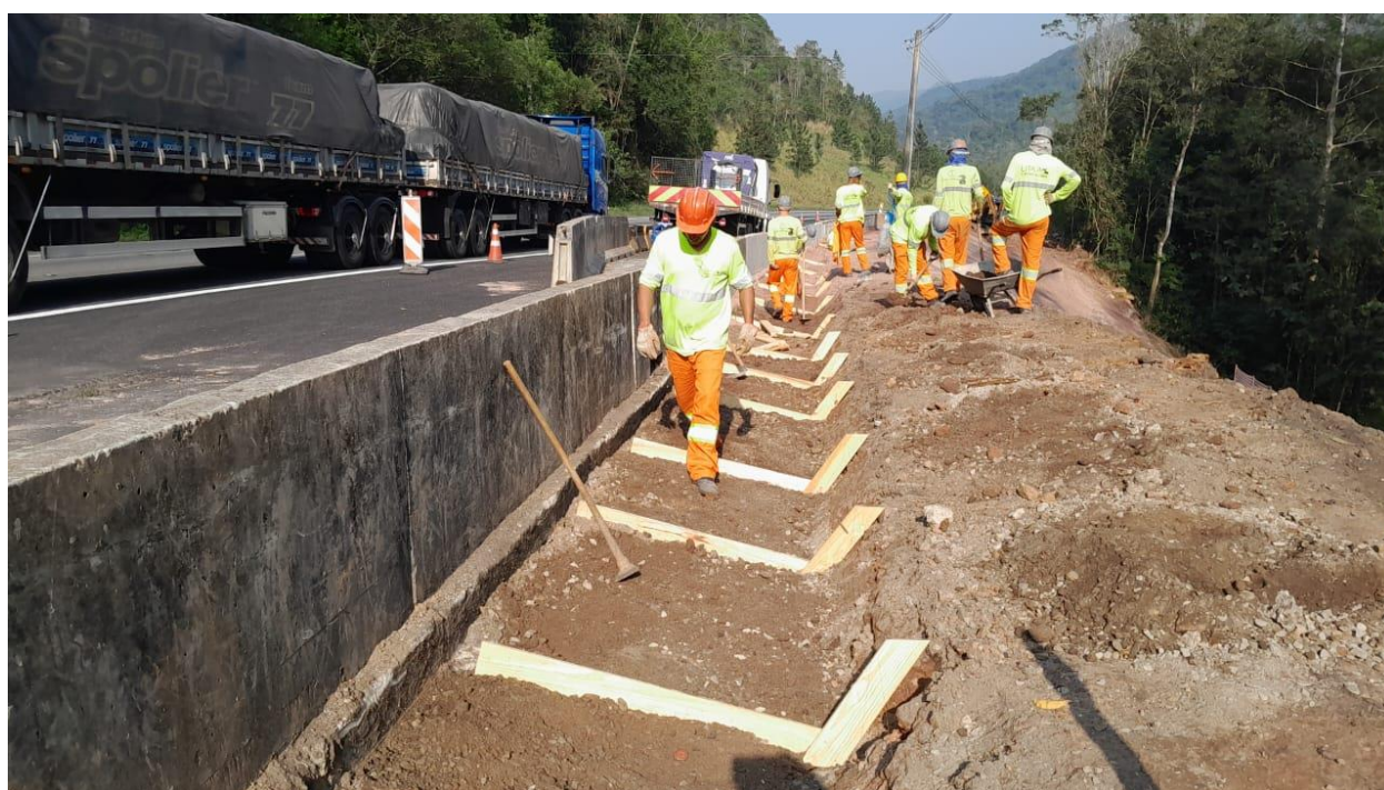
Foto 10.140 – Execução da Drenagem STC 05
