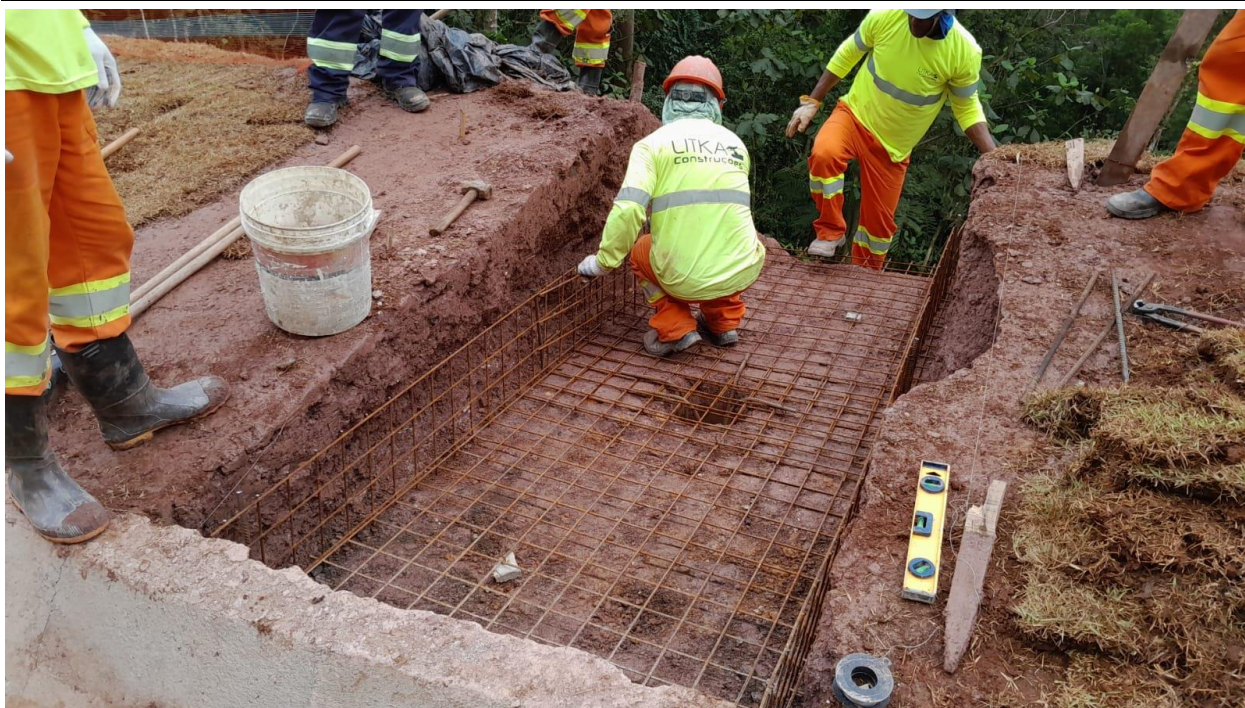
Foto 10.155 – Execução Escada Hidráulica DAD-03
