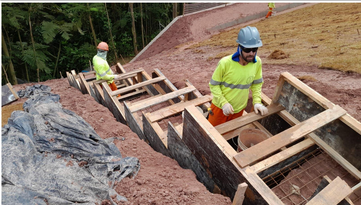
Foto 10.157 – Execução Escada Hidráulica DAD-03
