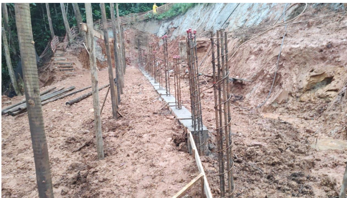
Foto 10.31 – Viga de Apoio
