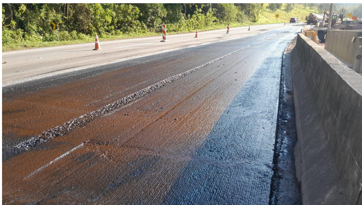
Foto 10.126 – Imprimação do Pavimento
