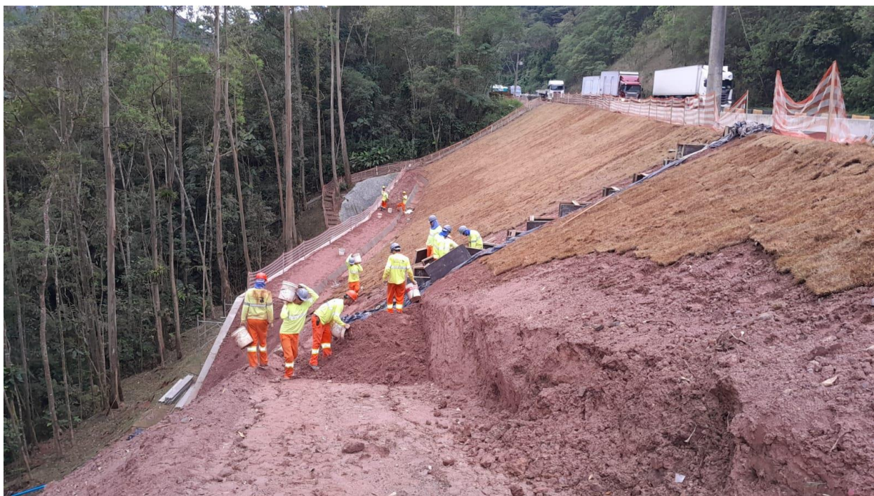
Foto 10.156 – Execução Escada Hidráulica DAD-03
