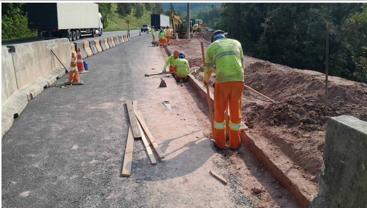
Foto 10.131 – Execução das Barreiras New Jersey
