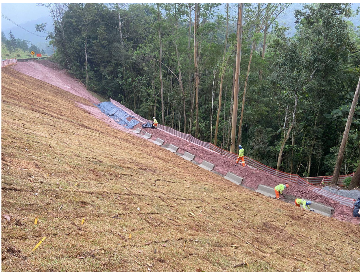
Foto 10.148 – Execução drenagem VPA 04
