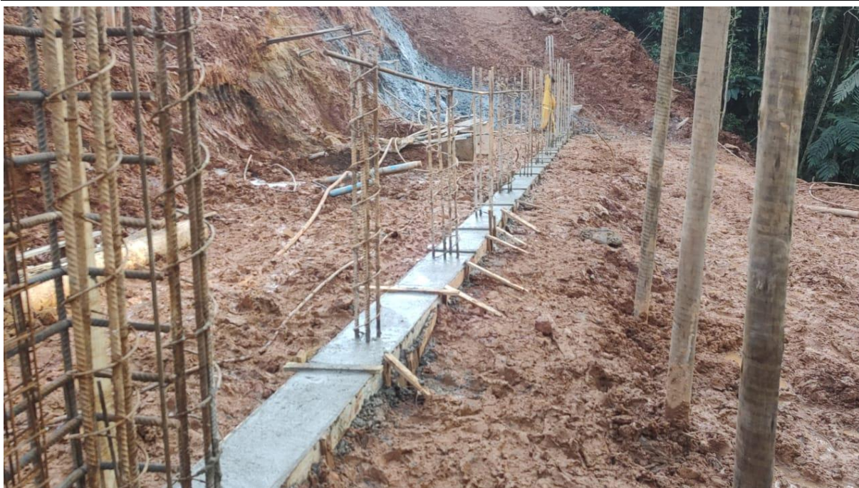
Foto 10.32 – Viga de Apoio
