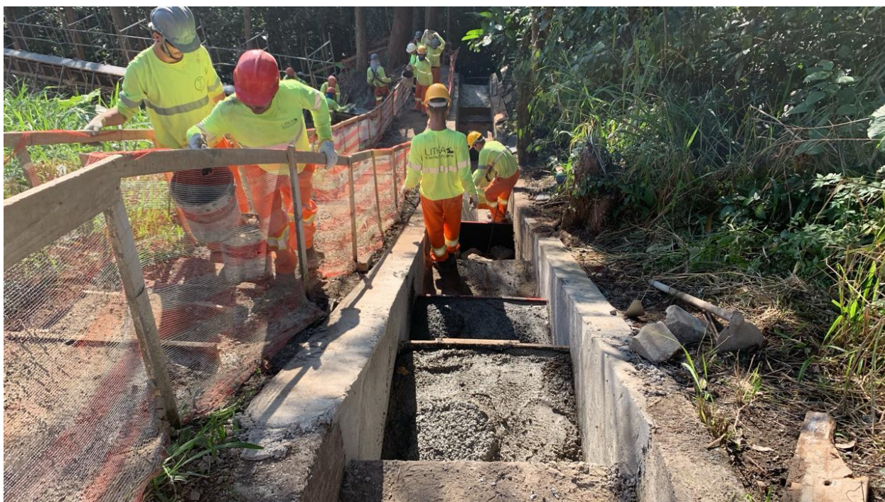
Foto 10.88 – Restauração Escada Hidráulica Existente
