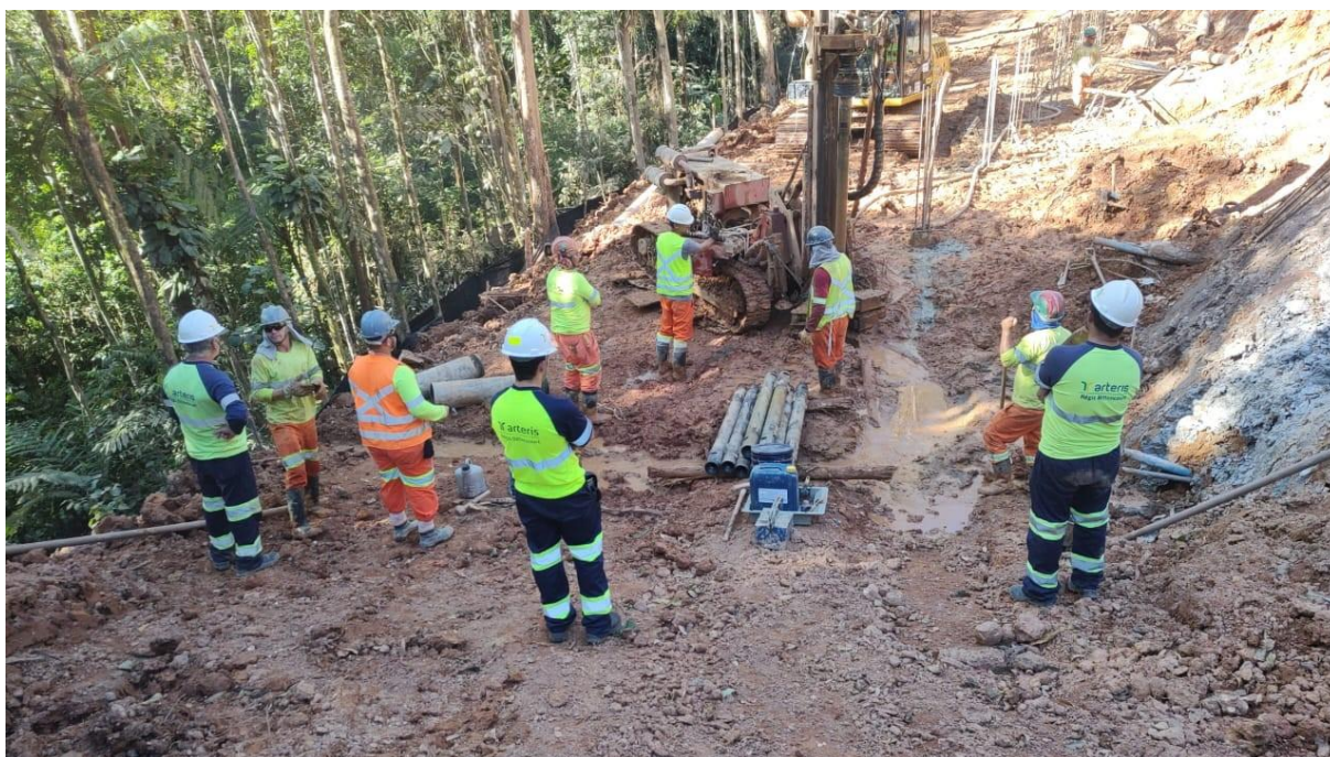
Foto 10.23 – Perfuração das estacas raiz
