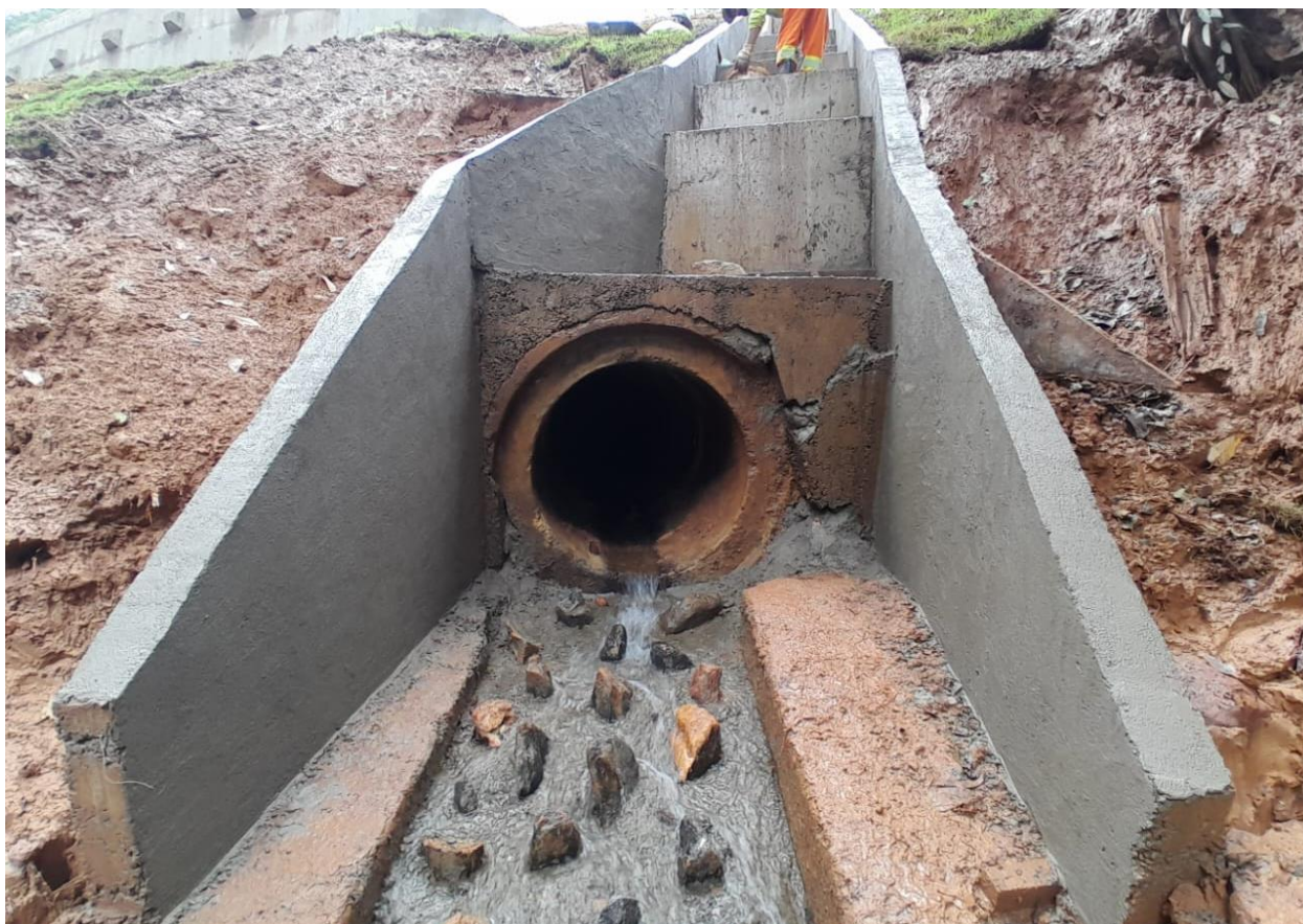
Foto 10.160 – Dissipador DEB-01 e Alas do Bueiro
