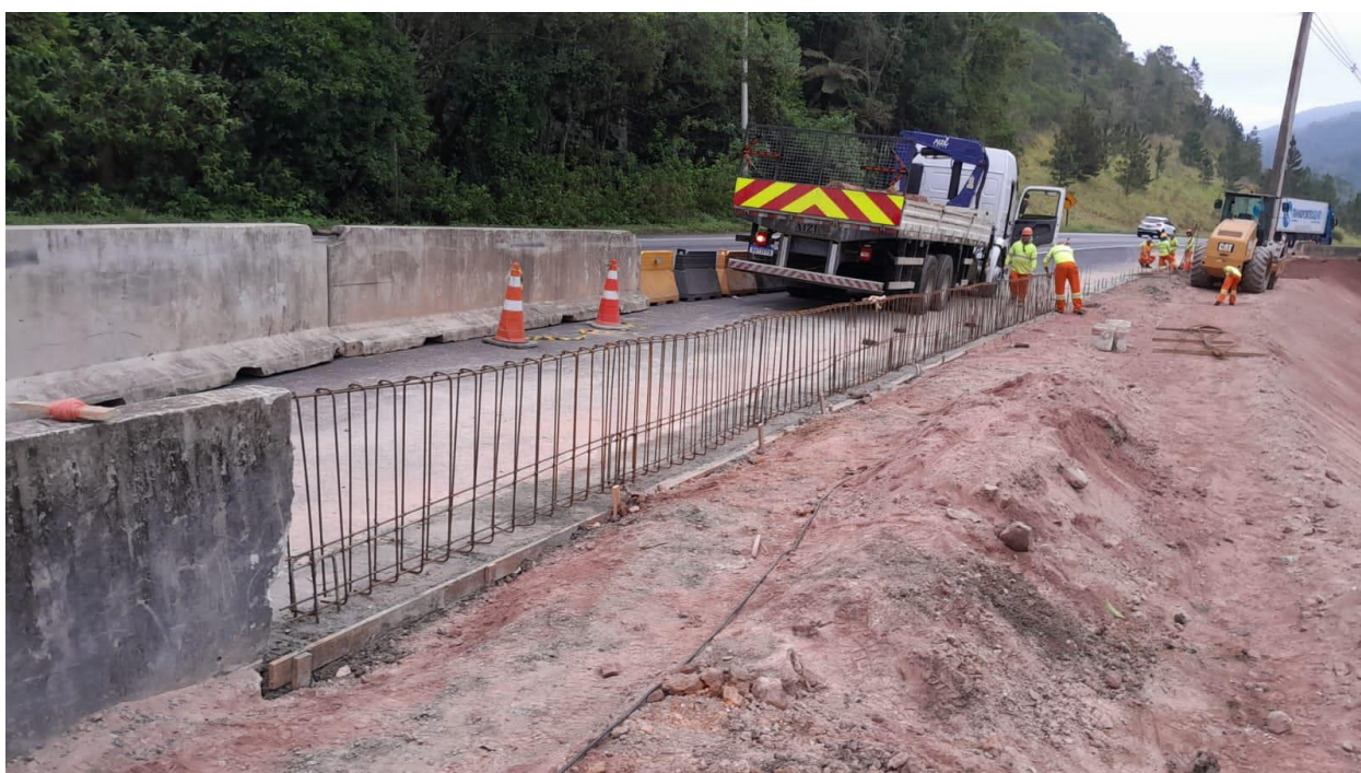
Foto 10.134 – Execução das Barreiras New Jersey
