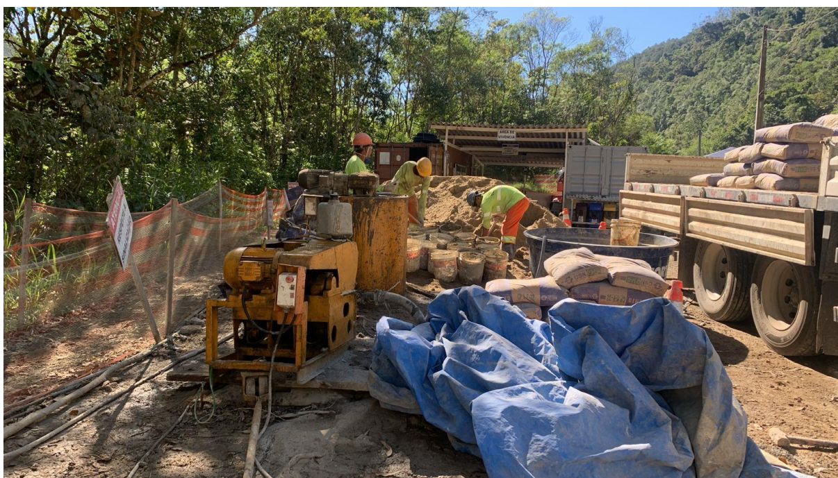
Foto 10.25 – Injeção das estacas raiz
