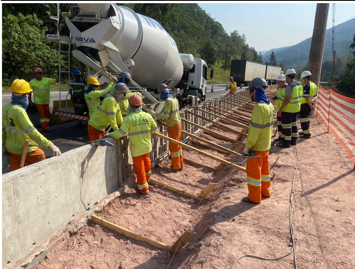
Foto 10.139 – Execução das Barreiras New Jersey
