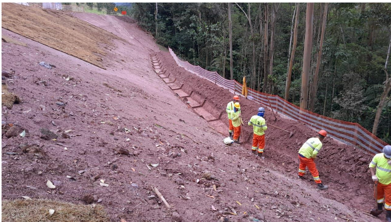
Foto 10.147 – Execução drenagem VPA 04
