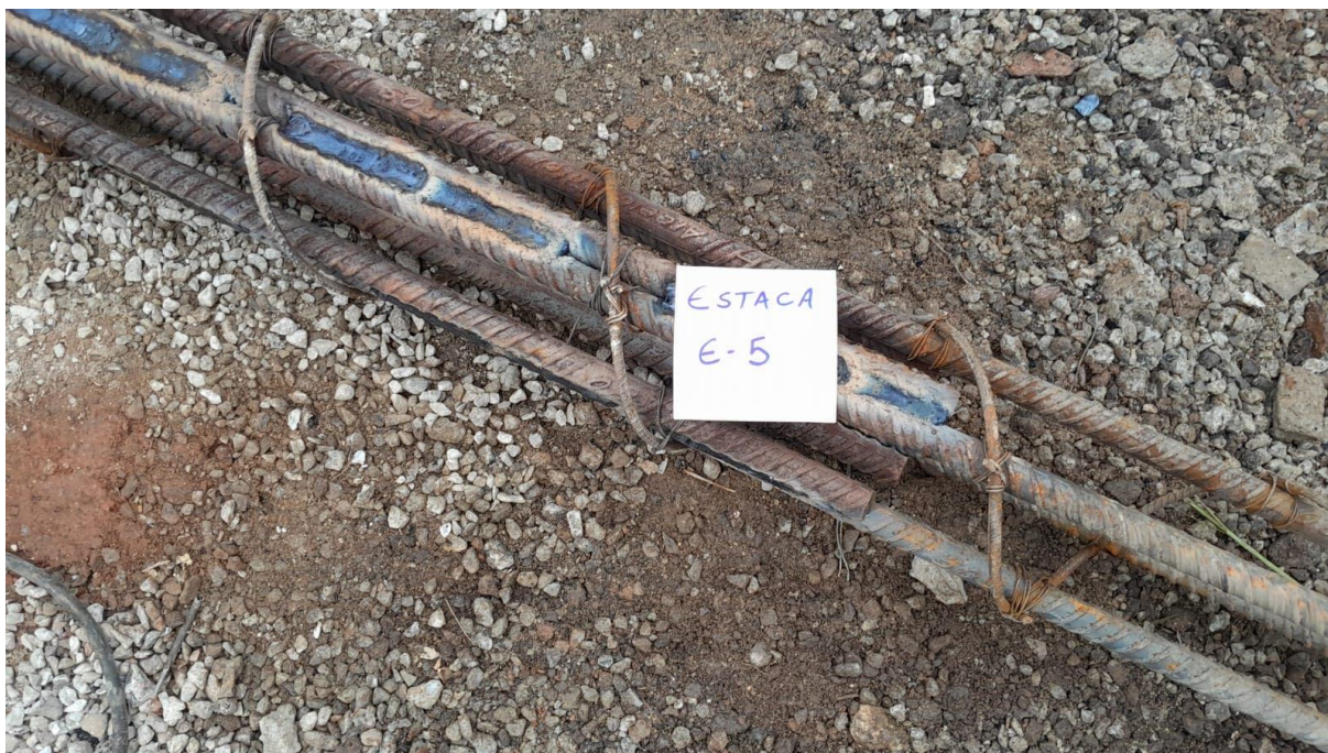
Foto 10.20 – Emenda das Estacas Raiz
