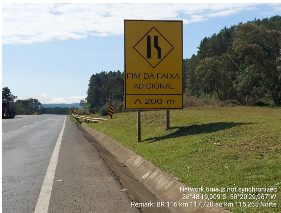
FIGURA ERRO! NENHUM TEXTO COM O ESTILO ESPECIFICADO FOI ENCONTRADO NO DOCUMENTO..43 – SINALIZAÇÃO VERTICAL E DEFENSA METÁLICA
