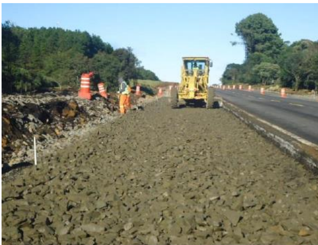
FIGURA ERRO! NENHUM TEXTO COM O ESTILO ESPECIFICADO FOI ENCONTRADO NO DOCUMENTO..18 – EXECUÇÃO DAS CAMADAS DO PAVIMENTO
