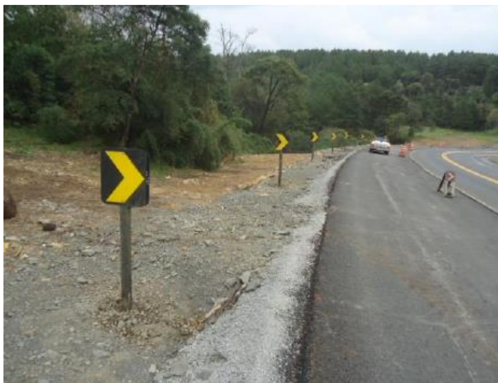
FIGURA ERRO! NENHUM TEXTO COM O ESTILO ESPECIFICADO FOI ENCONTRADO NO DOCUMENTO..26 – EXECUÇÃO DE SINALIZAÇÃO VERTICAL
