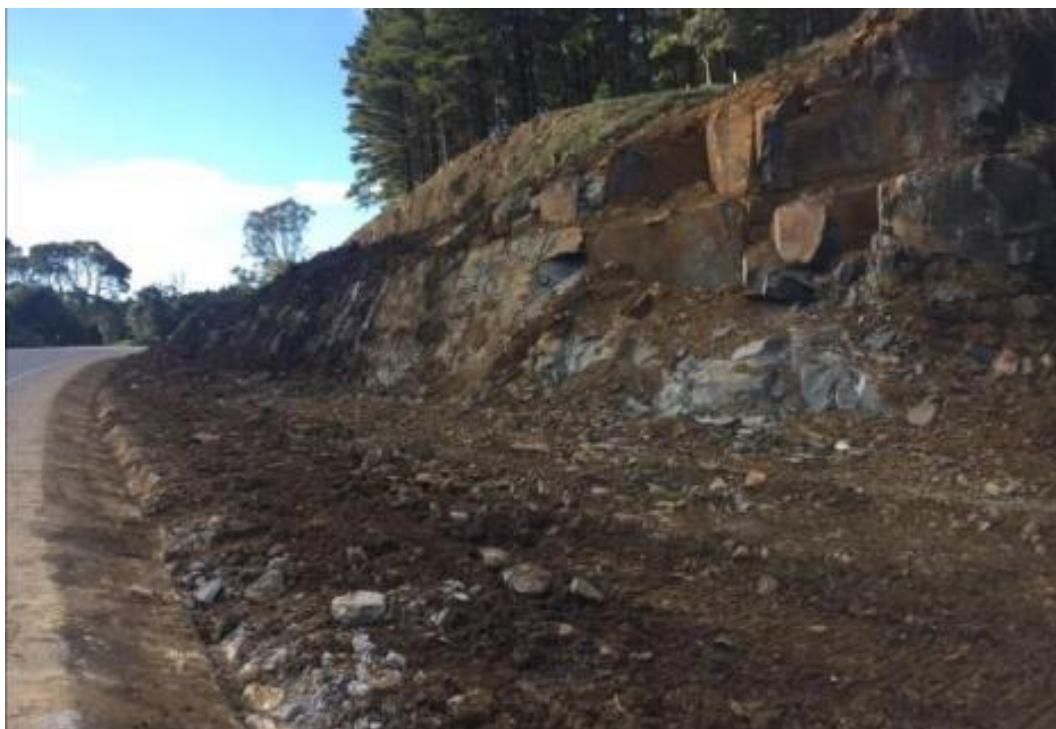
FIGURA ERRO! NENHUM TEXTO COM O ESTILO ESPECIFICADO FOI ENCONTRADO NO DOCUMENTO..8 – ESCAVAÇÃO DO MATERIAL DE 2ª E 3ª CATEGORIA
