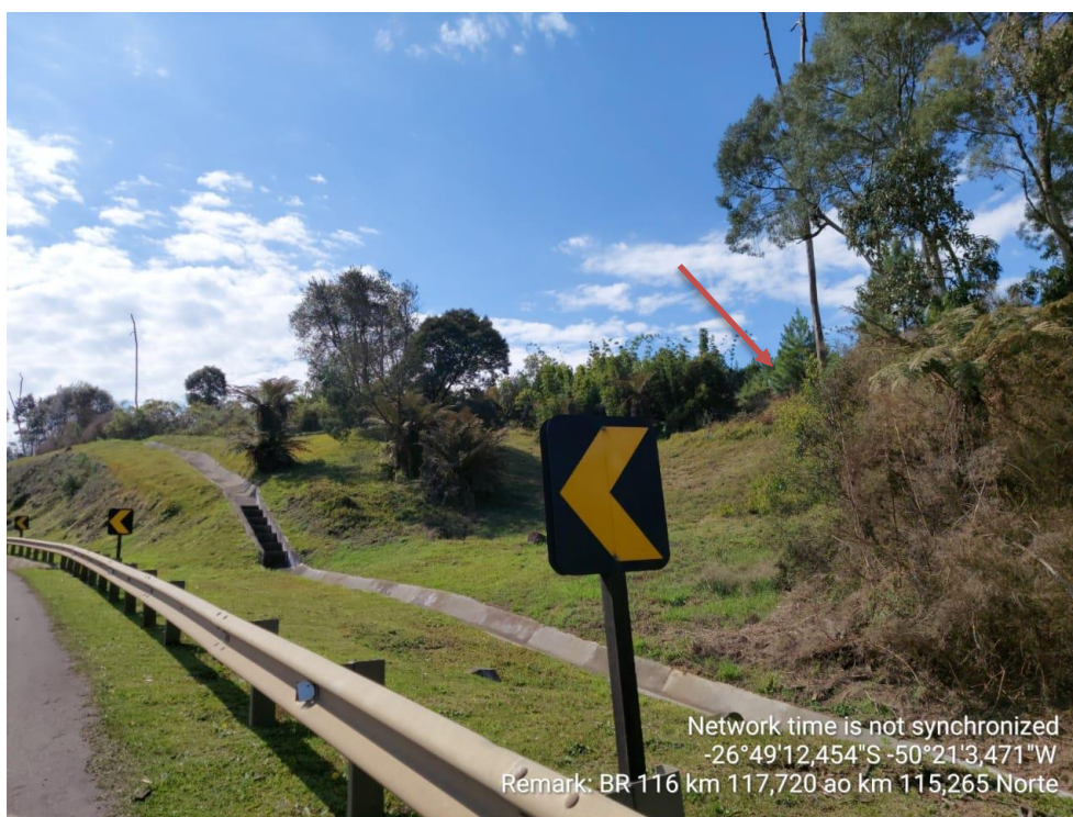
FIGURA ERRO! NENHUM TEXTO COM O ESTILO ESPECIFICADO FOI ENCONTRADO NO DOCUMENTO..40 - SINALIZAÇÃO VERTICAL, DEFENSA METÁLICA E DISPOSITIVO DE DRENAGEM
