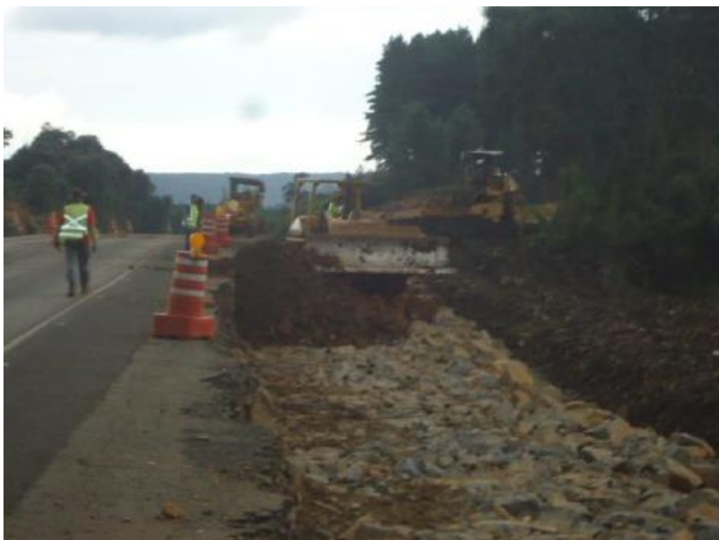
FIGURA ERRO! NENHUM TEXTO COM O ESTILO ESPECIFICADO FOI ENCONTRADO NO DOCUMENTO..17 – EXECUÇÃO DAS CAMADAS DO PAVIMENTO
