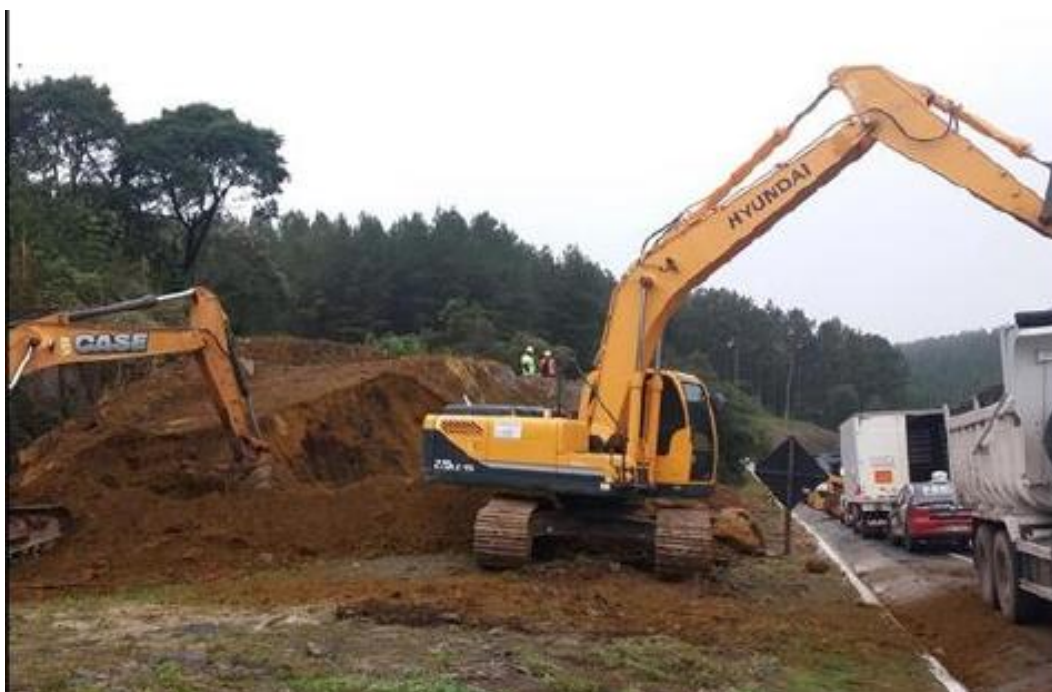
FIGURA ERRO! NENHUM TEXTO COM O ESTILO ESPECIFICADO FOI ENCONTRADO NO DOCUMENTO..5 - ESCAVAÇÃO MATERIAL 1ª CATEGORIA
