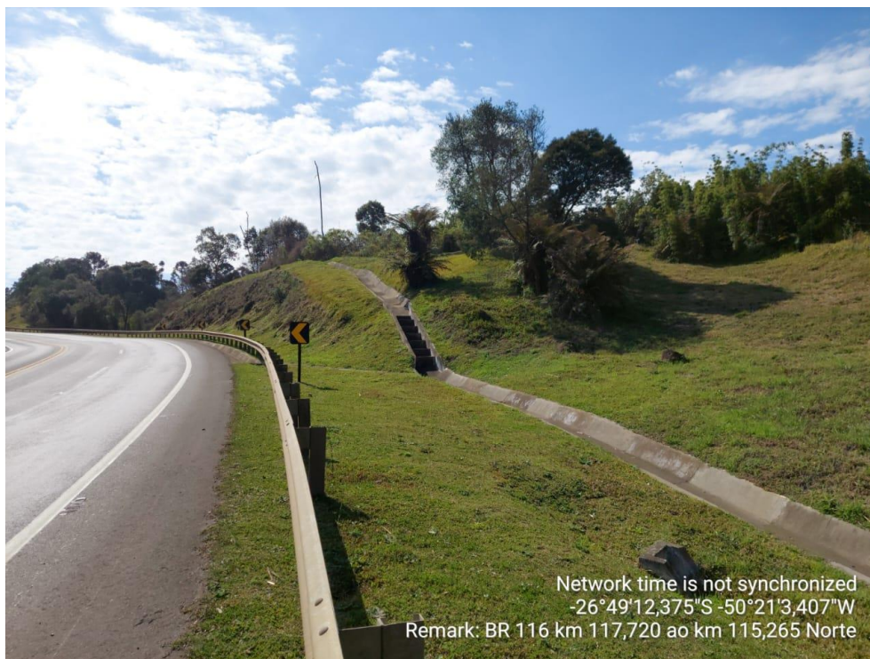
FIGURA ERRO! NENHUM TEXTO COM O ESTILO ESPECIFICADO FOI ENCONTRADO NO DOCUMENTO..45 – DEFENSA METÁLICA, SINALIZAÇÃO VERTICAL E DISPOSITIVO DE DRENAGEM
