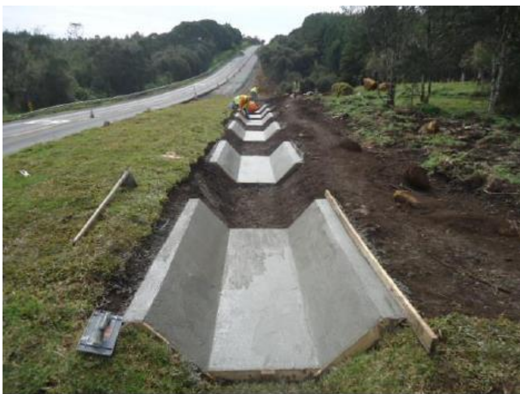
FIGURA ERRO! NENHUM TEXTO COM O ESTILO ESPECIFICADO FOI ENCONTRADO NO DOCUMENTO..15 – EXECUÇÃO DE DISPOSITIVO DE DRENAGEM SUPERFICIAL
