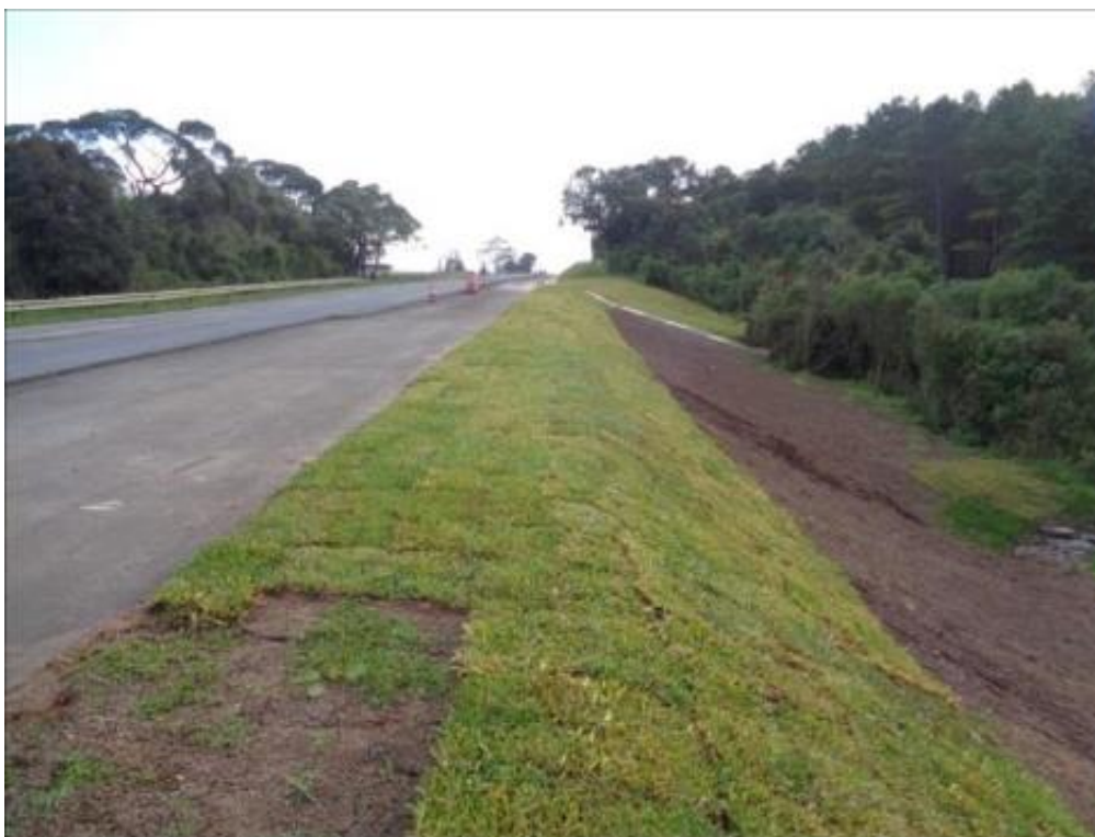
FIGURA ERRO! NENHUM TEXTO COM O ESTILO ESPECIFICADO FOI ENCONTRADO NO DOCUMENTO..10 – RECOBRIMENTO COM GRAMA EM PLACAS
