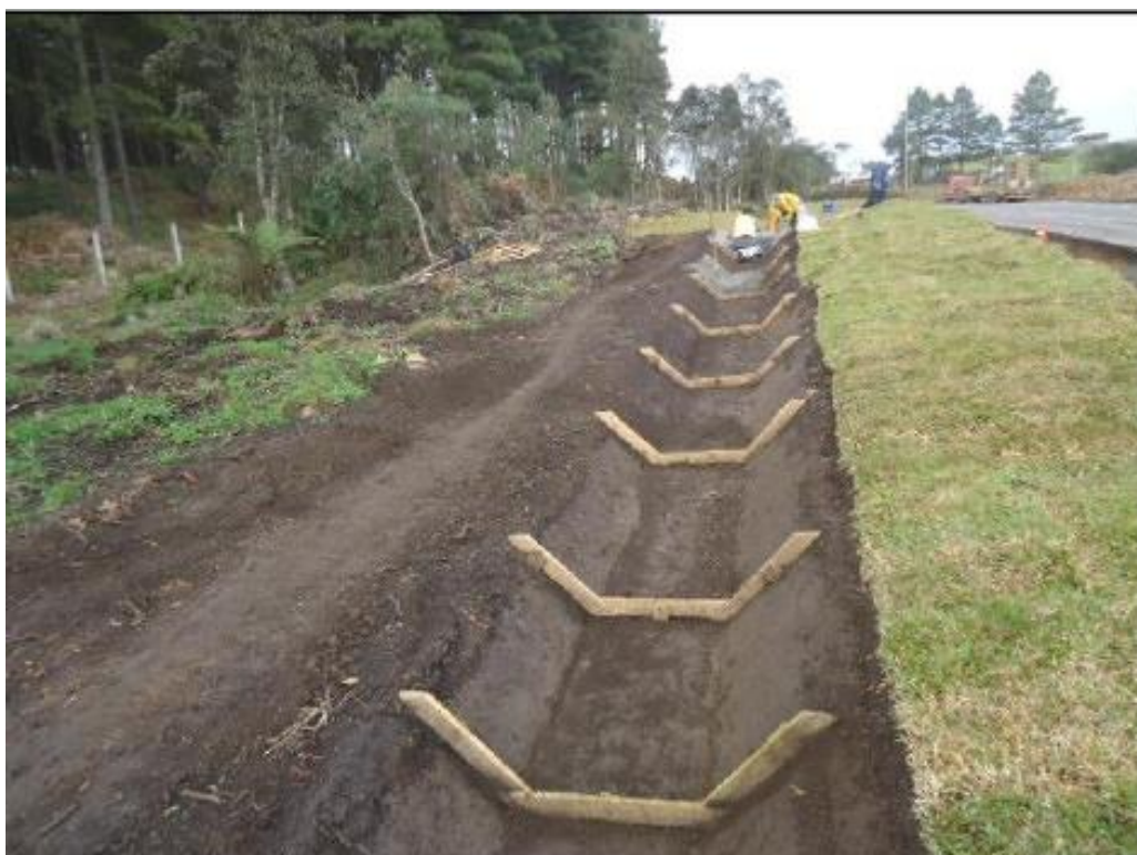
FIGURA ERRO! NENHUM TEXTO COM O ESTILO ESPECIFICADO FOI ENCONTRADO NO DOCUMENTO..14 - MONTAGEM DE FORMA PARA EXECUÇÃO DE DRENAGEM SUPERFICIAL
