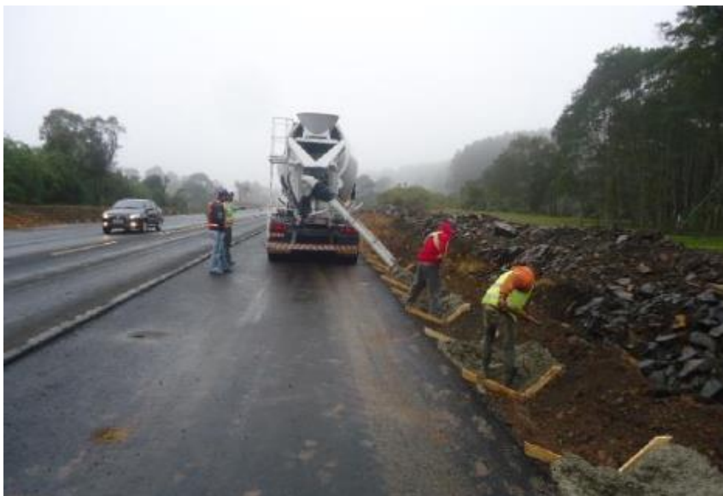
FIGURA ERRO! NENHUM TEXTO COM O ESTILO ESPECIFICADO FOI ENCONTRADO NO DOCUMENTO..13 – MONTAGEM DE FORMA PARA EXECUÇÃO DE DRENAGEM SUPERFICIAL
