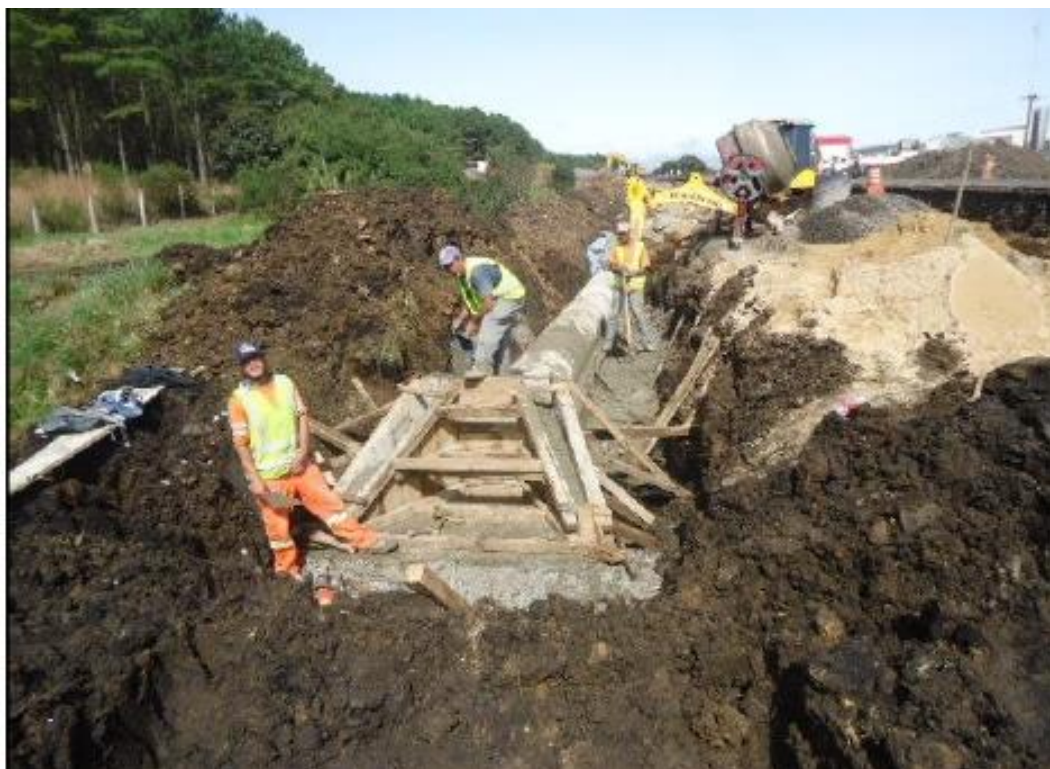
FIGURA ERRO! NENHUM TEXTO COM O ESTILO ESPECIFICADO FOI ENCONTRADO NO DOCUMENTO..12 – CONFEÇÃO DE FORMAS
