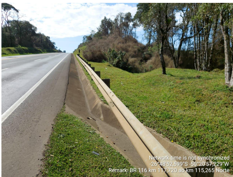
FIGURA ERRO! NENHUM TEXTO COM O ESTILO ESPECIFICADO FOI ENCONTRADO NO DOCUMENTO..38 – DISPOSITIVO DE DRENAGEM E DEFENSA METÁLICA
