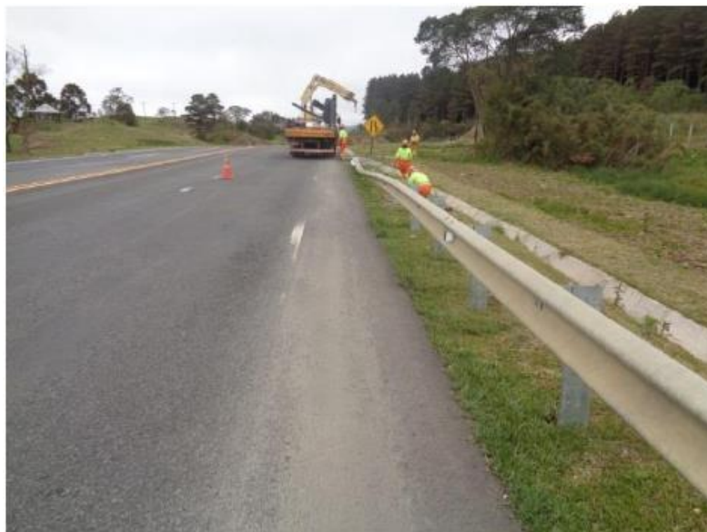
FIGURA ERRO! NENHUM TEXTO COM O ESTILO ESPECIFICADO FOI ENCONTRADO NO DOCUMENTO..25 – EXECUÇÃO DE DEFENSA METÁLICA
