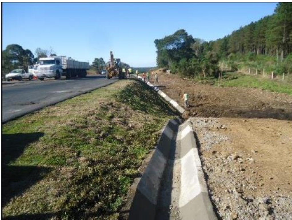
FIGURA ERRO! NENHUM TEXTO COM O ESTILO ESPECIFICADO FOI ENCONTRADO NO DOCUMENTO..16 – EXECUÇÃO DE DISPOSITIVO DE DRENAGEM SUPERFICIAL
