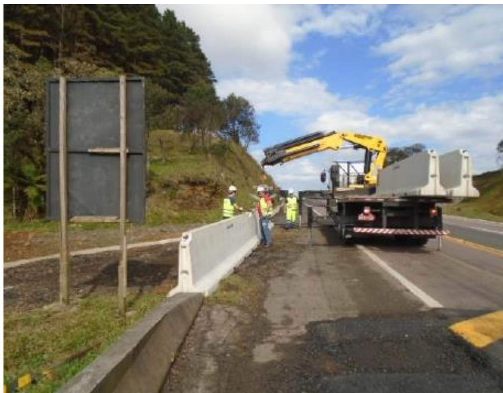
FIGURA ERRO! NENHUM TEXTO COM O ESTILO ESPECIFICADO FOI ENCONTRADO NO DOCUMENTO..24 – EXECUÇÃO DE BARREIRA RÍGIDA
