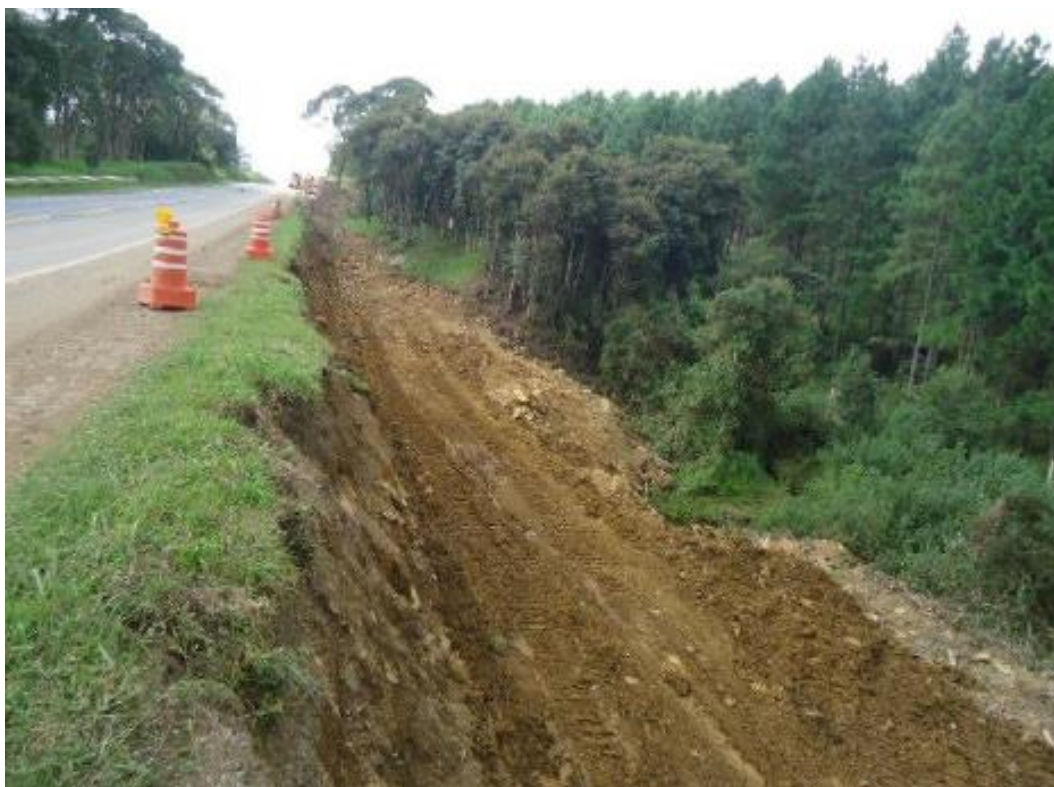
FIGURA ERRO! NENHUM TEXTO COM O ESTILO ESPECIFICADO FOI ENCONTRADO NO DOCUMENTO..6 – ESCAVAÇÃO DE MATERIAL DE 1ª CATEGORIA
