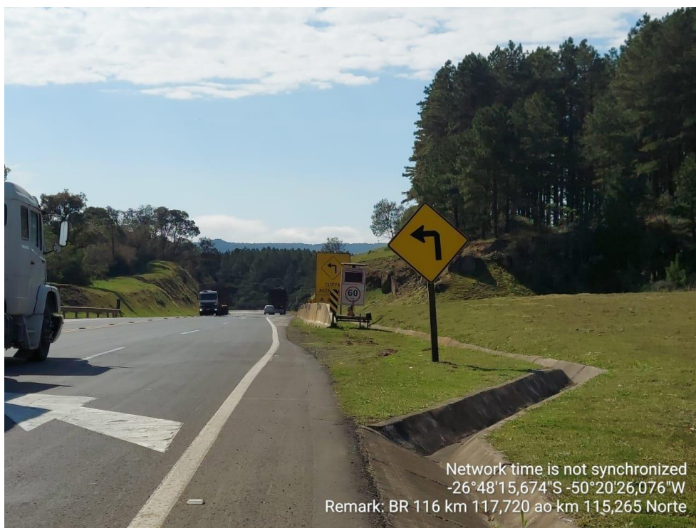
FIGURA ERRO! NENHUM TEXTO COM O ESTILO ESPECIFICADO FOI ENCONTRADO NO DOCUMENTO..41 - SINALIZAÇÃO VERTICAL E HORIZONTAL E DISPOSITIVO DE DRENAGEM
