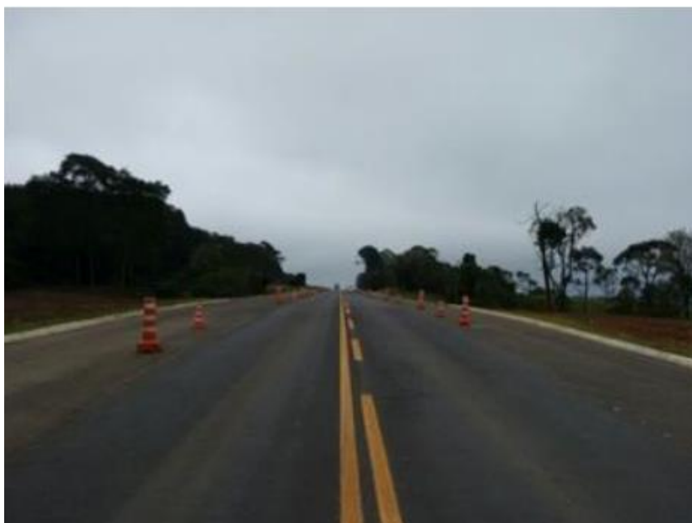
FIGURA ERRO! NENHUM TEXTO COM O ESTILO ESPECIFICADO FOI ENCONTRADO NO DOCUMENTO..23 – EXECUÇÃO DE SINALIZAÇÃO VIÁRIA – SINALIZAÇÃO HORIZONTAL
