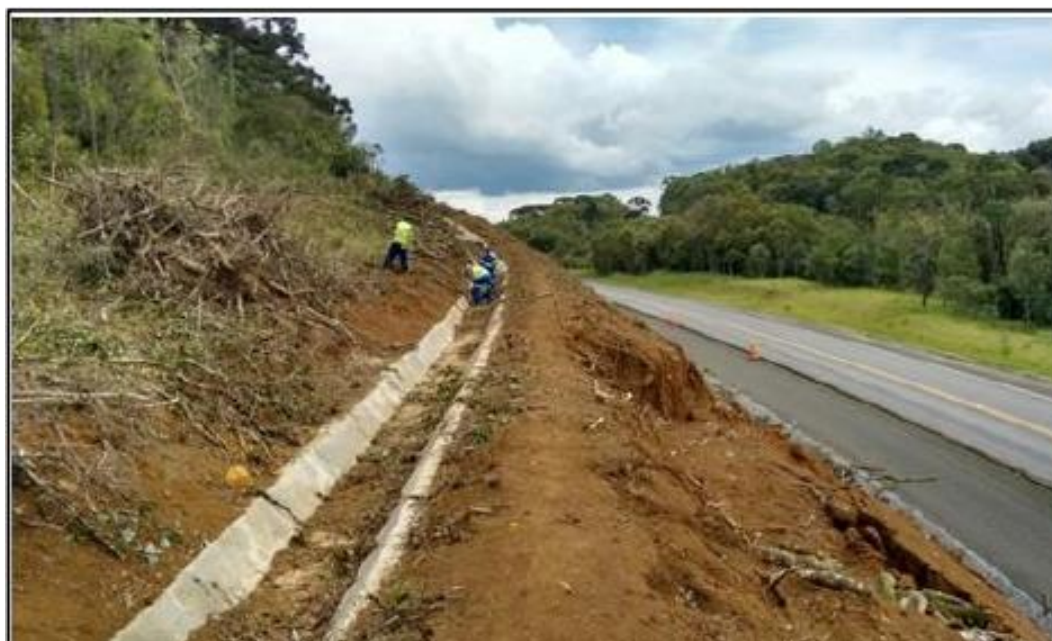
FIGURA ERRO! NENHUM TEXTO COM O ESTILO ESPECIFICADO FOI ENCONTRADO NO DOCUMENTO..3 - SERVIÇO DE LIMPEZA DE DISPOSITIVO DE DRENAGEM
