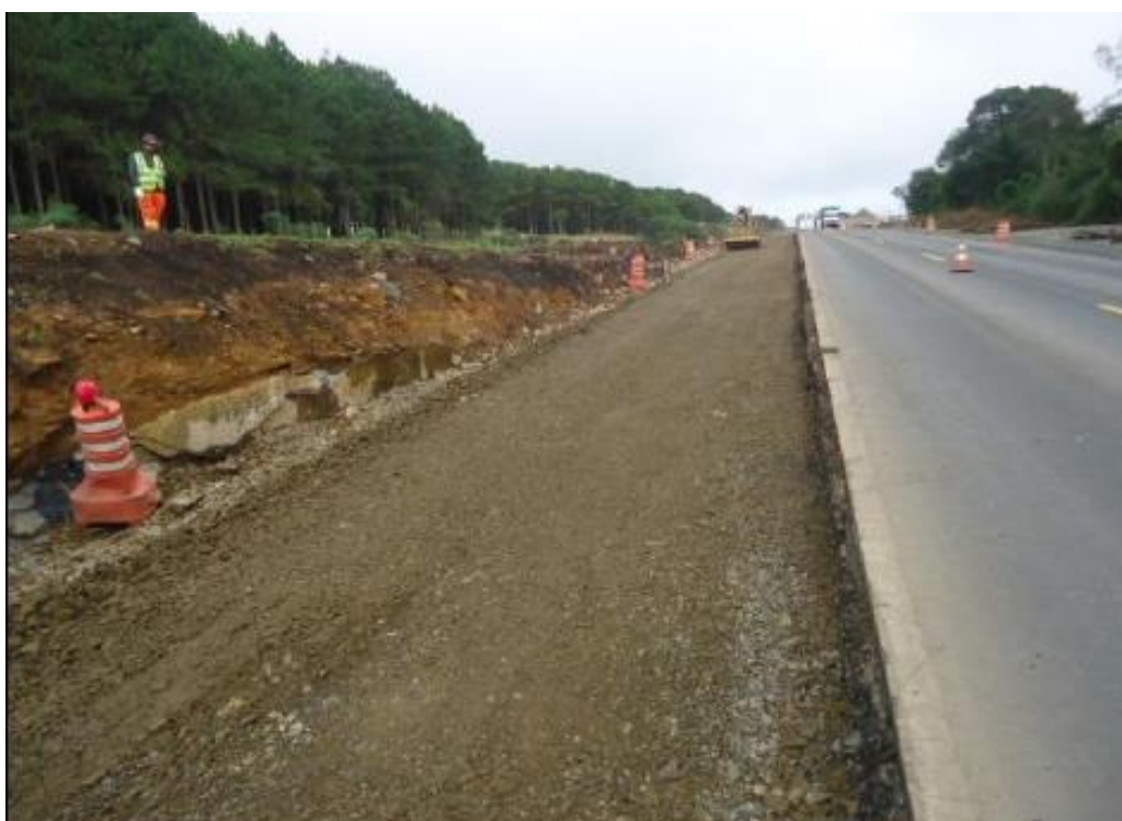
FIGURA ERRO! NENHUM TEXTO COM O ESTILO ESPECIFICADO FOI ENCONTRADO NO DOCUMENTO..19 – EXECUÇÃO DAS CAMADAS DO PAVIMENTO
