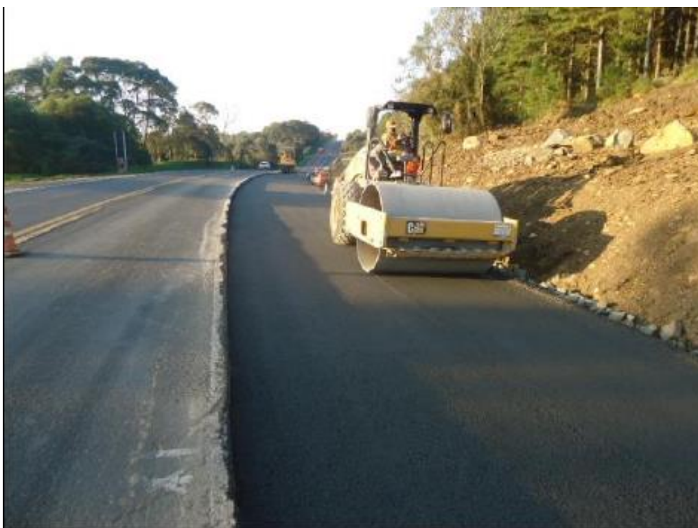
FIGURA ERRO! NENHUM TEXTO COM O ESTILO ESPECIFICADO FOI ENCONTRADO NO DOCUMENTO..20 – EXECUÇÃO DAS CAMADAS DO PAVIMENTO
