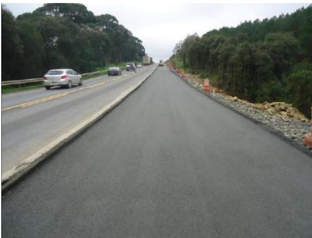
FIGURA ERRO! NENHUM TEXTO COM O ESTILO ESPECIFICADO FOI ENCONTRADO NO DOCUMENTO..21 – EXECUÇÃO DAS CAMADAS DO PAVIMENTO
