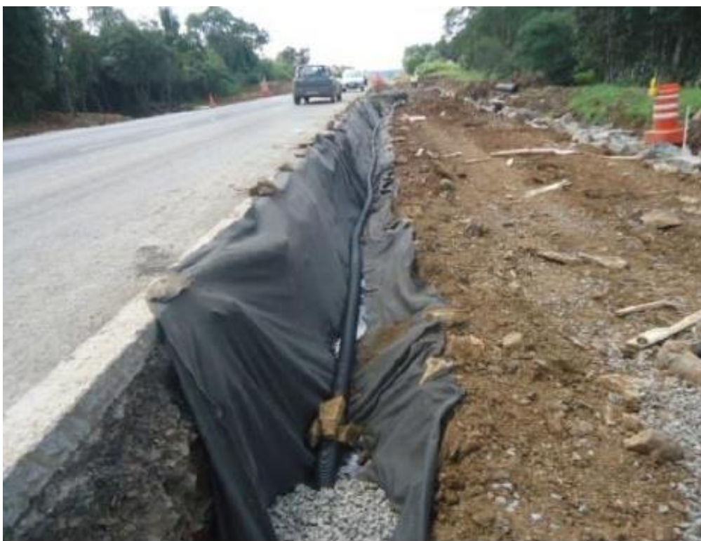
FIGURA ERRO! NENHUM TEXTO COM O ESTILO ESPECIFICADO FOI ENCONTRADO NO DOCUMENTO..11 – MANTA PARA CONSTRUÇÃO DE VALETA
