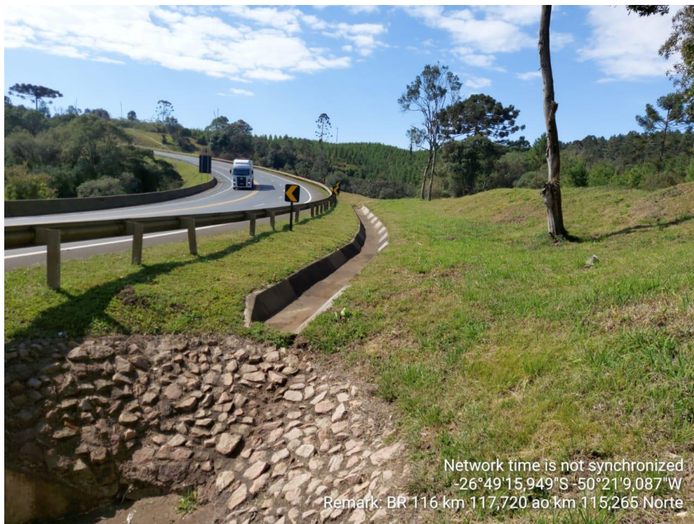
FIGURA ERRO! NENHUM TEXTO COM O ESTILO ESPECIFICADO FOI ENCONTRADO NO DOCUMENTO..38 – DISPOSITIVO DE DRENAGEM E DEFENSA METÁLICA
