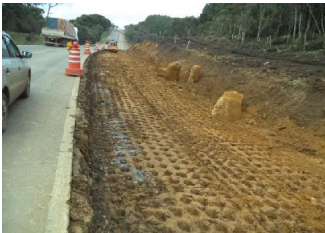
FIGURA ERRO! NENHUM TEXTO COM O ESTILO ESPECIFICADO FOI ENCONTRADO NO DOCUMENTO..7 – COMPACTAÇÃO DO SOLO
