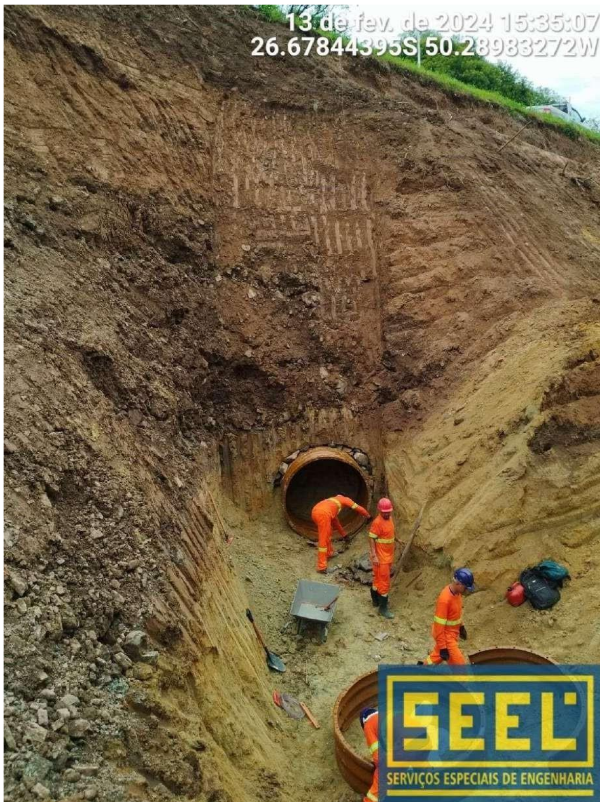
8.2.10 – Escavação do Tunnel liner.
