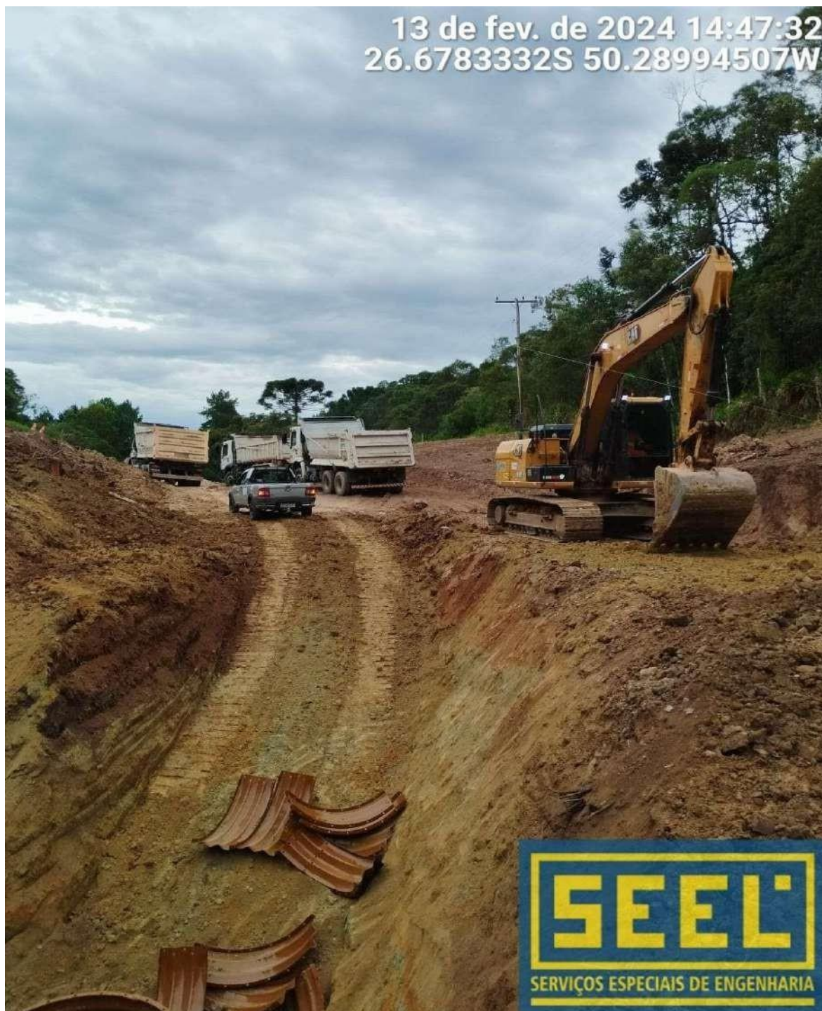
8.2.13 – Deslocamento de material para perfuração.
