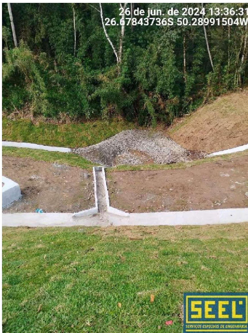
8.5.7 – Acabamento final, demonstrativo de dispositivos de drenagem.
