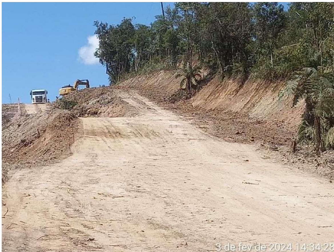
8.2.9 – Retaludamento e destocamento.
