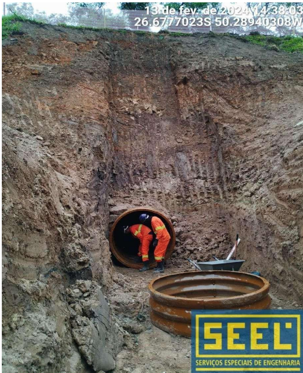
8.2.11 – Escavação do Tunnel liner.
