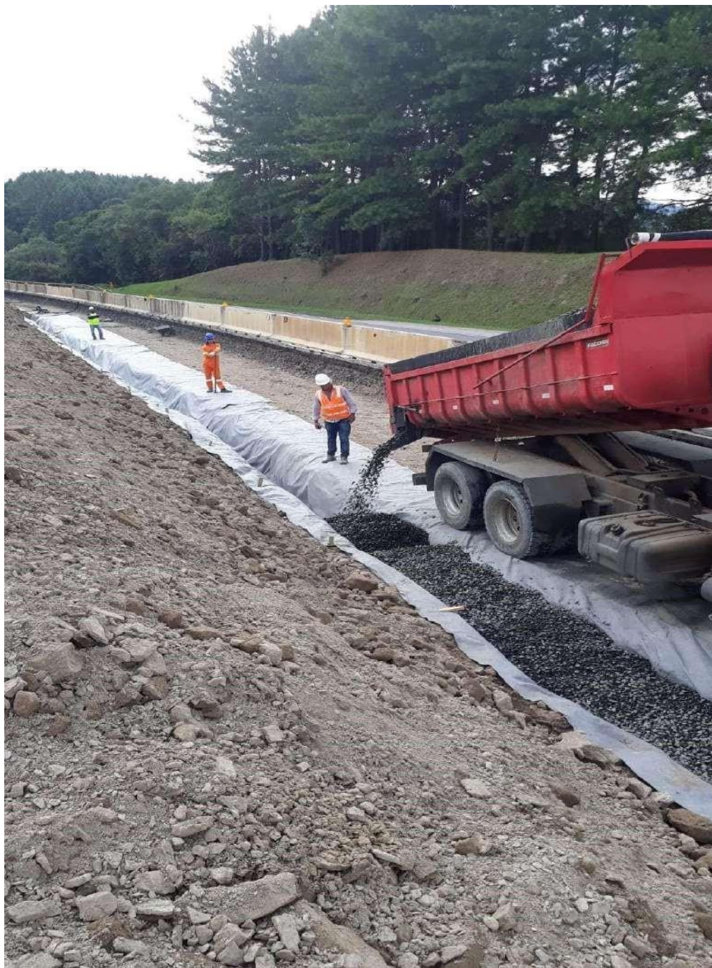
8.2.6- Execução do dreno de bordo de pista
