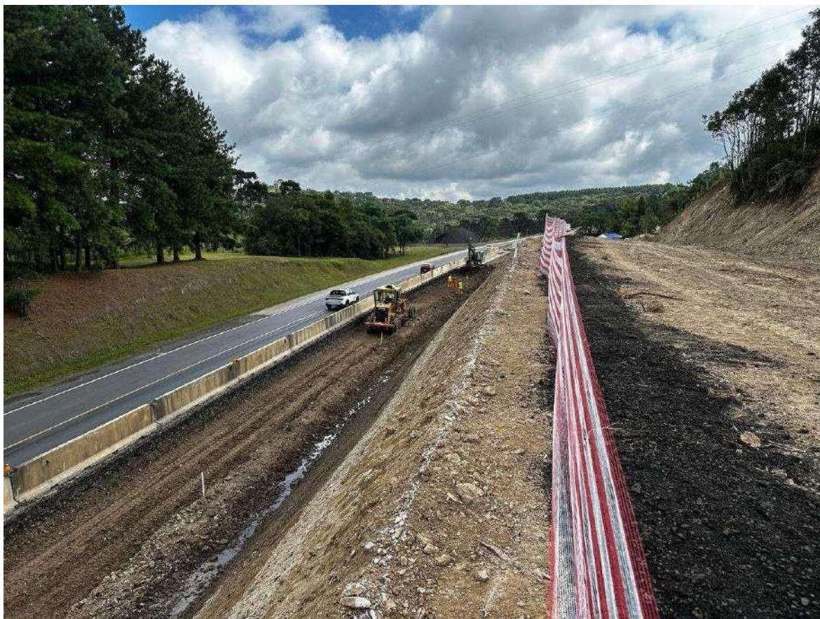
8.2.3– Início da escavação da área a ser pavimentada.
