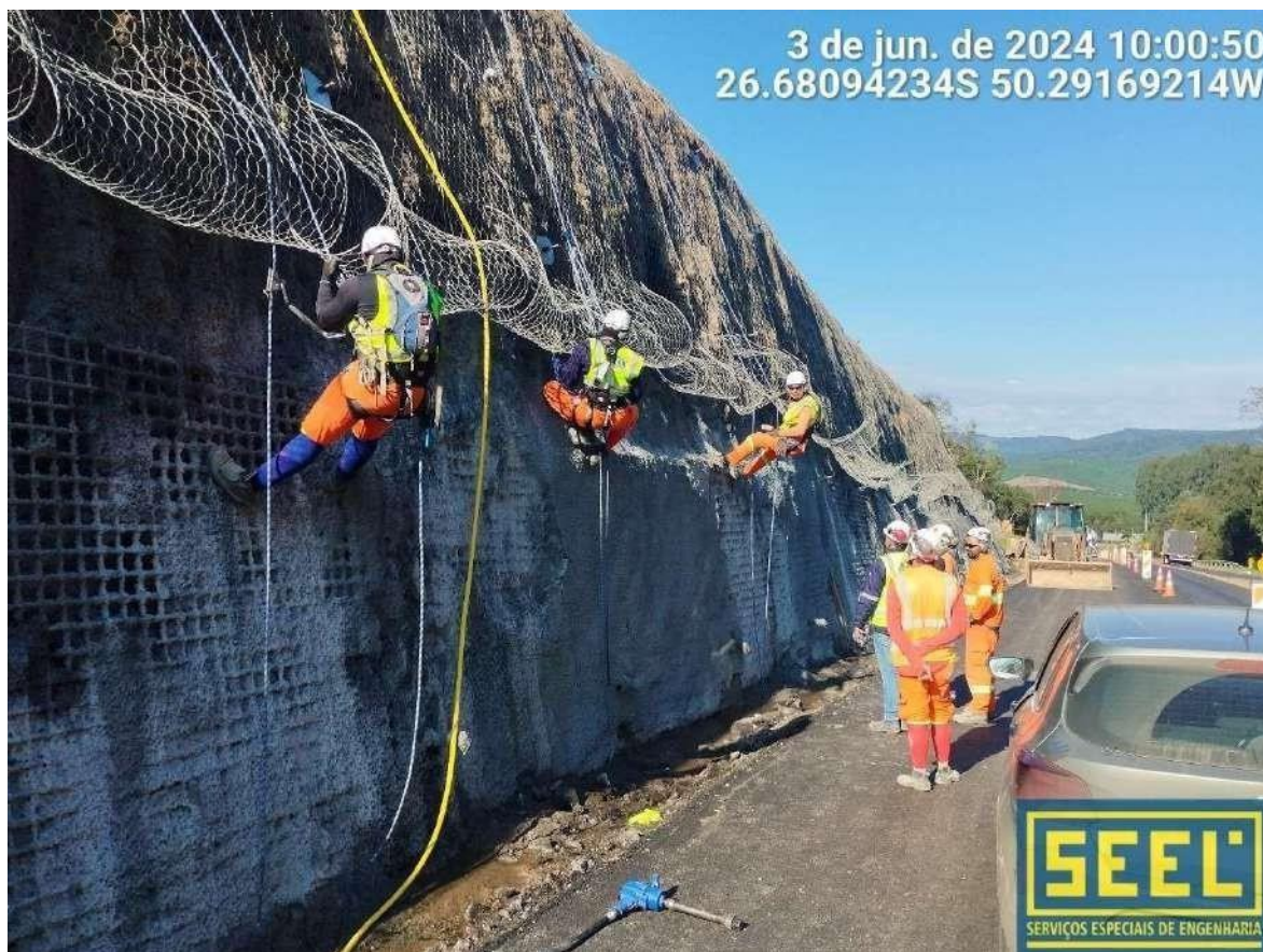
8.4.7– Acabamentos de solo grampeado, trabalho em altura.
