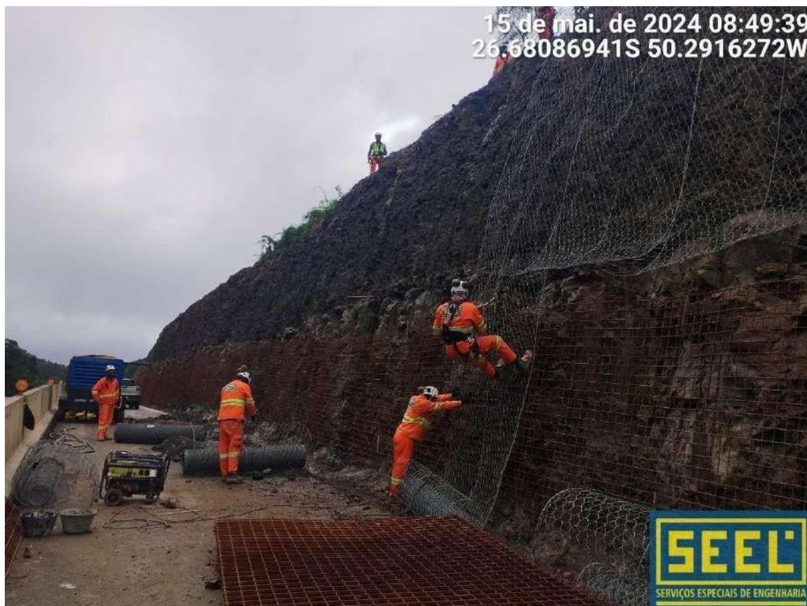
8.4.3- Instalação de telas para realização do concreto projetado.
