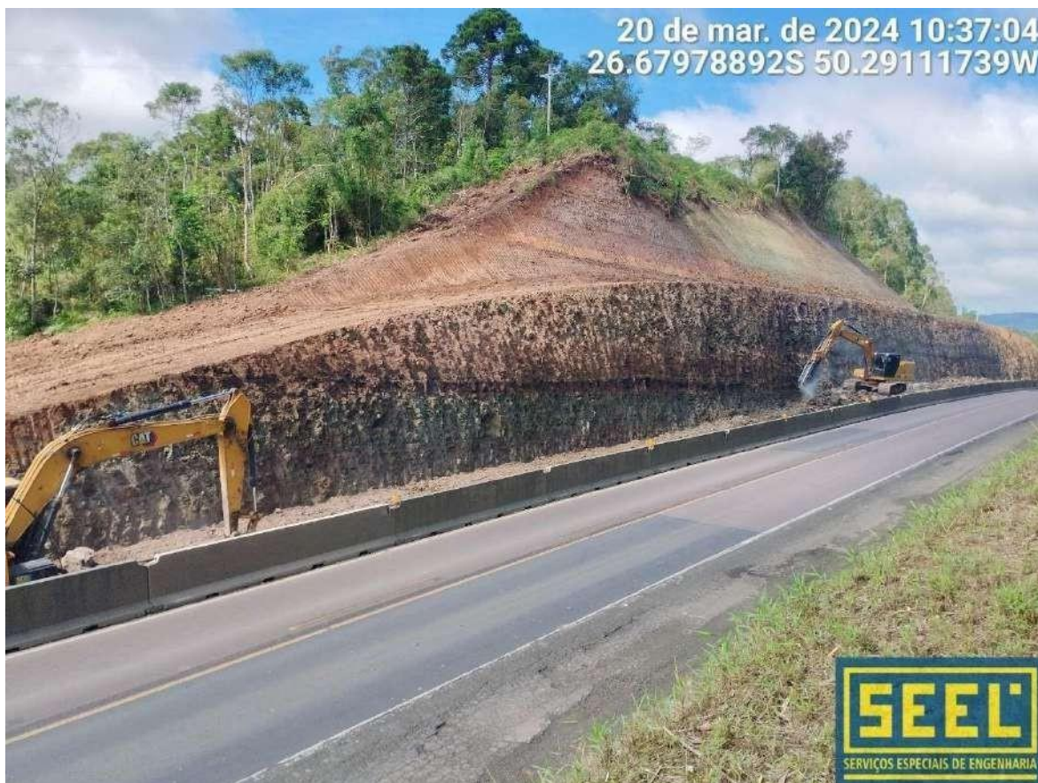
8.3.7 – Preparação de talude para obras de contenção
