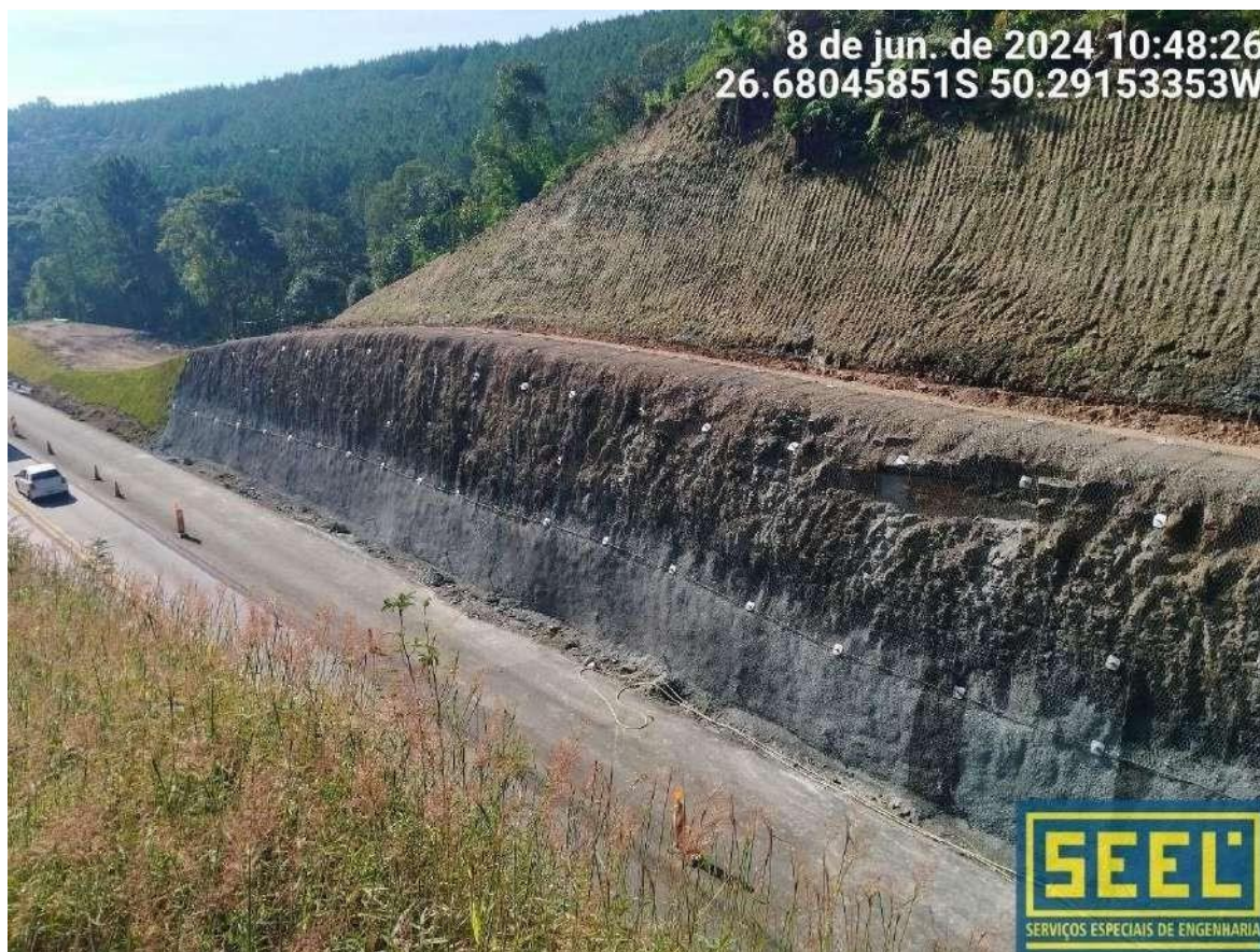
8.4.6- Solo grampeado e projetado executados.
