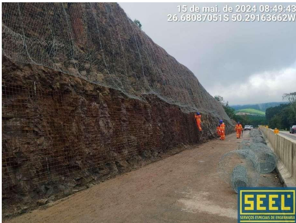
8.4.4- Instalação de telas para realização do concreto projetado e também telas de perfuração.
