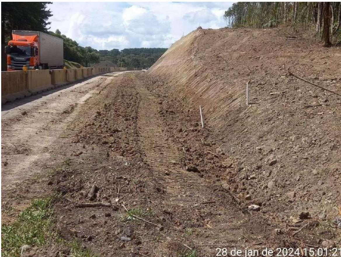
8.2.1- Marcação Topográfica da área de pavimento e início do talude.
