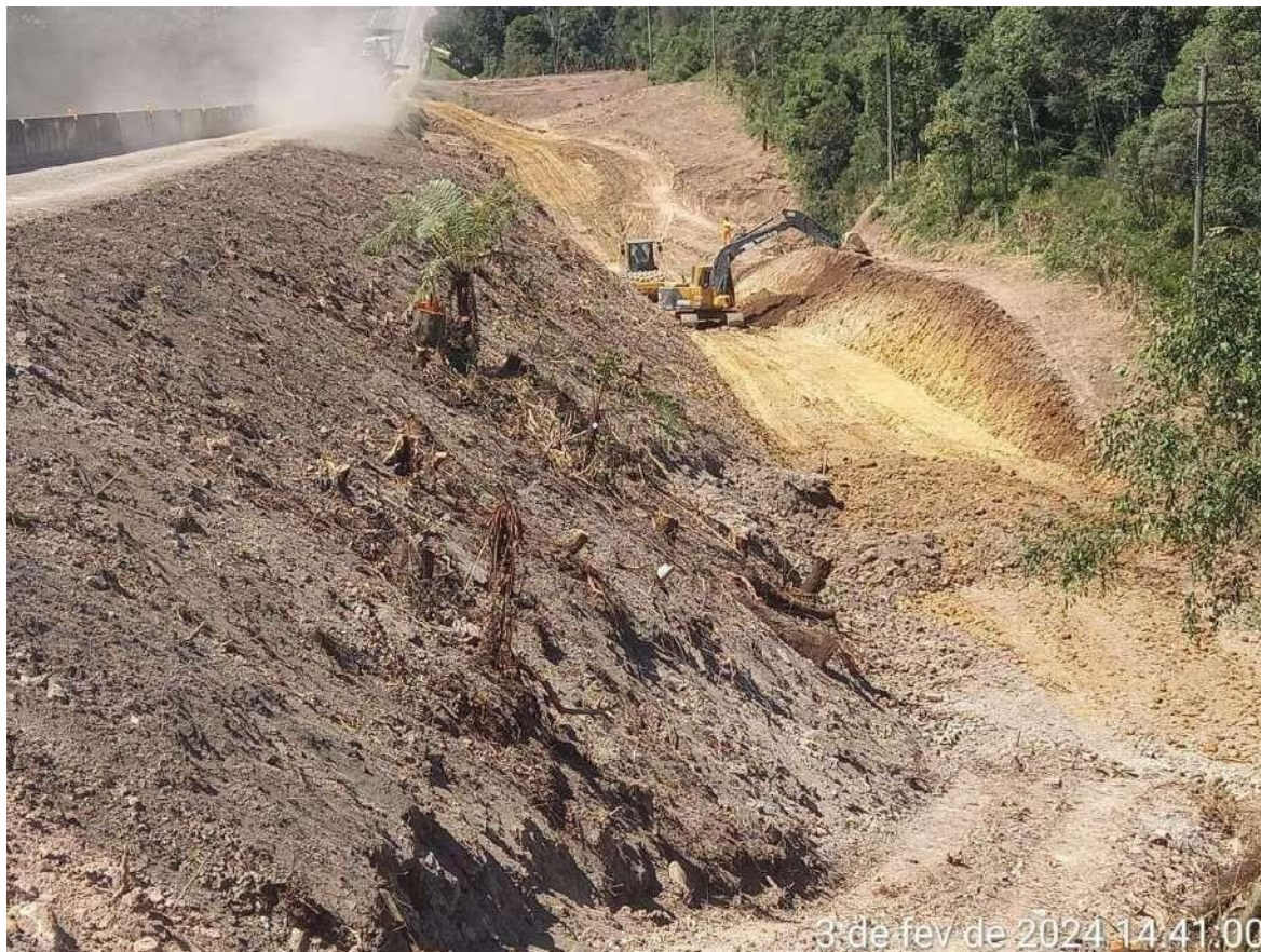
8.2.7 – Correções de terraplenagem
