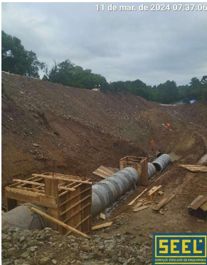
8.3.5 – Execução de desníveis, para poços de visita.
