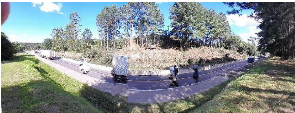
8.1.2- Retirada de árvores e material verde do local da obra.
