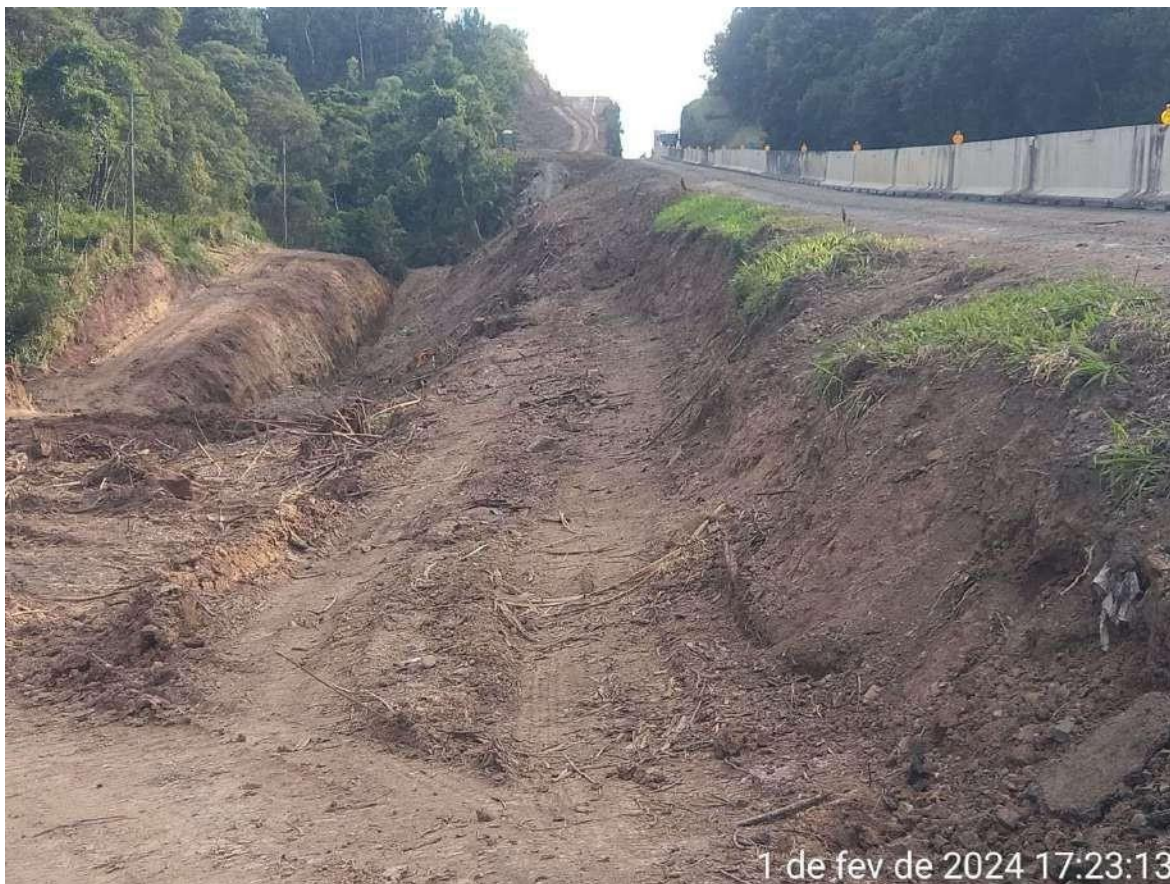
8.2.4– Início da escavação para drenagem profunda.
