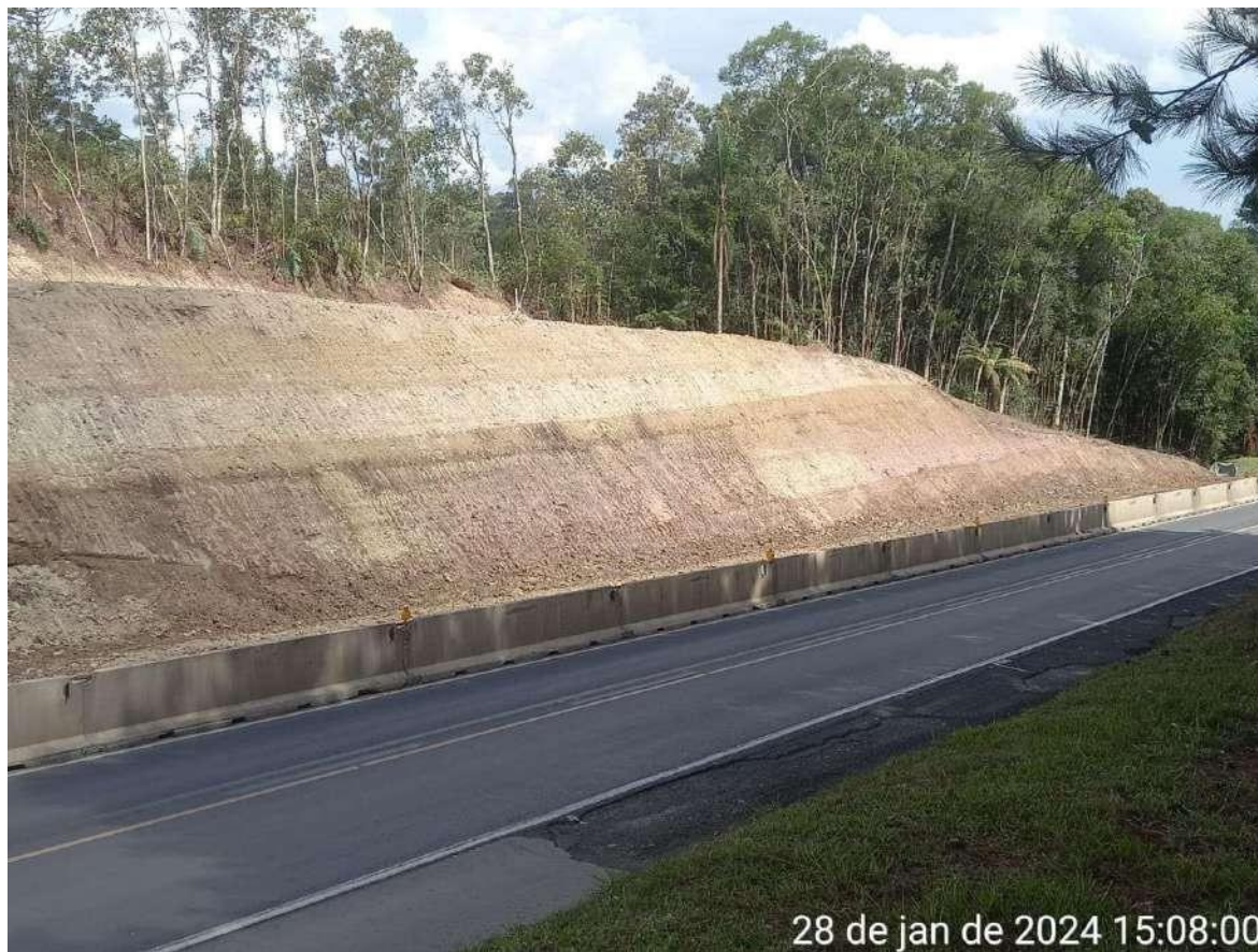
8.2.2- Terraplanagem inicial do talude.
