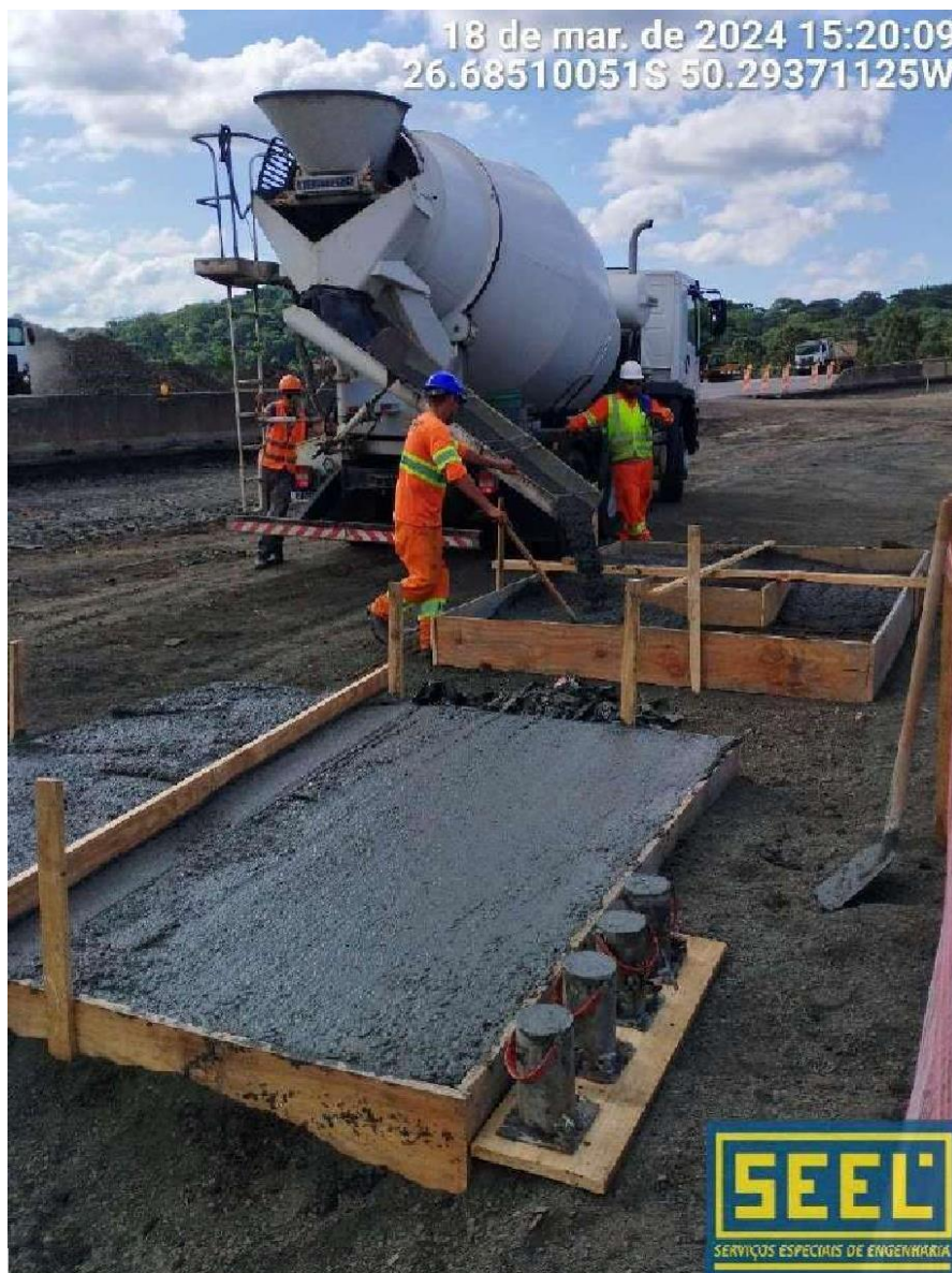
8.3.8 – Concretagem da tampa do poço de visita.
