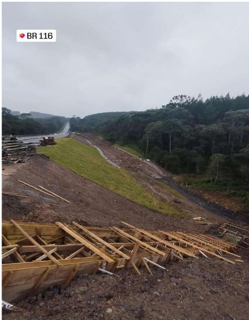
8.3.11 – Execução de escada de drenagem, e plantio de grama.
