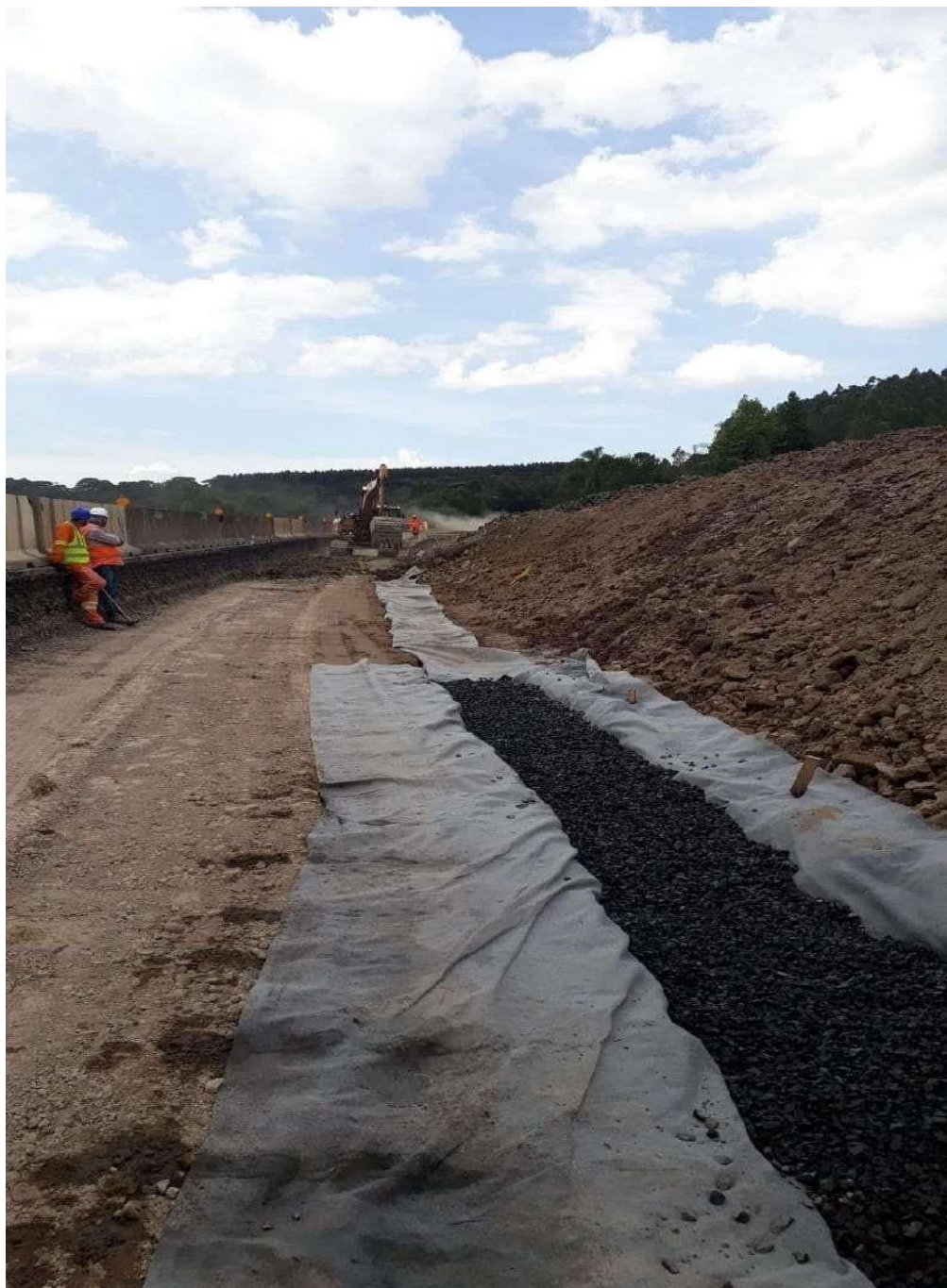
8.2.5- Execução do dreno de bordo de pista
