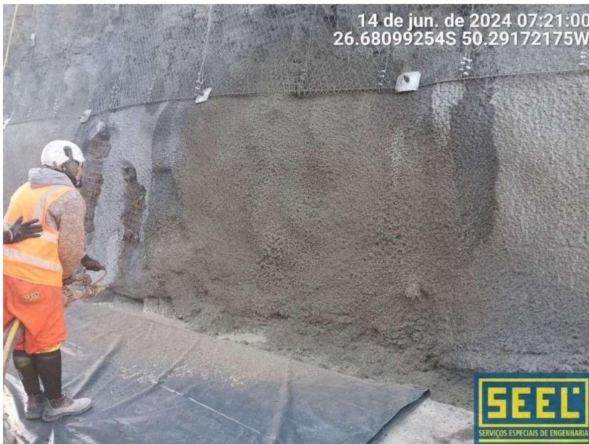
8.4.8– Execução do concreto projetado.
