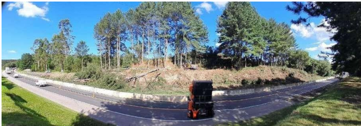
8.1.1- Retirada de árvores do local da obra.
