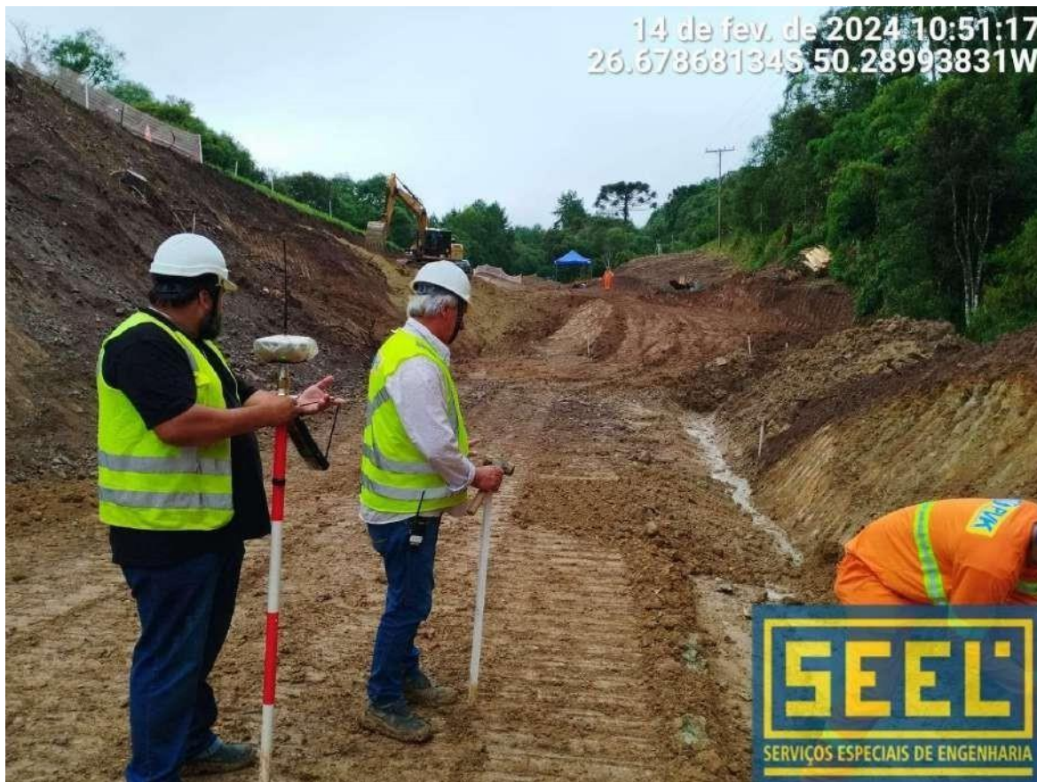
8.2.12 – Marcação topográfica para drenagem profunda.
