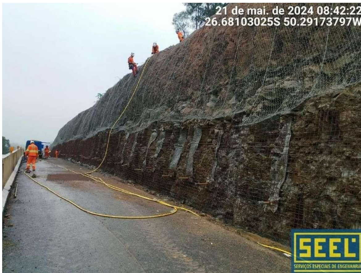
8.4.5- Instalação de telas do solo grampeado.
