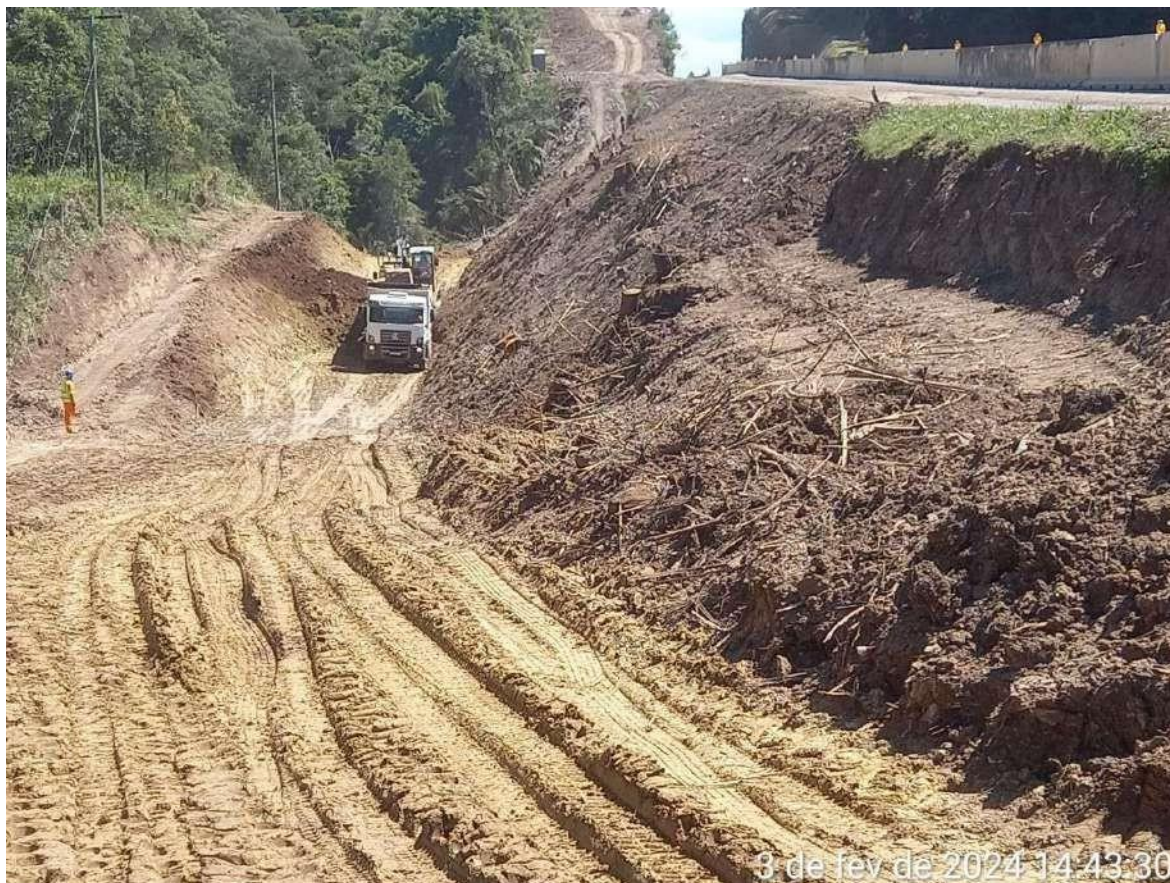
8.2.8 – Retirada de material.
