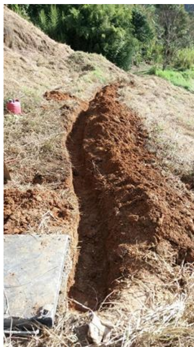
Figura 58 - Abertura de valeta para passagem de cabeamento até o poste
