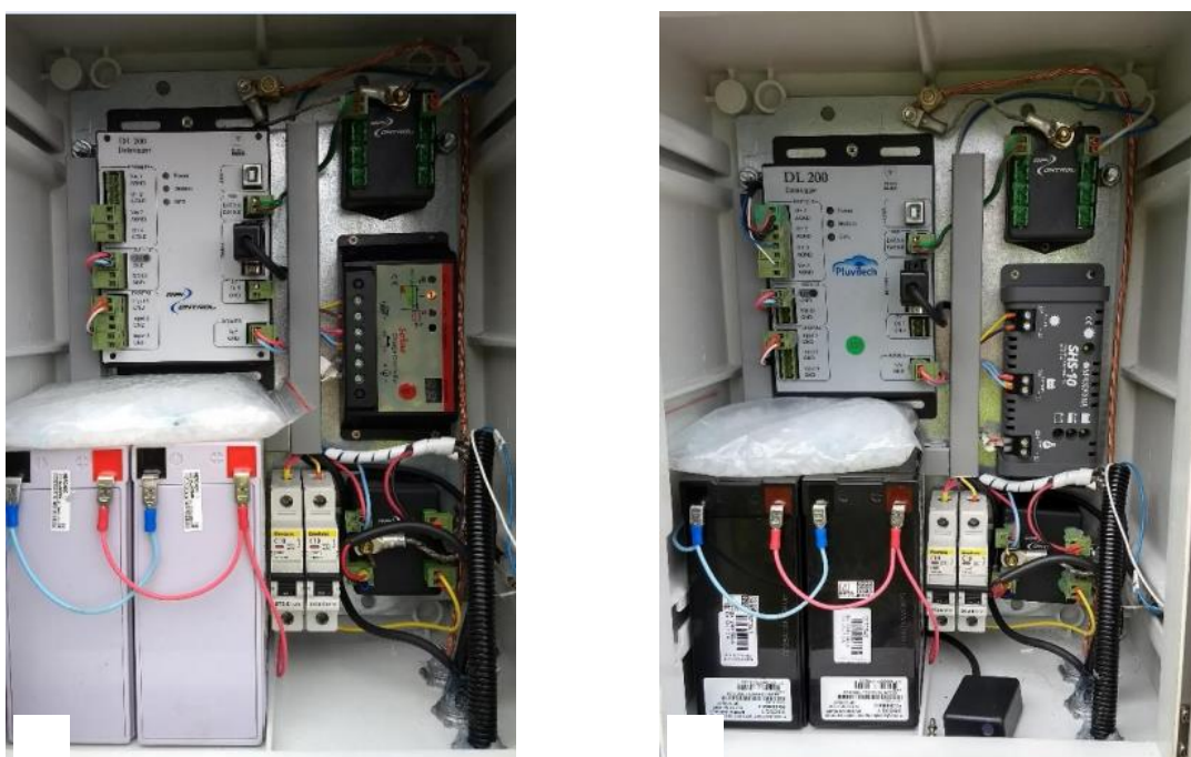
Figura 63- Intervenção na estação pluviométrica km P552 PN: (Antes) (a); Depois (b)
