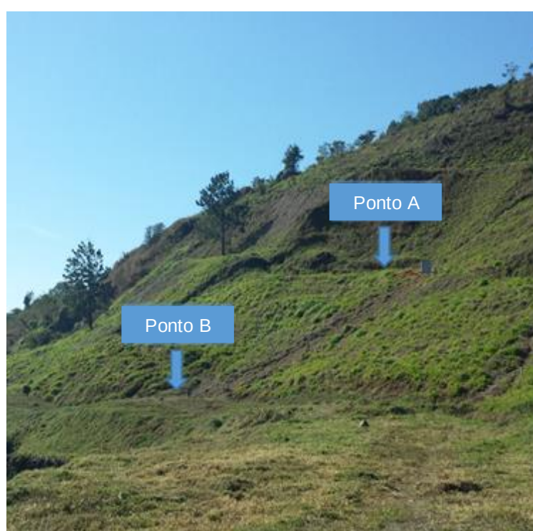
Figura 36 - Locais de realização do ensaio de permeabilidade in situ
