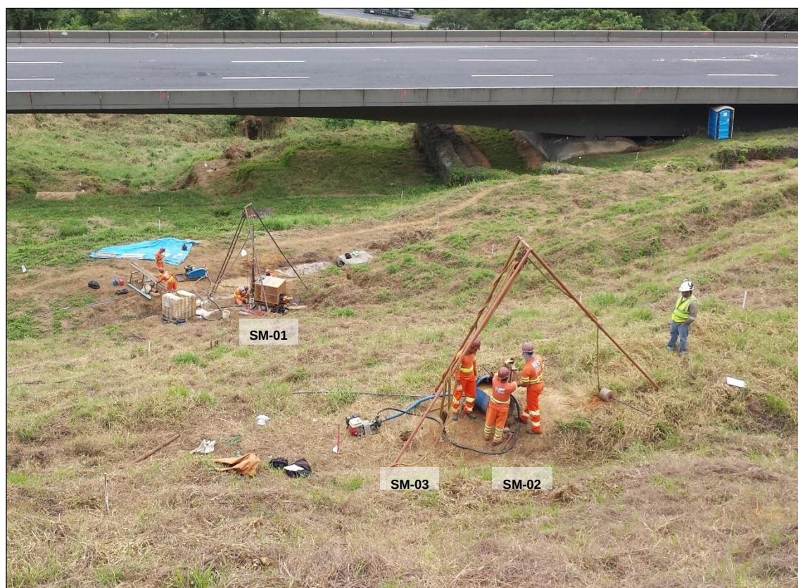
Figura 34 - Sondagens SM-01, SM-02 e SM-03 sendo realizadas no km P 552 PN
