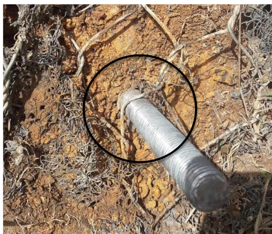
Figura 160 – Contato da tela metálica com o grampo
