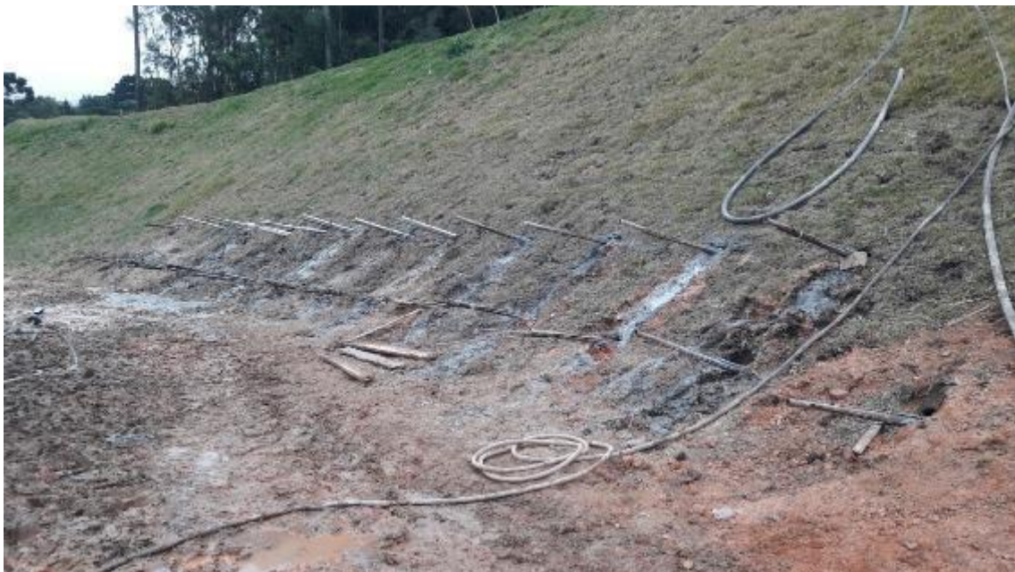
Figura 95 – Vista geral da cortina atirantada
