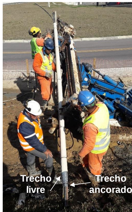
Figura 84 - Execução da monobarra com bainha coletiva
