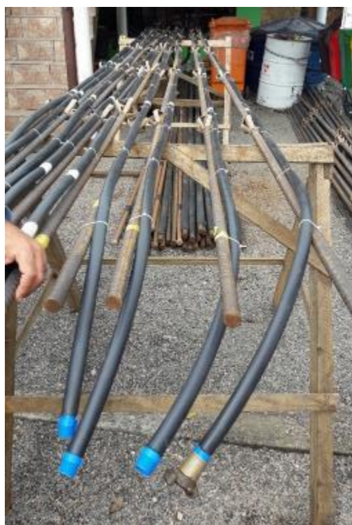
Figura 72 – Grampos com tubo de reinjeção
