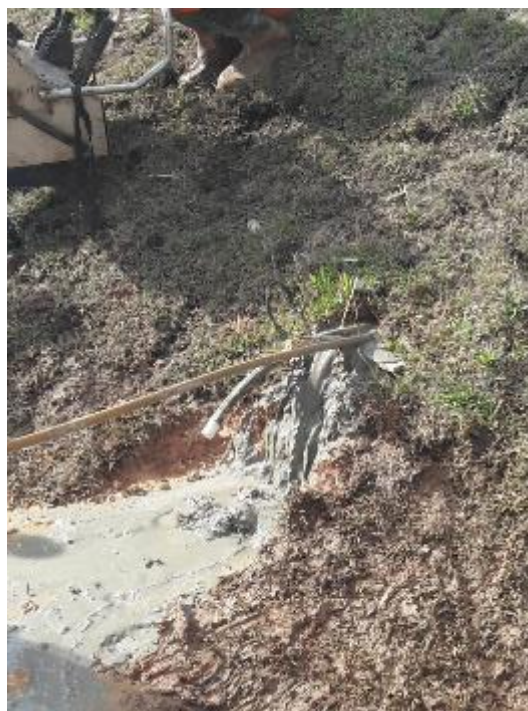
Figura 71 – Injeção da bainha no solo grampeado
