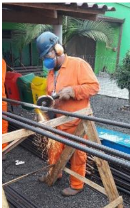
Figura 85 – Execução da redução de seção da monobarra
