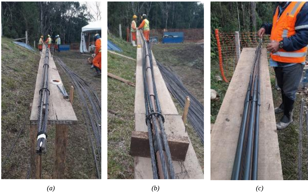
Figura 88 – Montagem do tirante com cordoalha: (a) Final do tirante, (b) Passagem do trecho ancorado para o trecho livre e (c) Início dos tirantes
