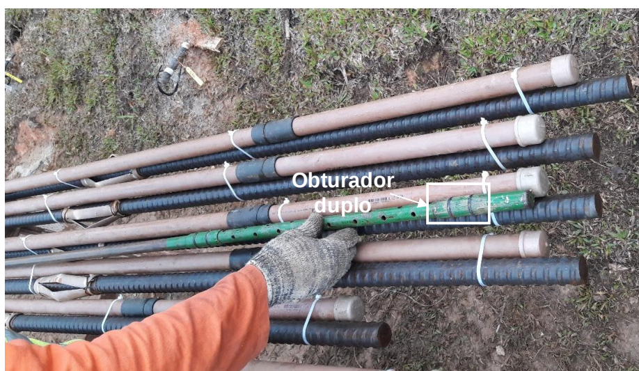
Figura 82 – Reinjeção dos tirantes
