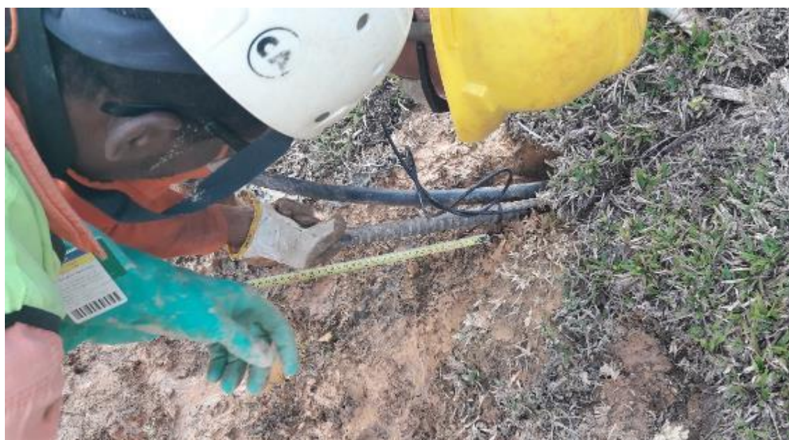
Figura 70 - Medição de 20 cm do grampo para fora do terreno
