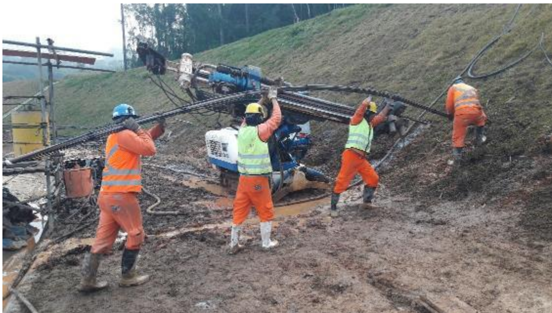
Figura 93 - Execução do tirante de fio
