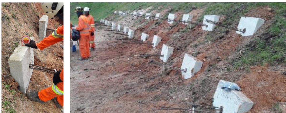
Figura 98 – Posicionamento das placas de concreto
