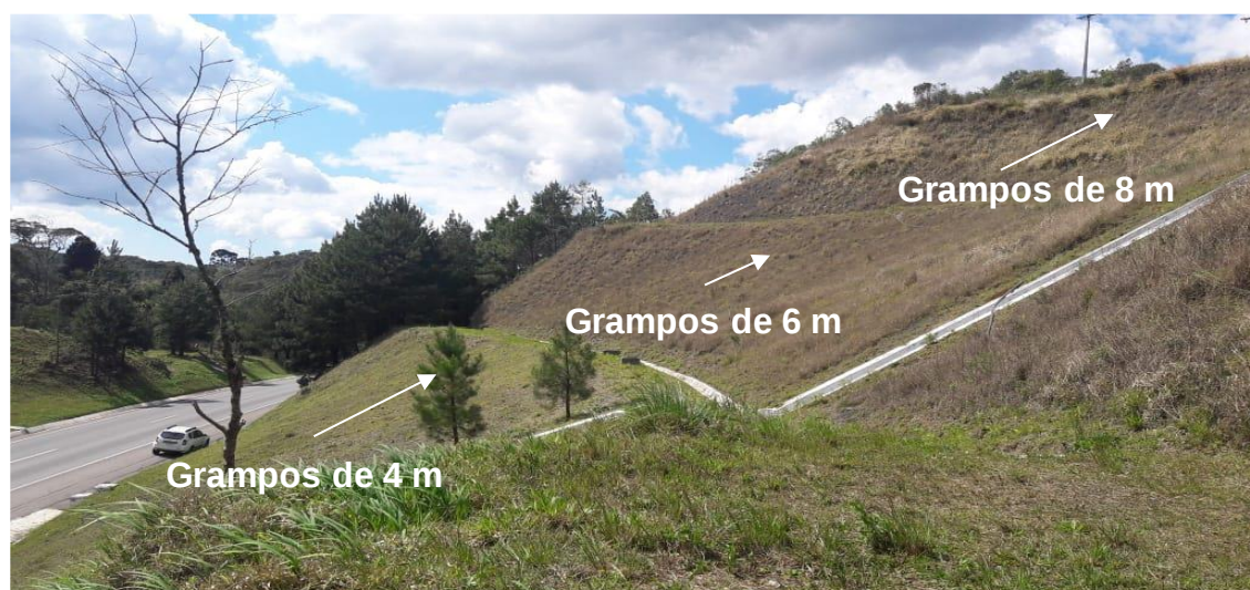
Figura 157 – Contenção km 658+400, pista Sul
