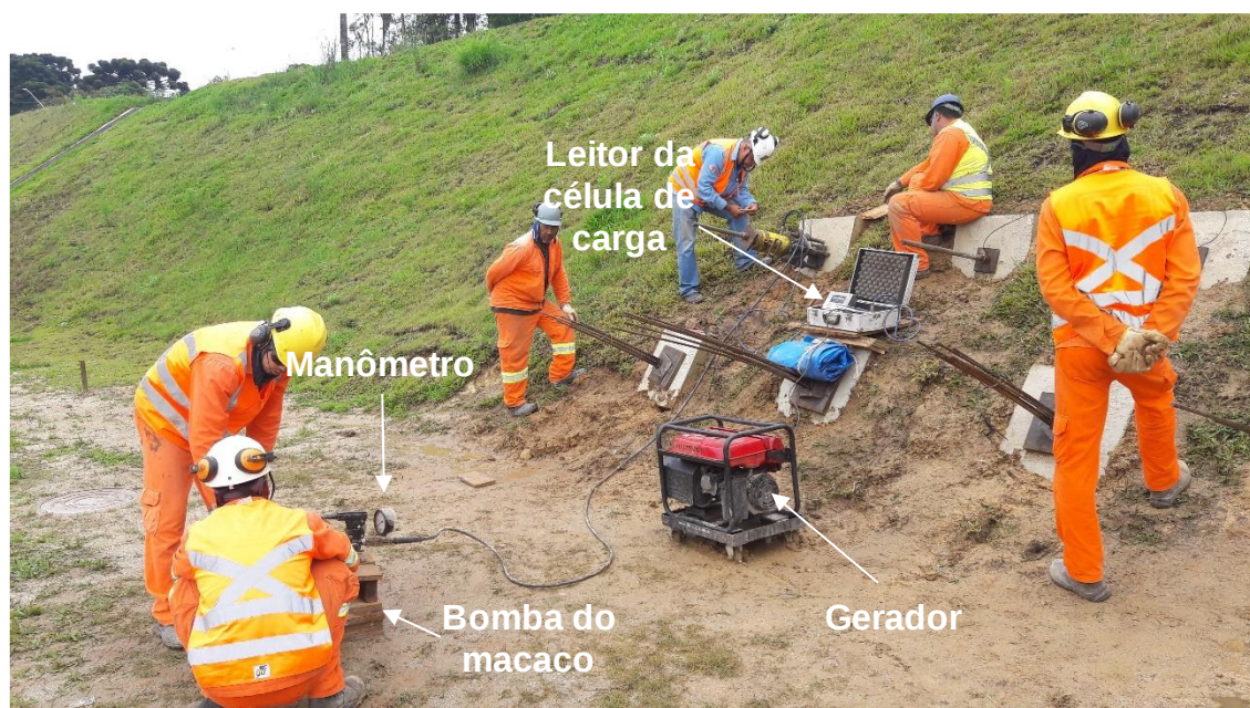
Figura 101 - Equipamento utilizados na protensão
