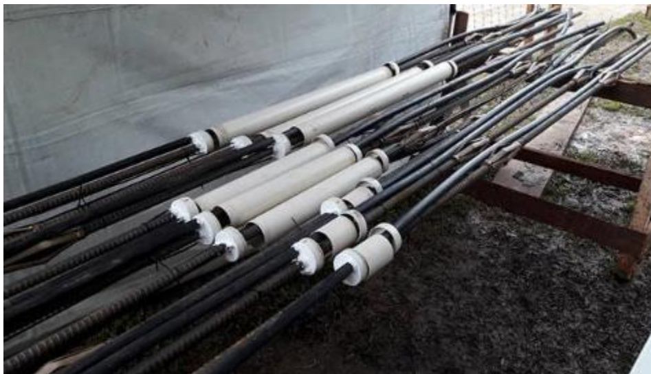
Figura 79 – Montagem das falhas com ar nos grampos
