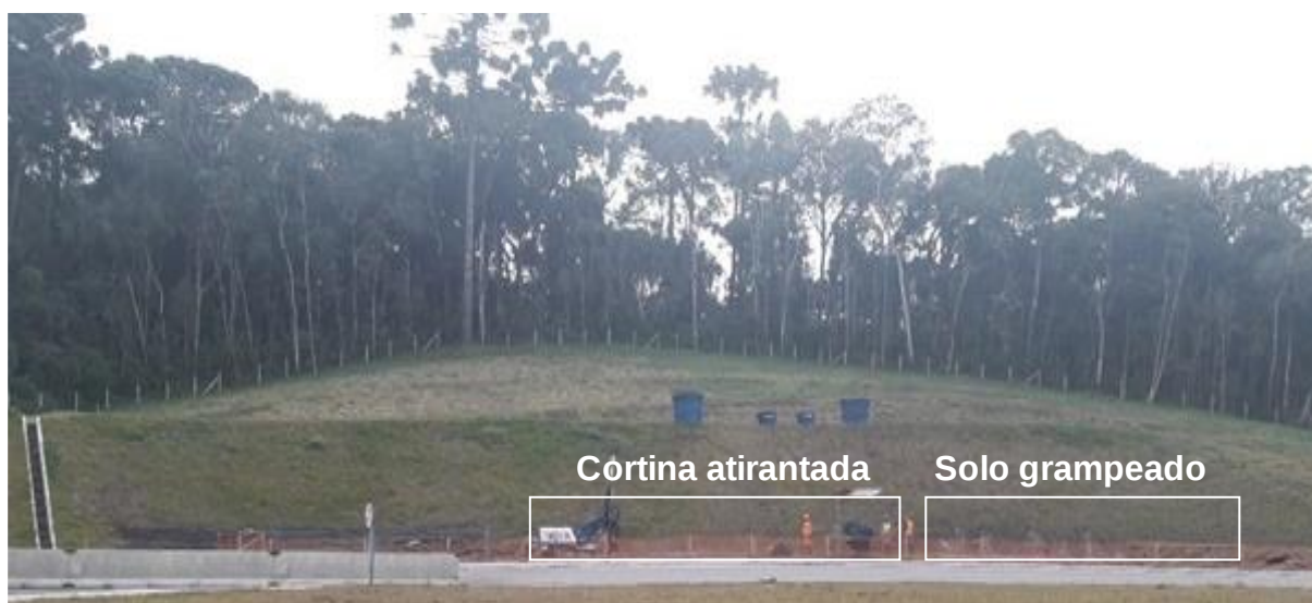
Figura 106 - Vista frontal: Posicionamento das contenções
