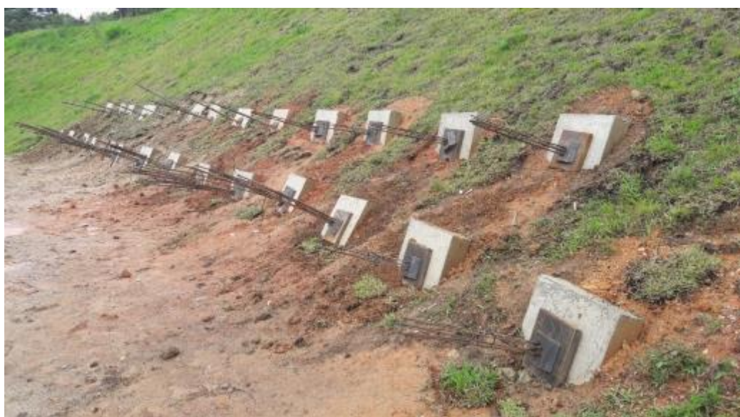
Figura 105 – Vista da área ao final da protensão dos tirantes
