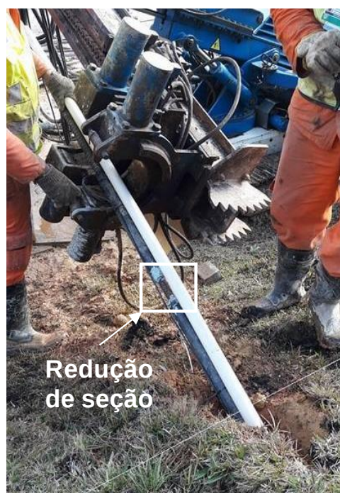
Figura 87 - Instalação das monobarras com redução de seção no furo
