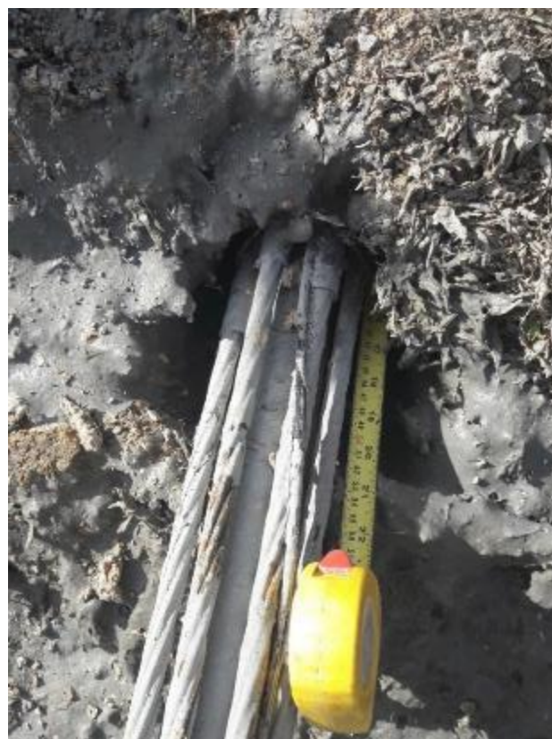
Figura 89 – Falha no início do furo com 50 cm de ar
