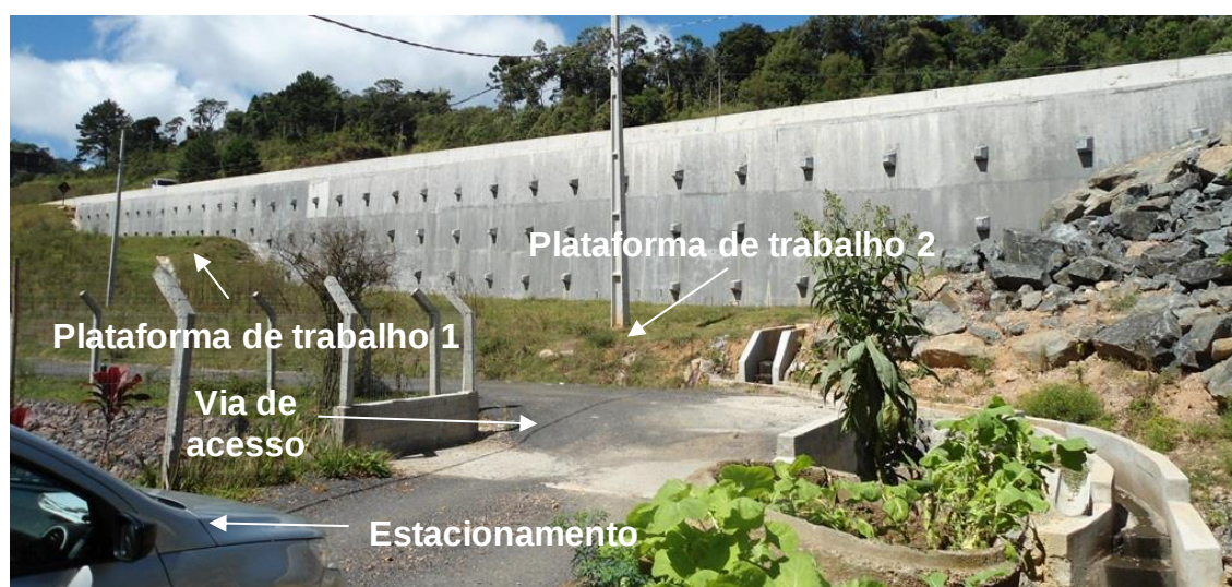
Figura 162 – Face da contenção km 650+940, pista Norte
