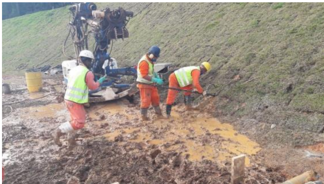
Figura 69 - Instalação da barra dentro da perfuração
