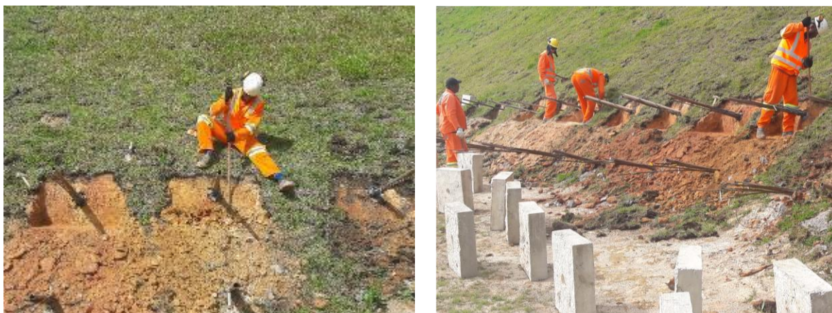
Figura 97 – Preparação do talude para colocação das placas de concreto
