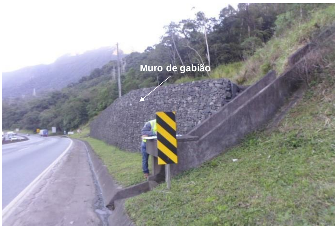
Figura 19 - Soluções mistas de contenção no km 669+290 m: solo grampeado, cortina atirantada e muros de gabião
