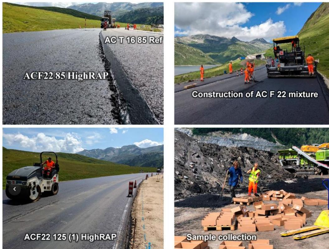
Figura 15 – Construção da seção teste no Passo de Lukmanier (Fonte: Zaumanis *et al.* (2024))
