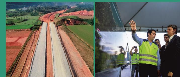
Ministro Tarcísio em visita às obras do Contorno na região entre São José-SC e Biguaçu-SC
