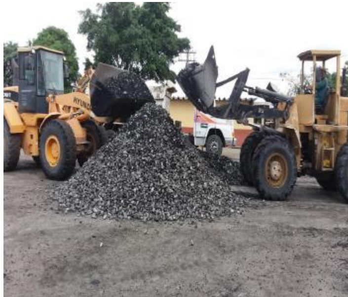
Figura 5 – Homogeneização da mistura
