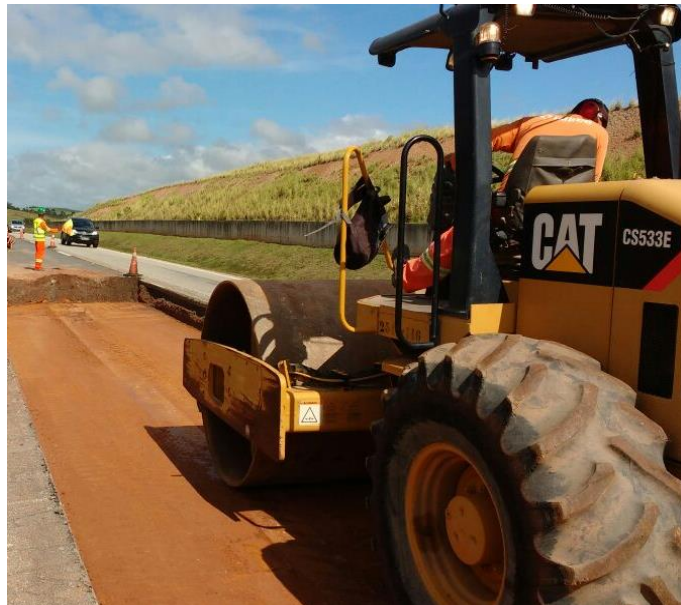
Figura 7 – Selando o subleito
