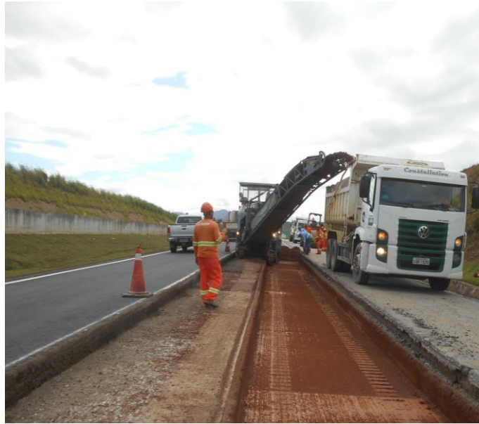
Figura 6 – Fresagem da base / sub-base
