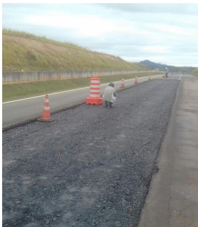
Figura 12 – MBT imprimado
