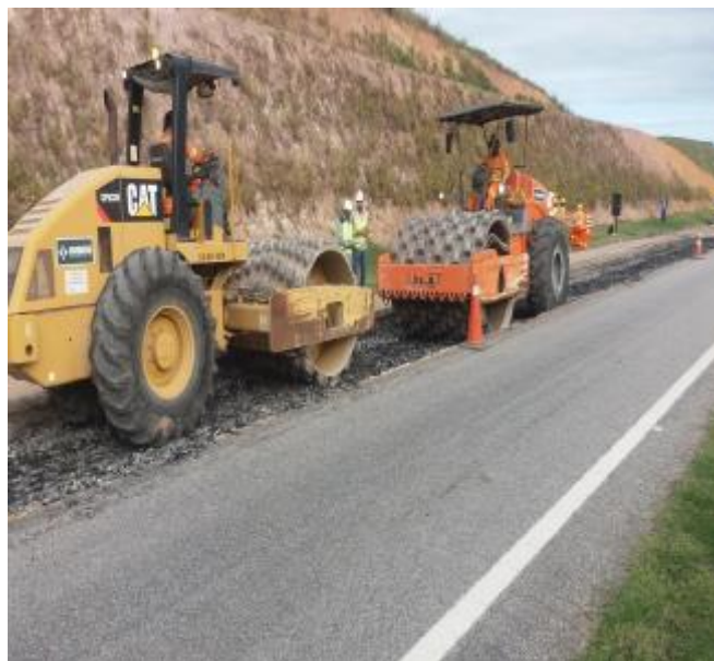
Figura 10 – Compactação da 1 camada
