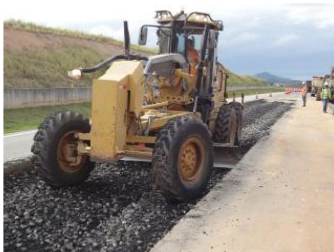
Figura 9 – Nivelamento da camada
