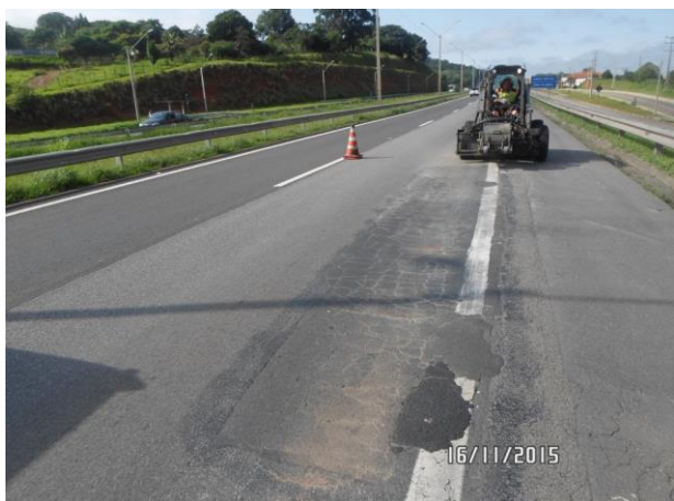
(i) Seleção do segmento comprometido
