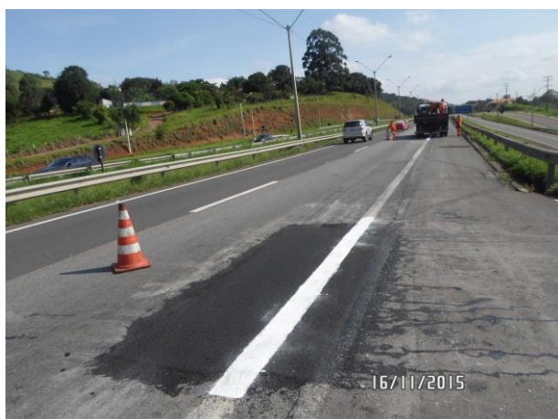
(v) Acabamento final e sinalização horizontal
