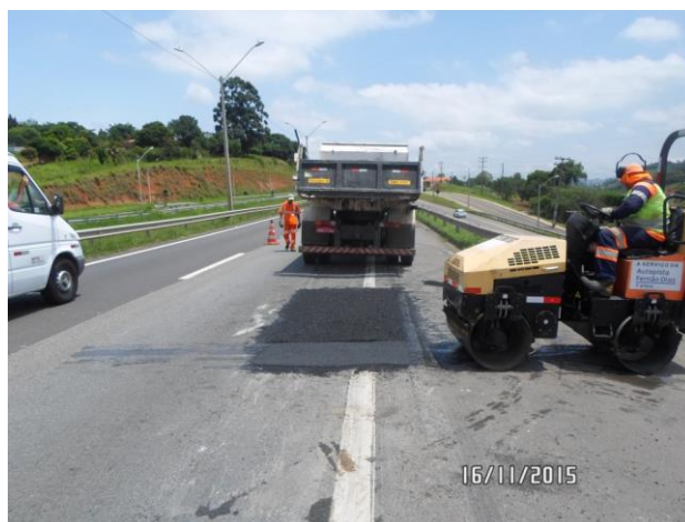
(iv) Compactação com CG-11
