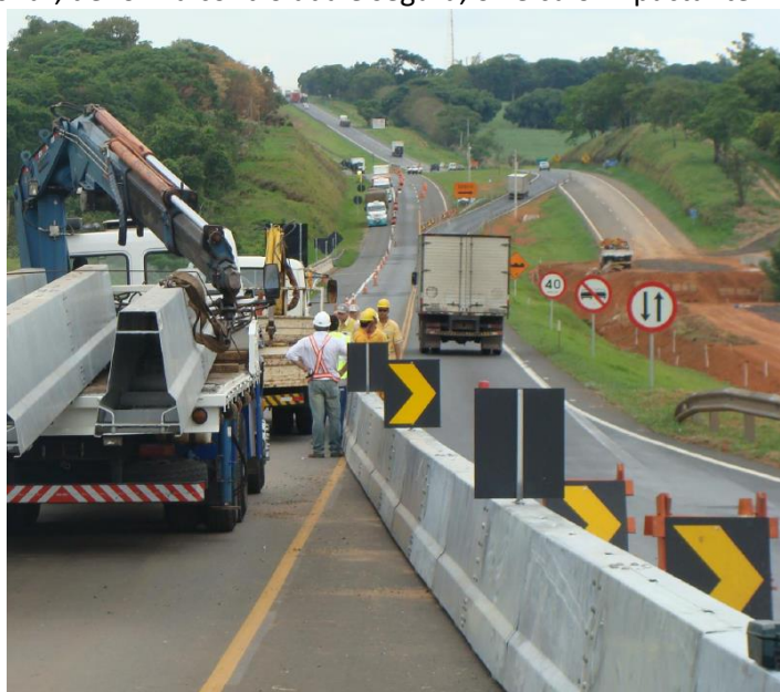
Figura 33.: Exemplo de Barreira provisória para separação de fluxo bidirecional em desvio
