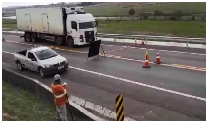
Figura 36.: Exemplo da aplicação de lombadas móveis
