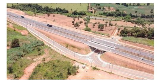
A Arteris Fernão Dias concluiu, no dia 15 de dezembro, a obra realizada no km 515 da rodovia BR-381, região de Igarapé (MG). O trevo em desnível construído no local garante facilidade de manobra de retorno para os usuários, encurtando um trajeto de cerca 10km, considerando ida e volta, pelo trecho da Serra de Igarapé, além de aumentar a segurança no trecho.
